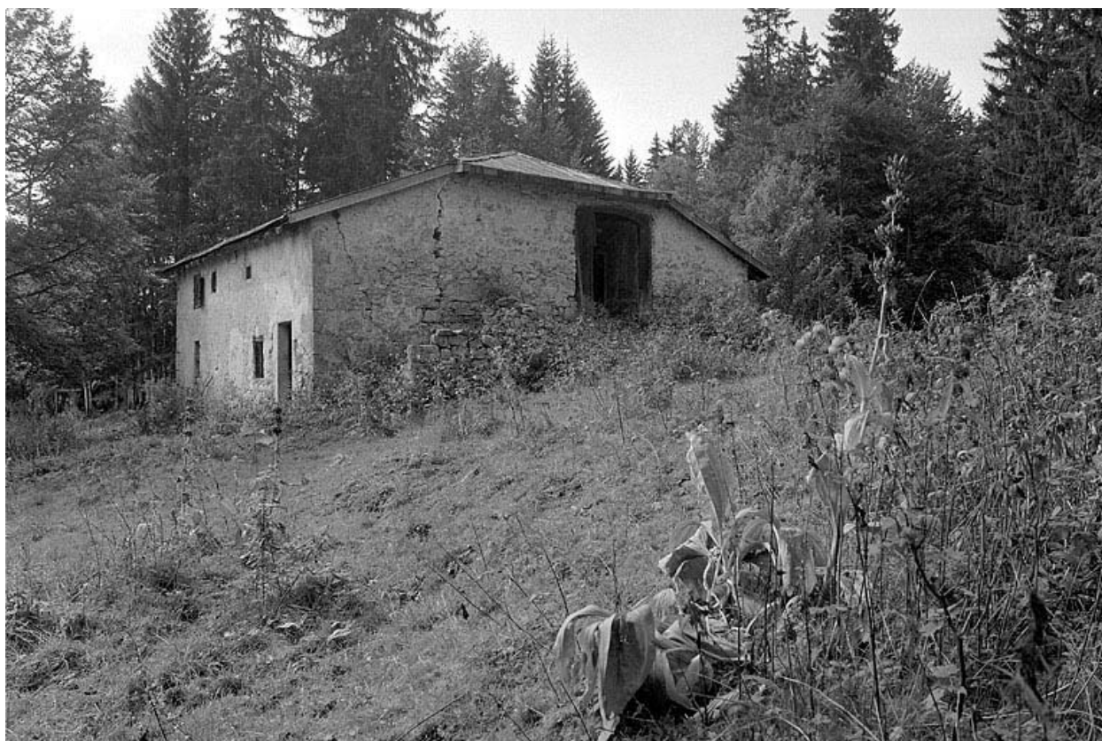
Face nord-est et grange haute.
