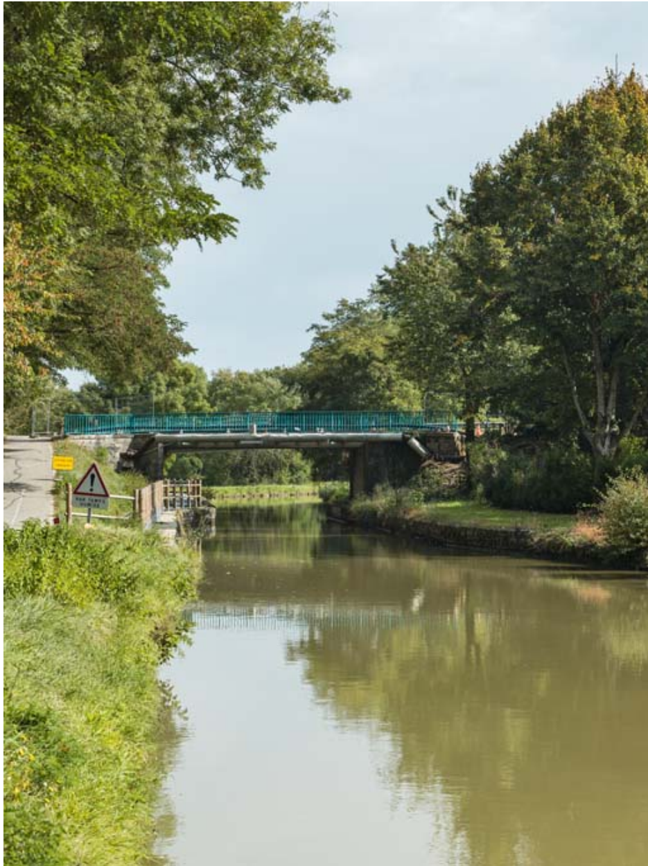
Vue d'ensemble du pont.
