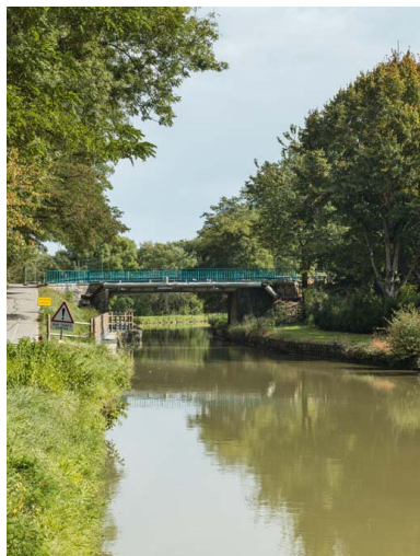
Vue d'ensemble du pont. Phot. Pierre-Marie Barbe-Richaud IVR26_20172100609NUC2A
