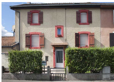
Détail d'une façade antérieure. Phot. Jérôme Mongreville IVR43_20112502195NUC4A
