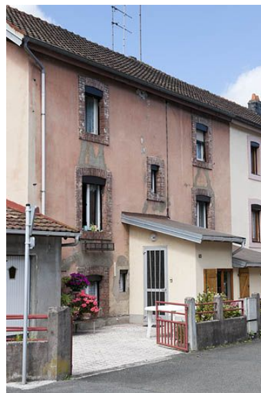
Elévation d'une habitation. Phot. Jérôme Mongreville IVR43_20112502193NUC4A
