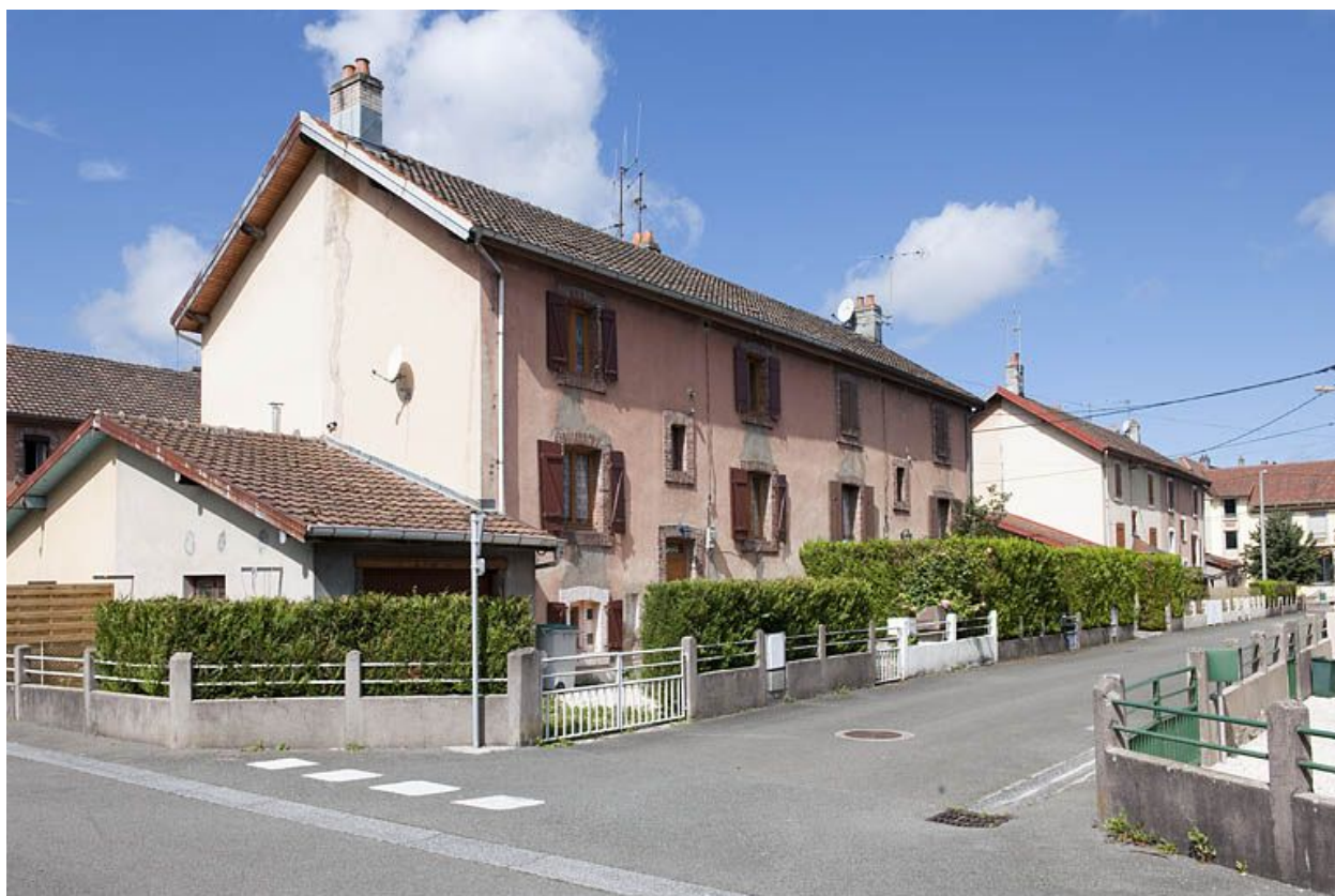
Vue d'ensemble d'une rue.
