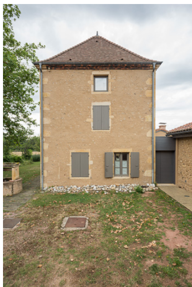
Façade latérale est de la maison Phot. Pierre-Marie Barbe-Richaud IVR26_20197100300NUC4A
