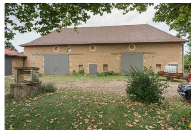
Façade antérieure de la grange Phot. Pierre-Marie Barbe-Richaud IVR26_20197100298NUC4A
