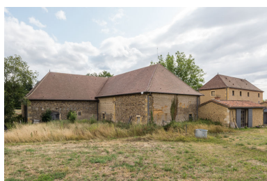
Vue d'ensemble des bâtiments au nord-est Phot. Pierre-Marie Barbe-Richaud IVR26_20197100309NUC4A
