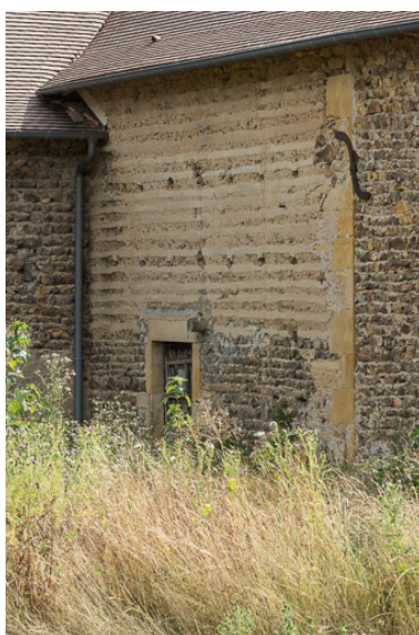
Détail d'un mur de la grange, partiellement bâti en pisé Phot. Pierre-Marie Barbe-Richaud IVR26_20197100308NUC4A
