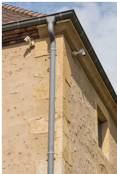
Détail de la corniche en pierre calcaire sur la façade antérieure de la maison Phot. Pierre-Marie Barbe-Richaud IVR26_20197100307NUC4A
