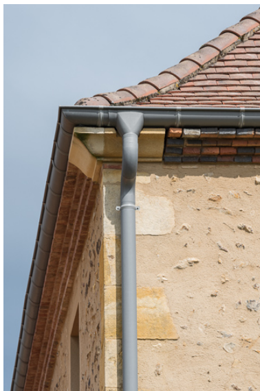
Détail de la corniche sur les façades latérales et postérieures de la maison. Seule la corniche de la façade antérieure est entièrement réalisée en pierre, alors que la brique est utilisée pour les autres façades. Phot. Pierre-Marie Barbe-Richaud IVR26_20197100306NUC4A
