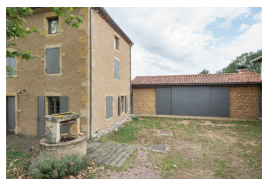
Cour de la ferme Phot. Pierre-Marie Barbe-Richaud IVR26_20197100299NUC4A
