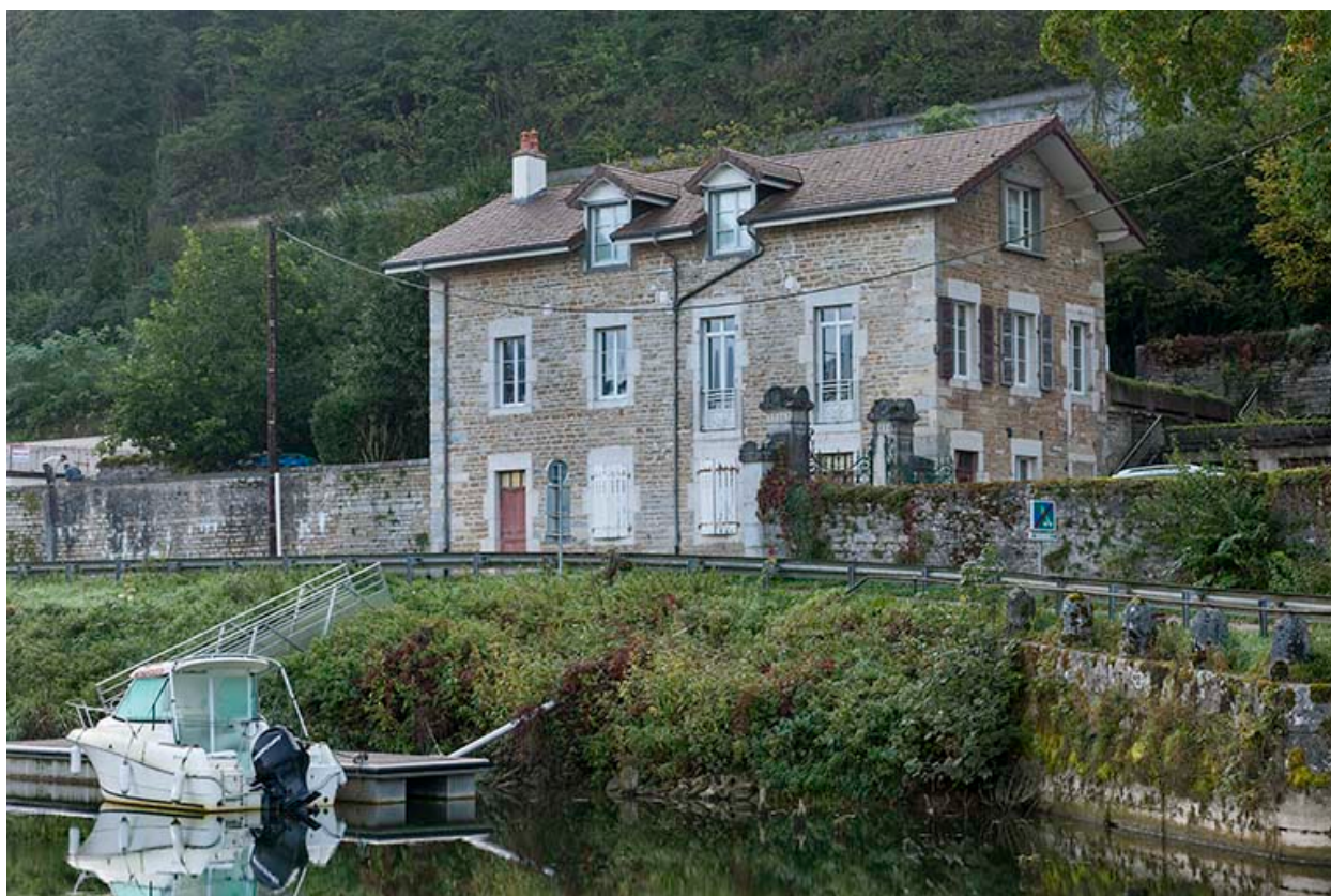
La conciergerie vue depuis l'ouest.
