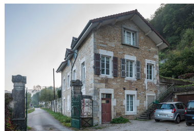
La conciergerie vue de trois quarts. Phot. Jérôme Mongreville IVR43_20142501592NUC4A
