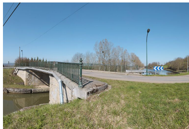
Le pont. Gare d'eau en aval.
