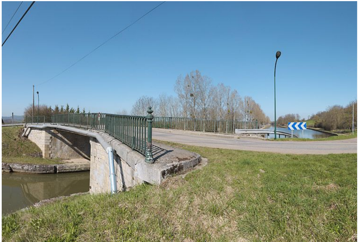
Le pont. Gare d'eau en aval.
