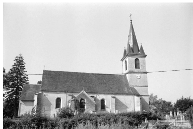
Façade latérale gauche. Phot. Guy Forestier IVR43_19753900286Z
