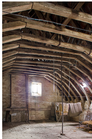
Vue rapprochée de la charpente. Phot. Sonia Dourlot IVR43_20157000336NUC2A
