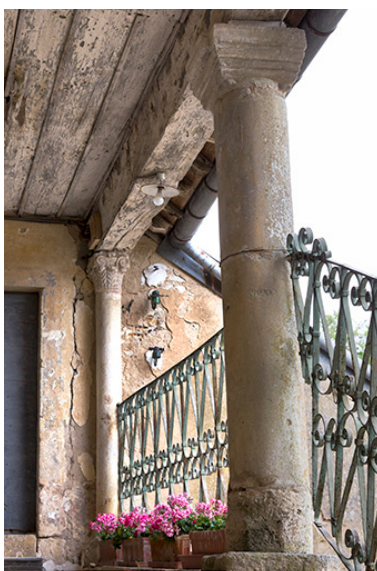
Colonnes du deuxième palier. Phot. Sonia Dourlot IVR43_20157000330NUC2A
