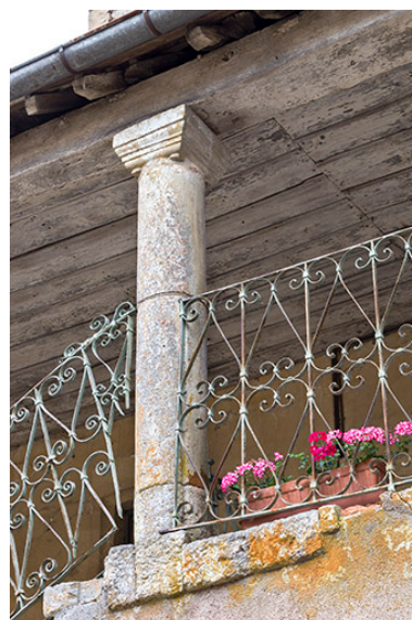
Colonne centrale du deuxième palier. Phot. Sonia Dourlot IVR43_20157000333NUC2A
