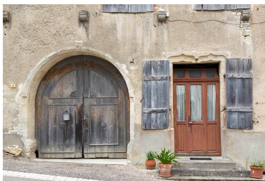
Façade antérieure : porte cochère et baie modifiée avec linteau en accolade. Phot. Sonia Dourlot IVR43_20157000338NUC2A
