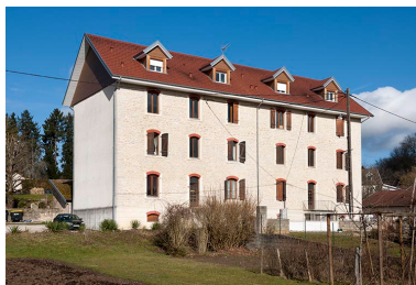
Immeuble de logements. Vue depuis le sud. Phot. Jérôme Mongreville IVR43_20152500343NUC4A
