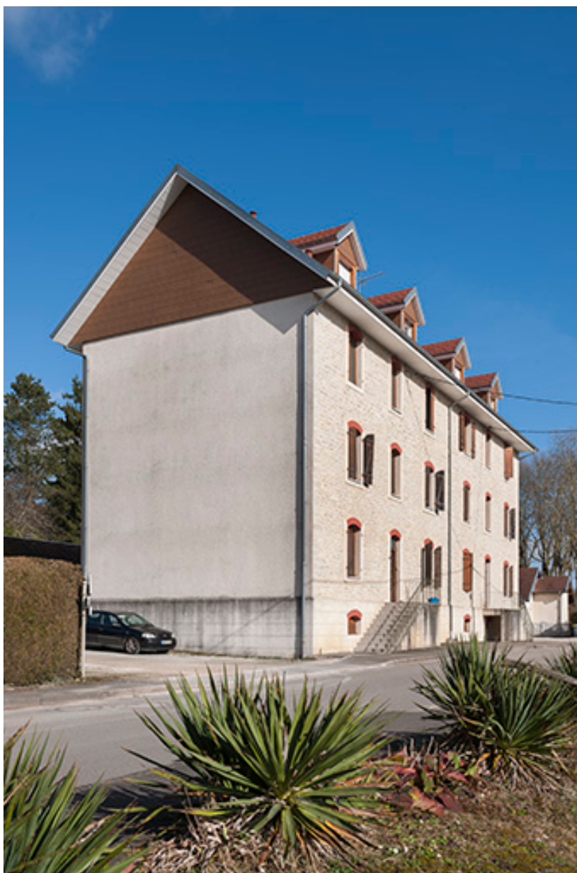
Immeuble de logements. Vue d'ensemble.
