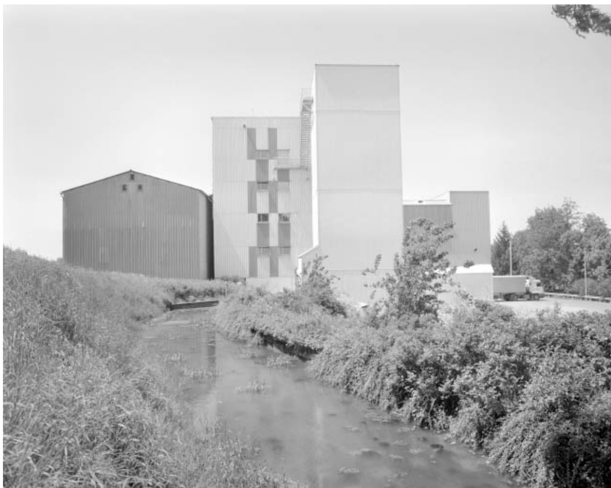
Silo et atelier de fabrication depuis l'est.
