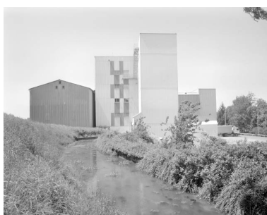
Silo et atelier de fabrication depuis l'est. Phot. Jérôme Mongreville
