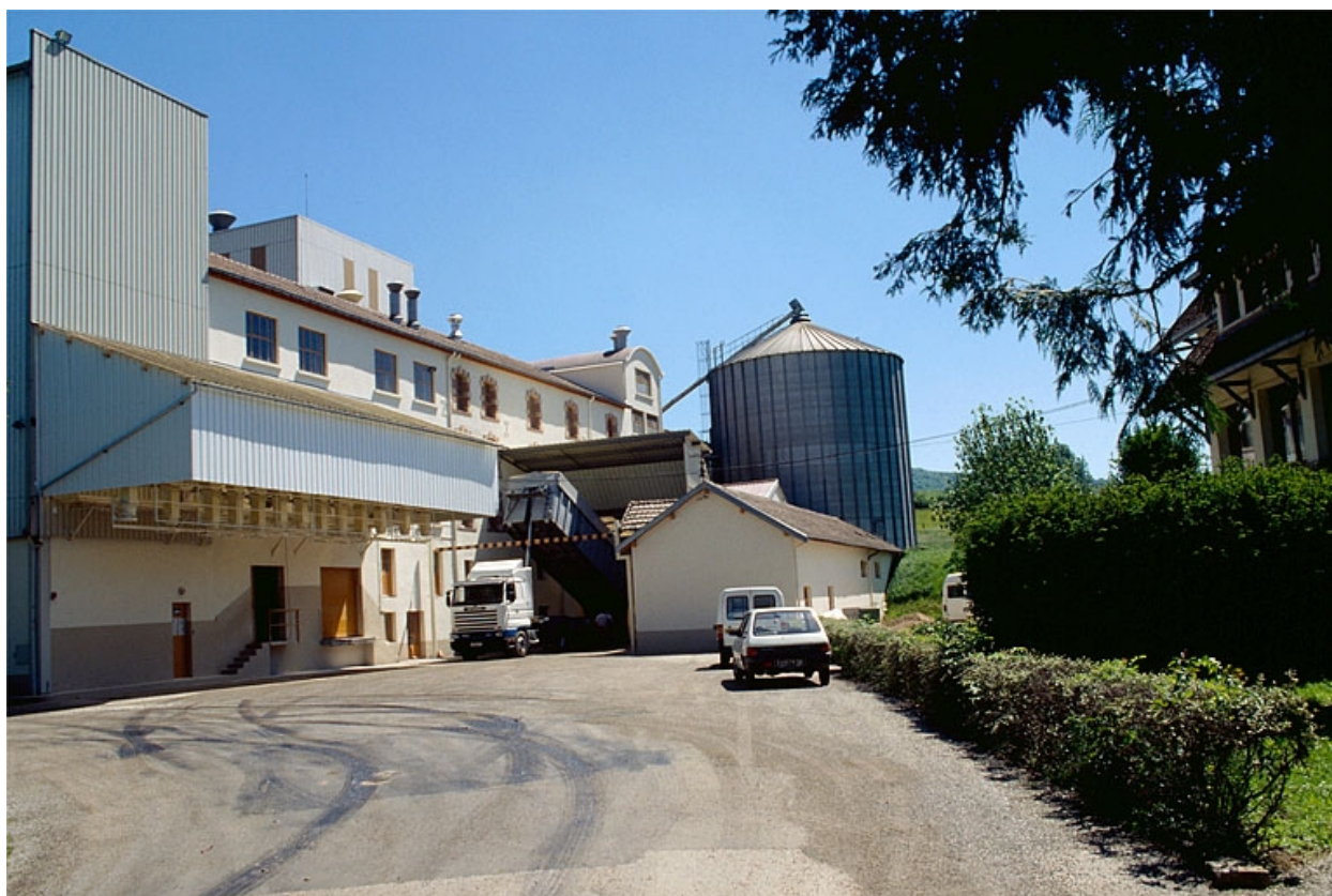
Atelier de fabrication et silos depuis l'entrée.
