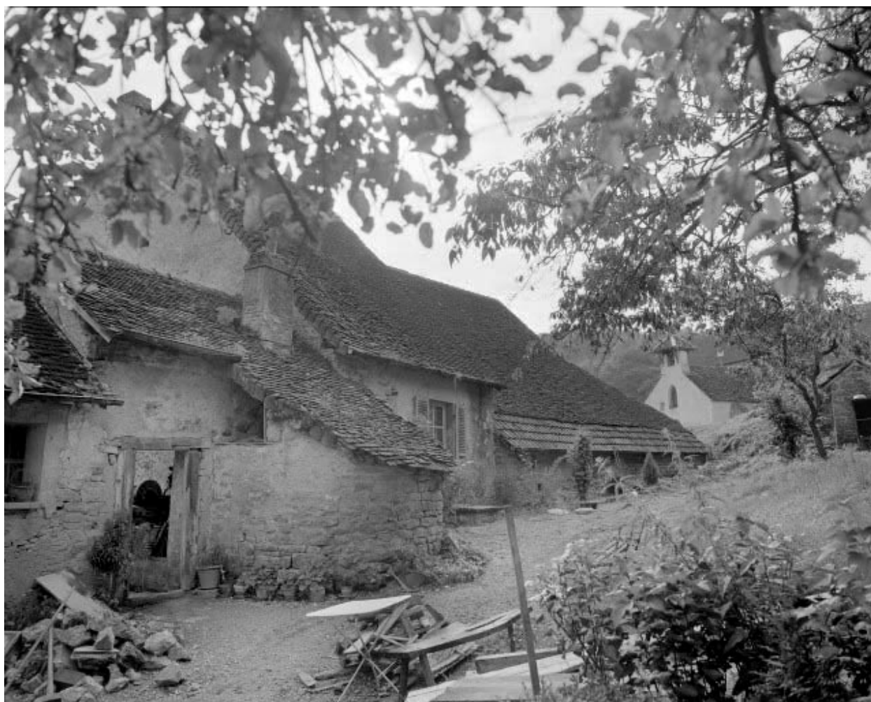
Partie droite de la façade postérieure.
