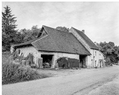
Façade antérieure. Phot. Dominique Dominguez IVR43_19773900016X
