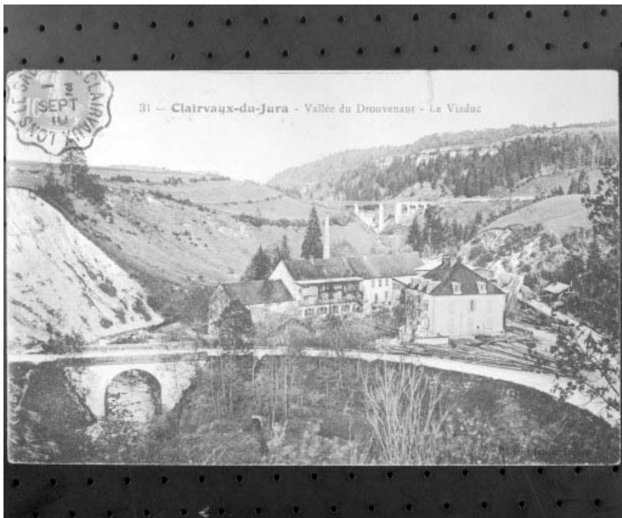
Clairvaux-du-Jura - Vallée du Drouvenant - Le Viaduc.
