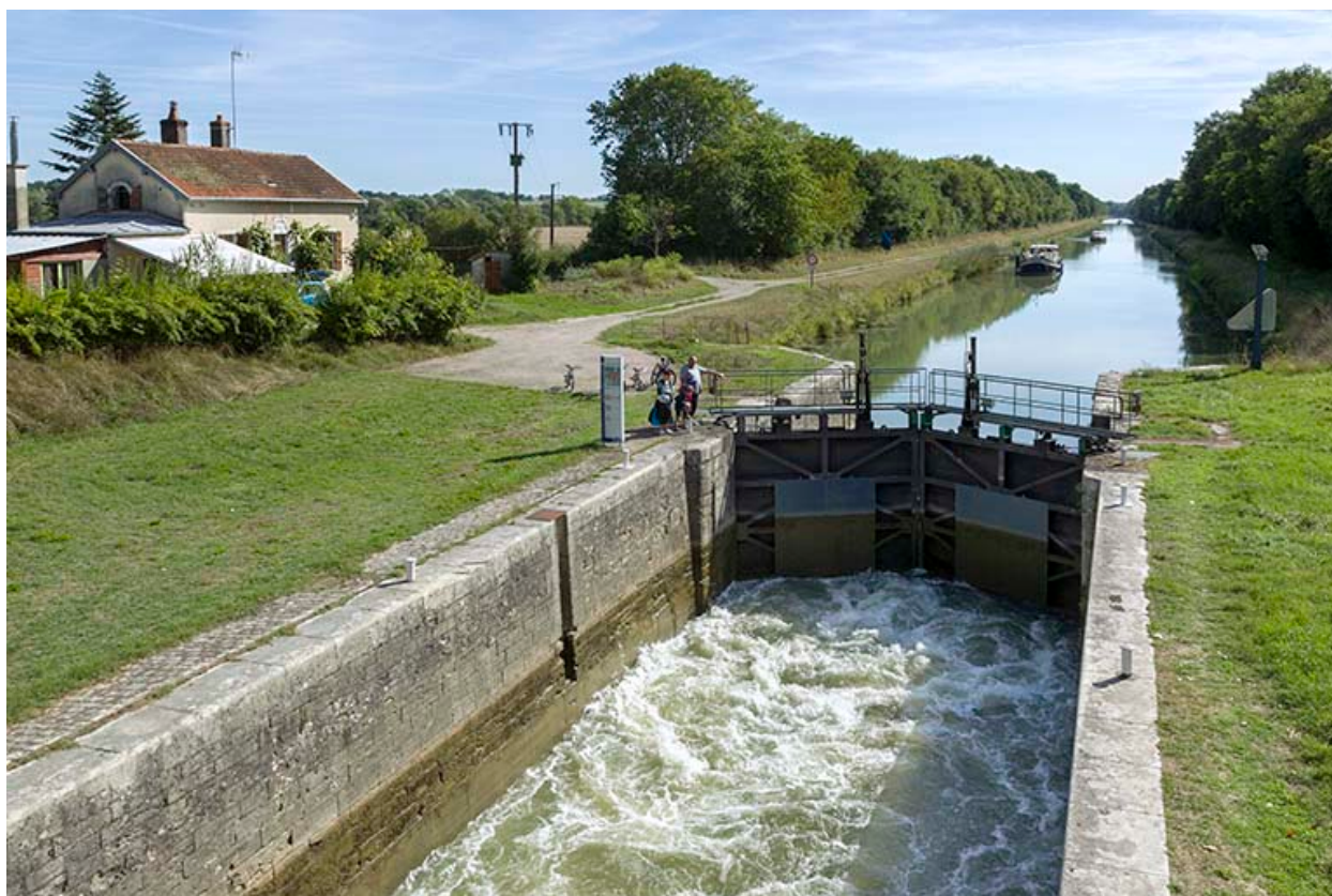
Le sas de l'écluse.
