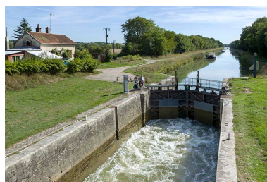
Le sas de l'écluse. Phot. Sonia Dourlot IVR43_20157000879NUC2A
