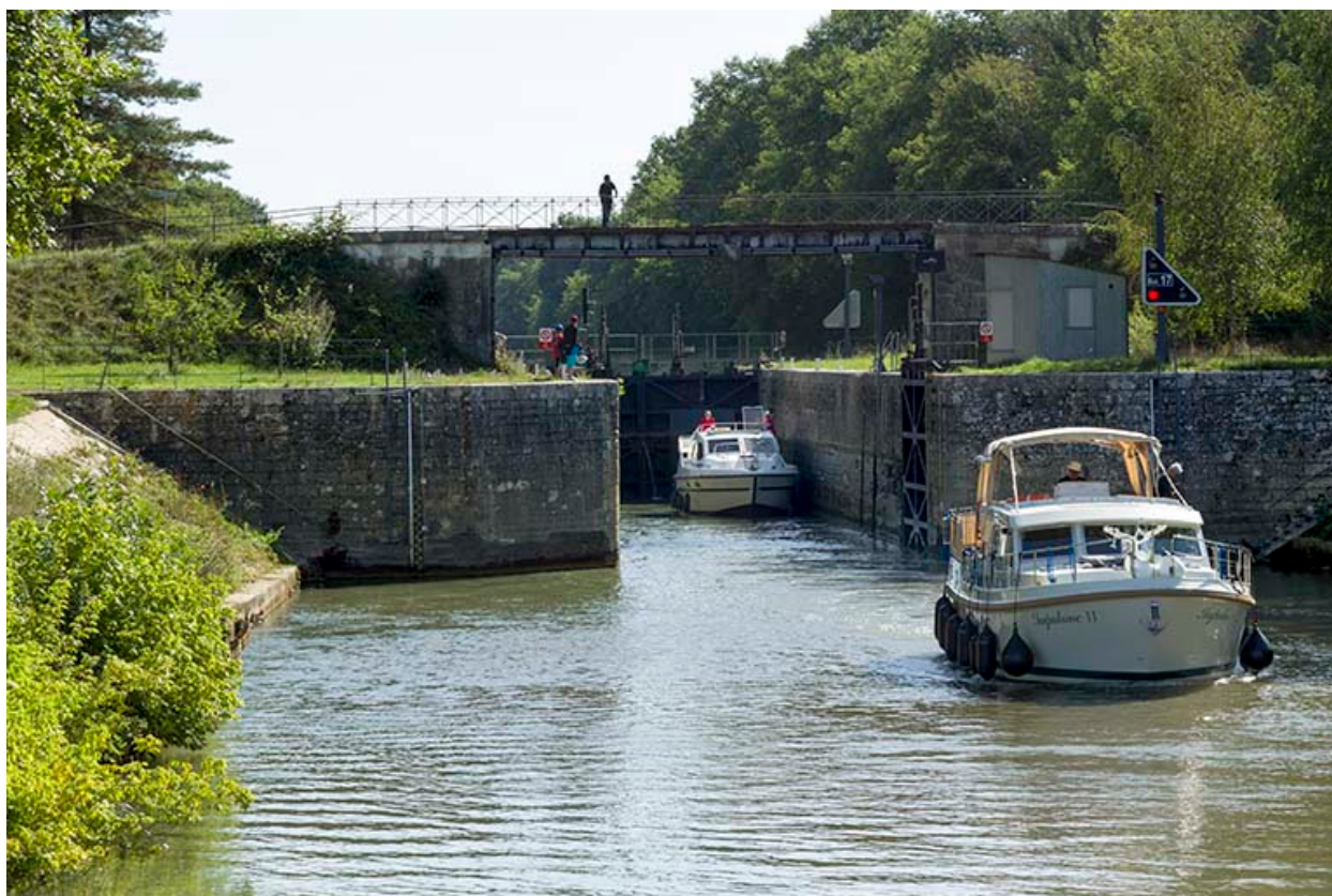
L'écluse depuis l'aval.
