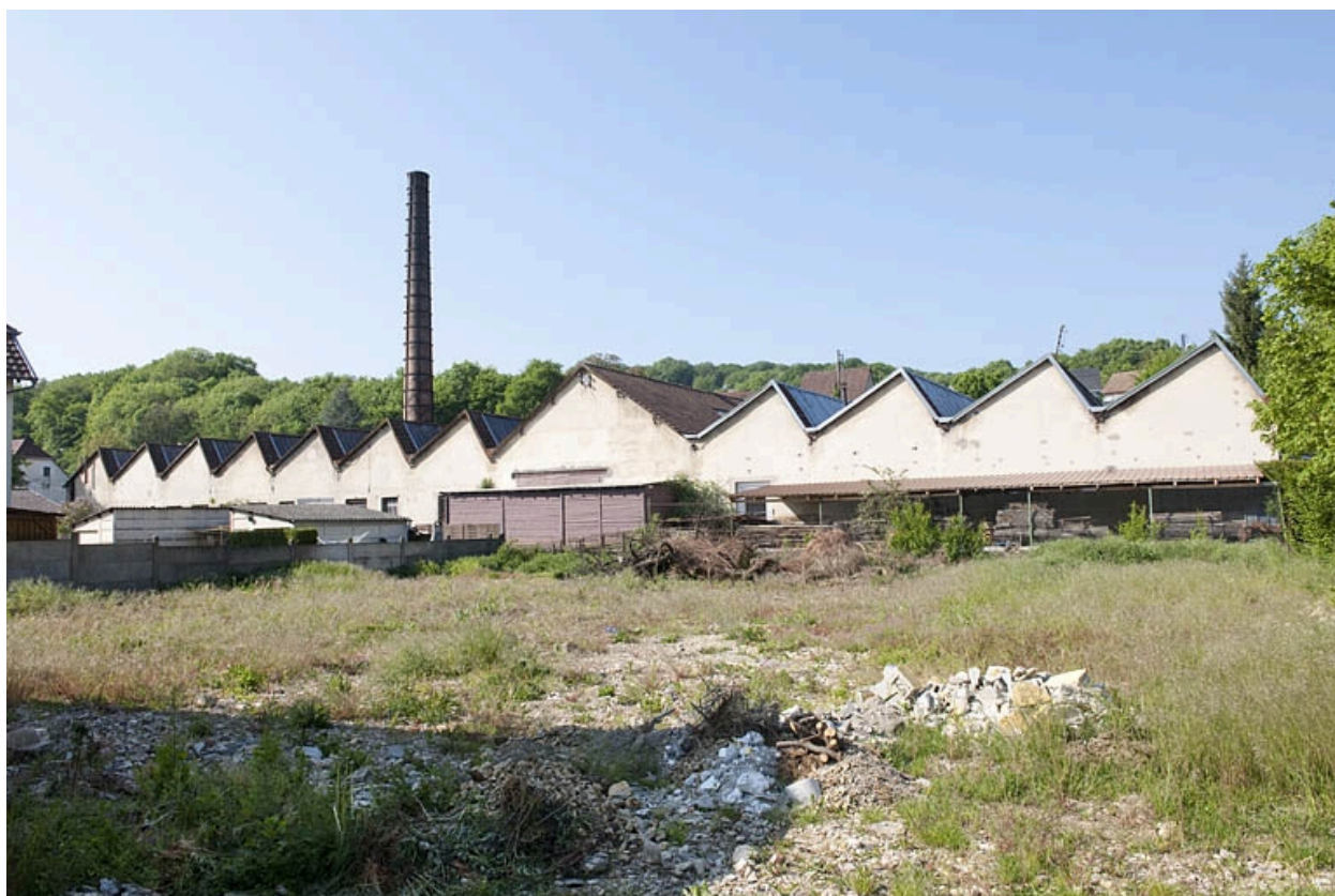
Atelier de laitonnerie. Façade ouest.
