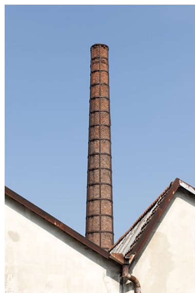
Sheds et cheminée de l'atelier de laitonnerie.
