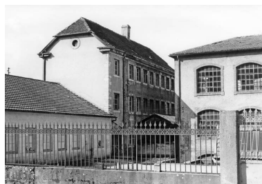
Magasin et atelier de fabrication ouest en 1980. Photogr., 1980. Phot. Raphaël Favereaux, Autr. Bernard Goetz IVR43_20122500665NUC2A
