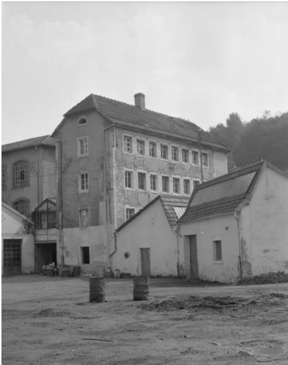
Elévation d'un ancien atelier en 1981.
