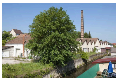
Atelier de laitonnerie. Vue depuis le sud-est. Phot. Jérôme Mongreville IVR43_20112501393NUC4A
