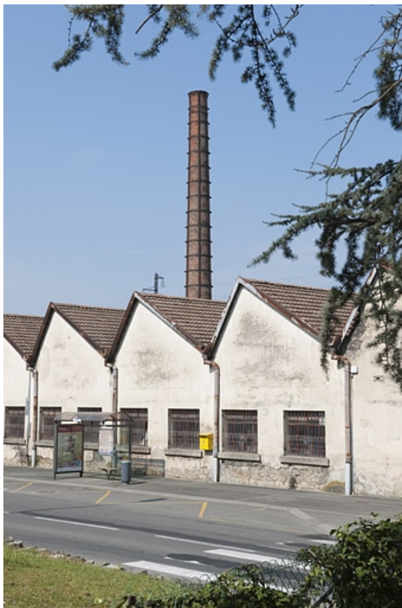
Vue rapprochée de l'atelier de laitonnerie.
