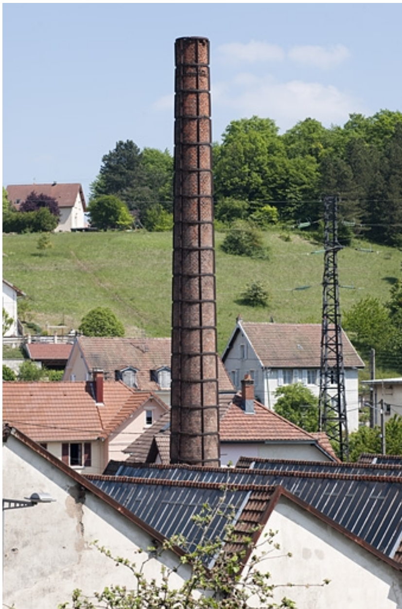
Sheds et cheminée de l'atelier de laitonnerie.
