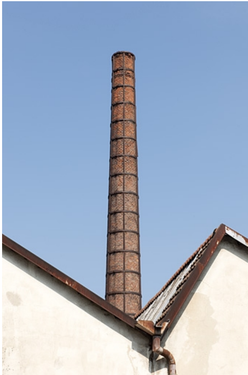
Sheds et cheminée de l'atelier de laitonnerie.
