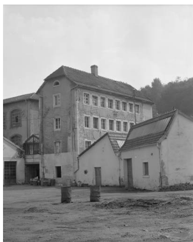
Elévation d'un ancien atelier en 1981. Phot. Yves Sancey IVR43_19812500463X
