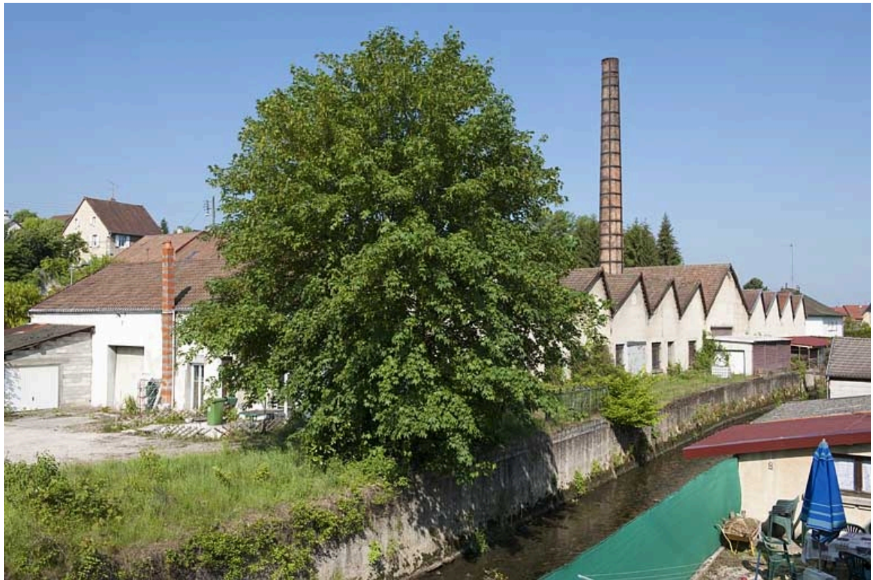
Atelier de laitonnerie. Vue depuis le sud-est.
