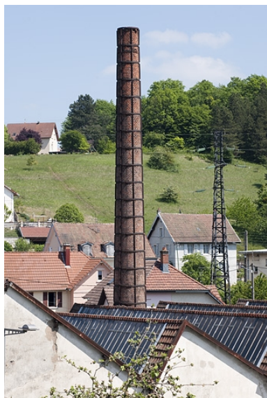
Sheds et cheminée de l'atelier de laitonnerie.
