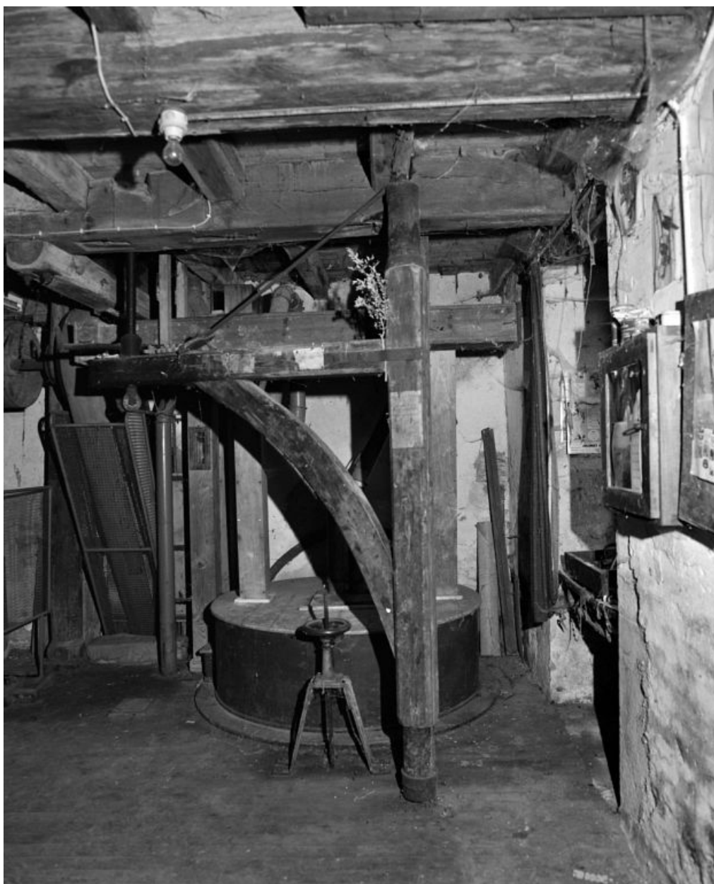
Rez-de-chaussée. Meules, potence et compas.
