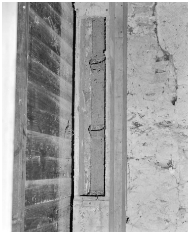
1er étage. Elévateur à godets, détail. Phot. Jean-Luc Duthu IVR26_20062106688X
