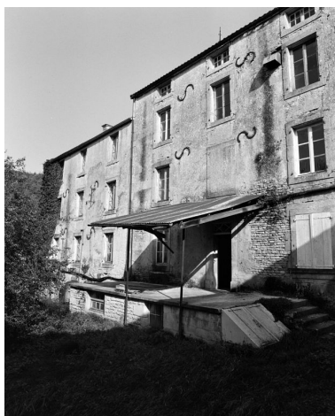
Les bâtiments principaux. Elévations postérieures. Phot. Jean-Luc Duthu IVR26_20062106625X
