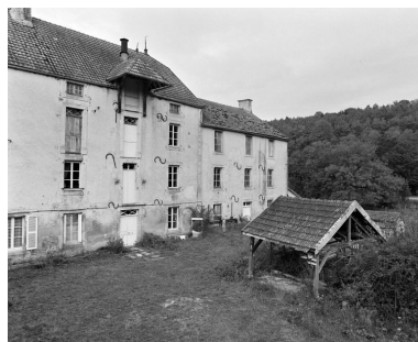
Les bâtiments principaux et le lavoir. Vue prise du sud-est, depuis la cour. Phot. Jean-Luc Duthu IVR26_20062106606X
