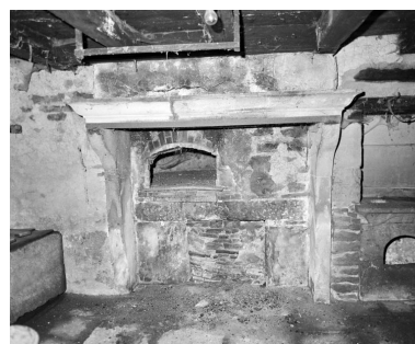
La chambre à four. La cheminée, détail. Phot. Jean-Luc Duthu IVR26_20062106632X
