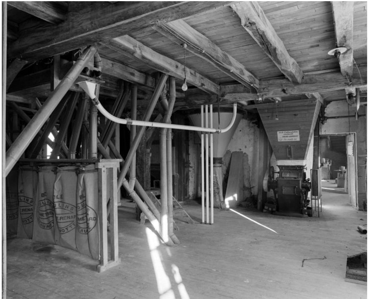
1er étage. Broyeur et ensacheur.
