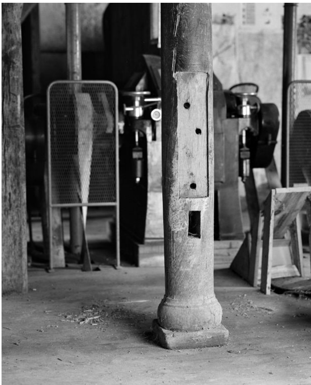
Rez-de-chaussée. Salle des machines, détail.
