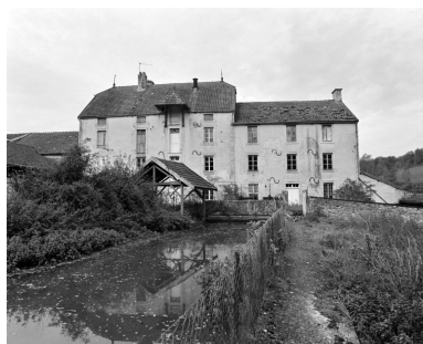
Les bâtiments principaux et le lavoir. Vue prise de l'est, depuis la retenue de la Coquille. Phot. Jean-Luc Duthu IVR26_20062106603X
