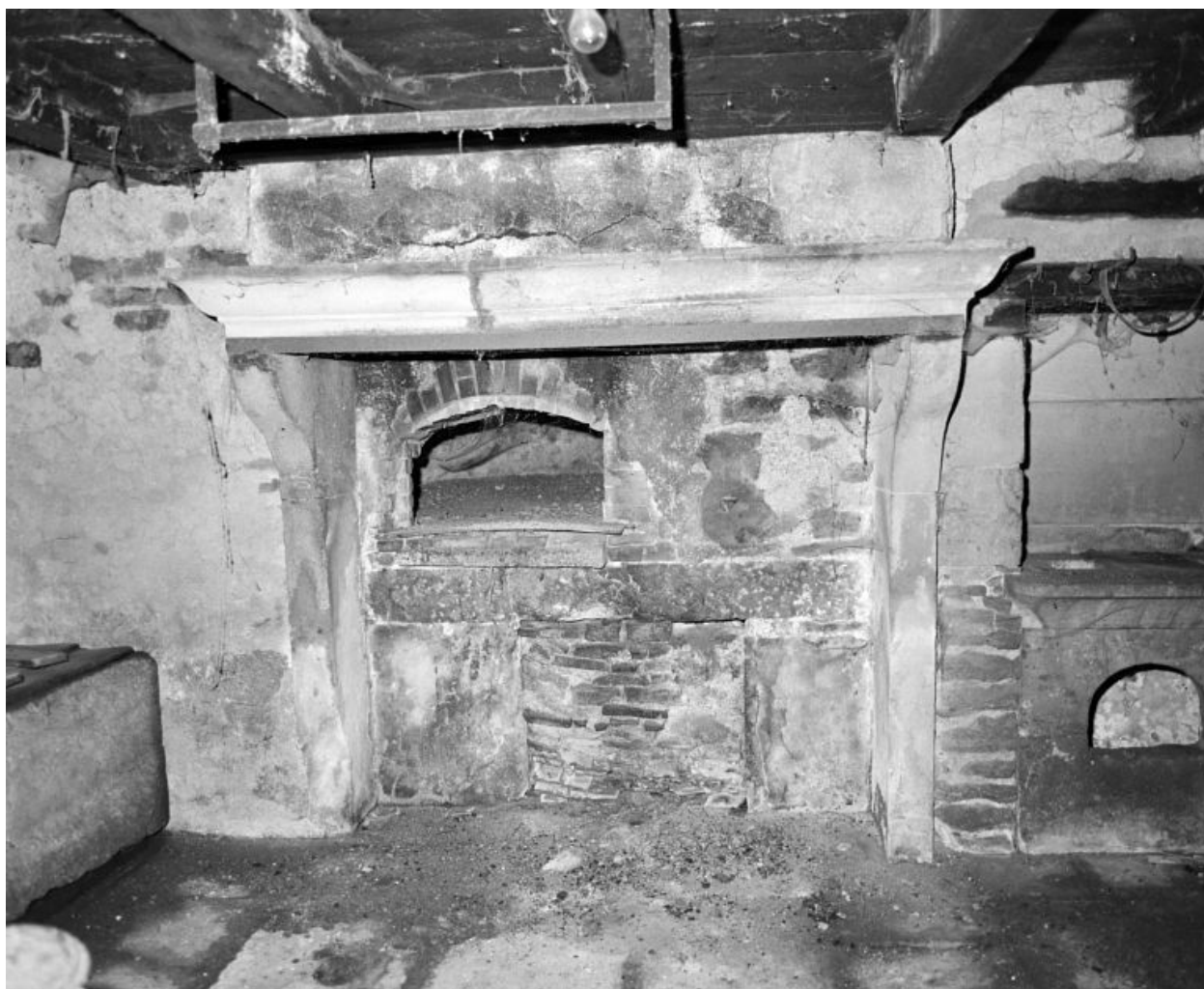
La chambre à four. La cheminée, détail.
