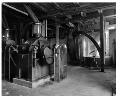
Rez-de-chaussée. Broyeur (marque Socam, Paris). Phot. Jean-Luc Duthu IVR26_20062106661X
