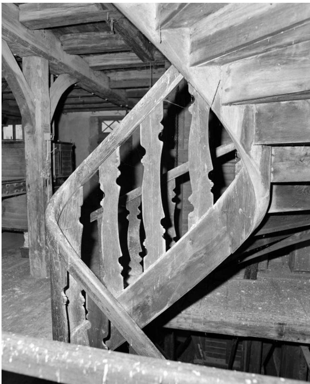
2e étage. Escalier, détail de la volée.
