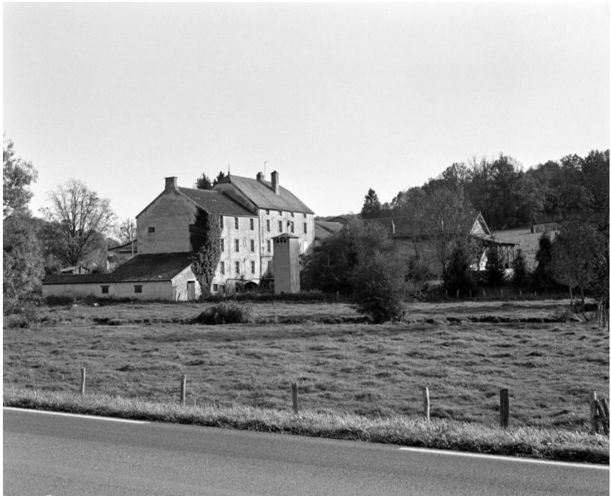
Vue d'ensemble prise du nord-ouest, depuis la R.D. 901.
