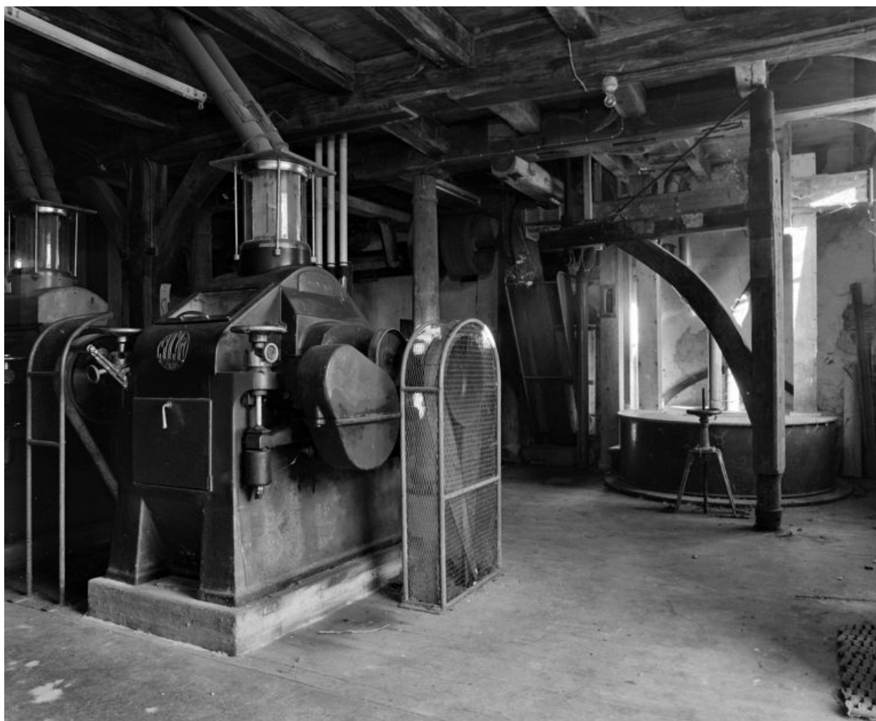
Rez-de-chaussée. Broyeur (marque Socam, Paris).
