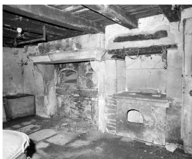
La chambre à four. La cheminée et le potager, détail. Phot. Jean-Luc Duthu IVR26_20062106629X
