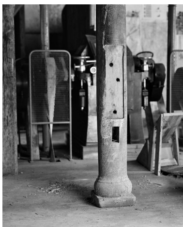
Rez-de-chaussée. Salle des machines, détail. Phot. Jean-Luc Duthu IVR26_20062106668X
