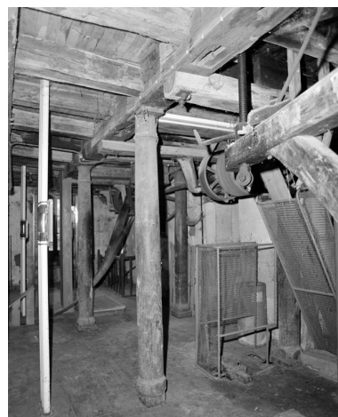
Rez-de-chaussée. Arbre de transmission et poulies. Phot. Jean-Luc Duthu IVR26_20062106664X
