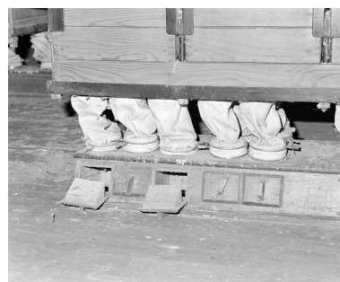
2e étage. Plansichter (Socam, Paris), détail. Phot. Jean-Luc Duthu IVR26_20062106740X
