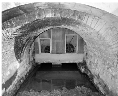
La chambre d'eau. Vue prise depuis la passerelle. Phot. Jean-Luc Duthu IVR26_20062106636X
