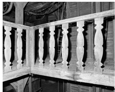
2e étage. Escalier, détail de la balustrade du palier. Phot. Jean-Luc Duthu IVR26_20062106715X
