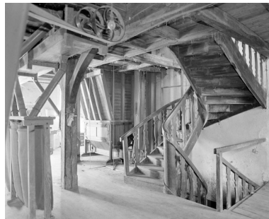
1er étage. Escalier. Phot. Jean-Luc Duthu IVR26_20062106708X
