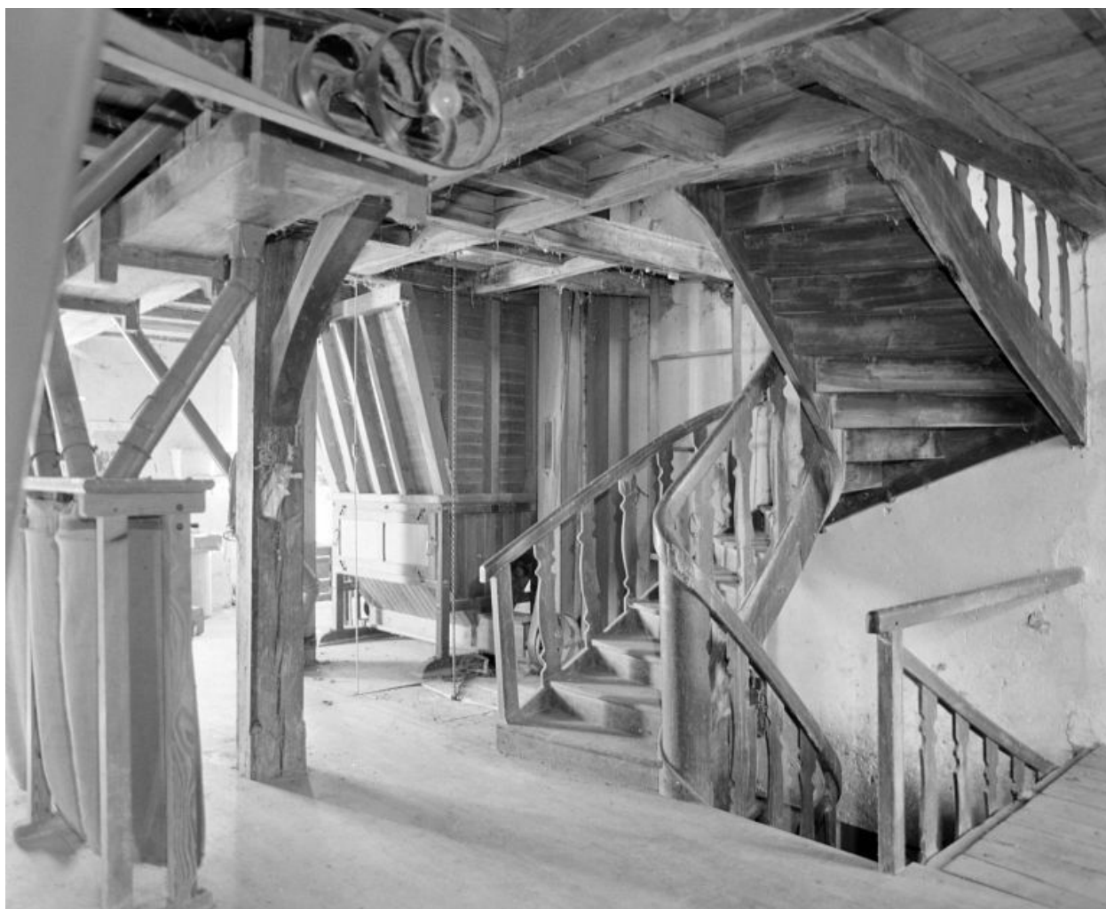
1er étage. Escalier.
