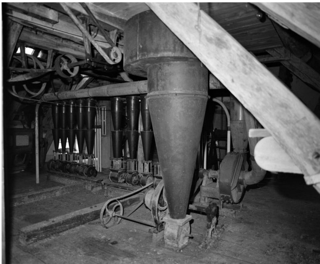
Comble à surcroît. Ecluses.
