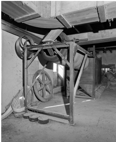
2e étage. Trieur à blé, détail. Phot. Jean-Luc Duthu IVR26_20062106723X
