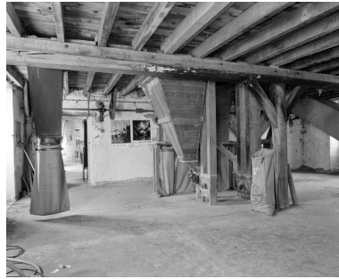
1er étage. Ensacheurs. Phot. Jean-Luc Duthu IVR26_20062106702X
