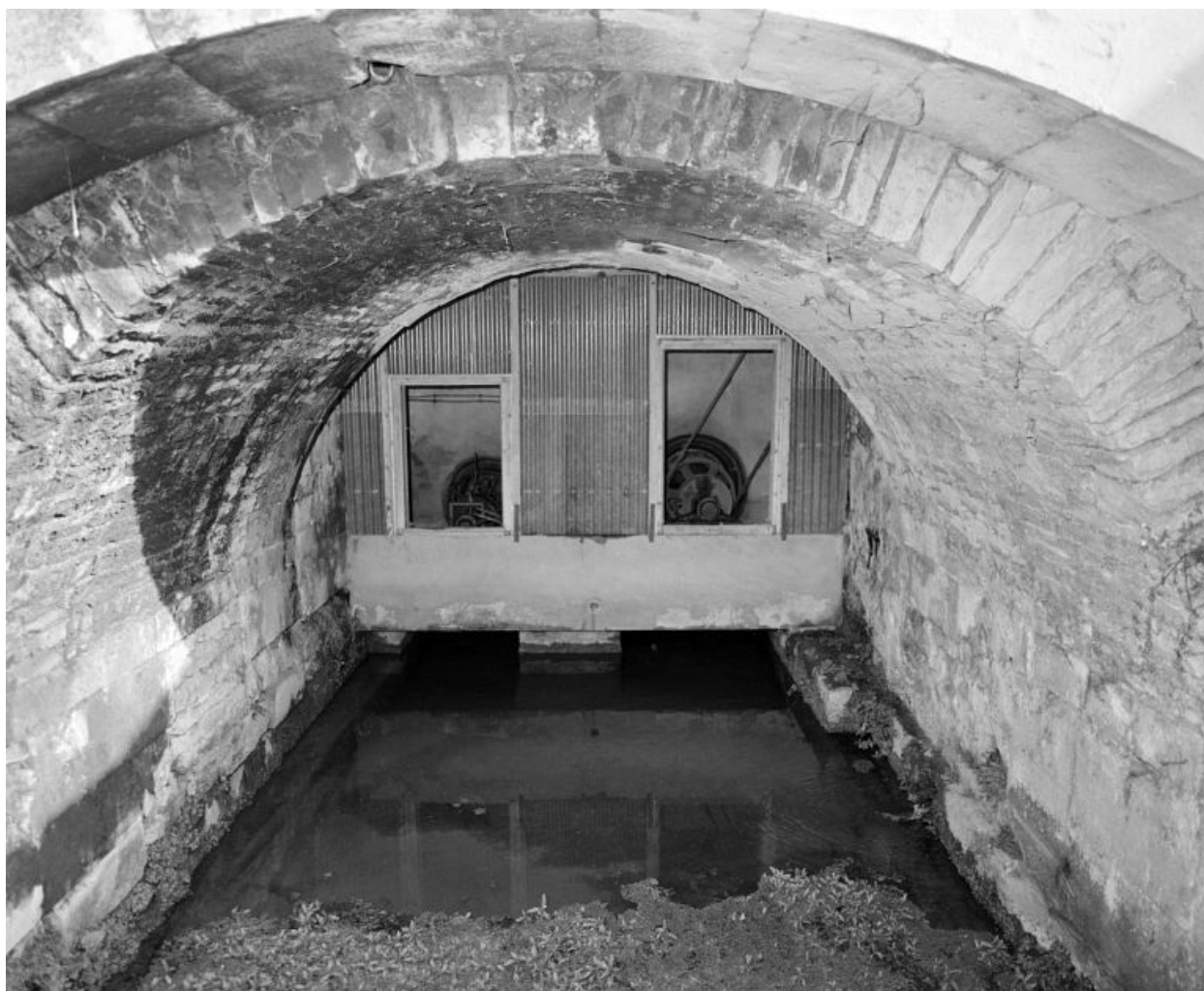
La chambre d'eau. Vue prise depuis la passerelle.
