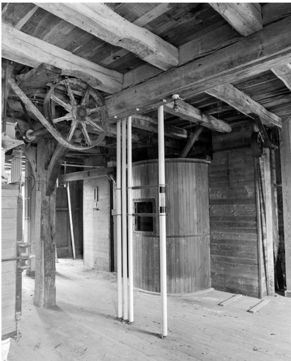
2e étage. Mélangeur.
