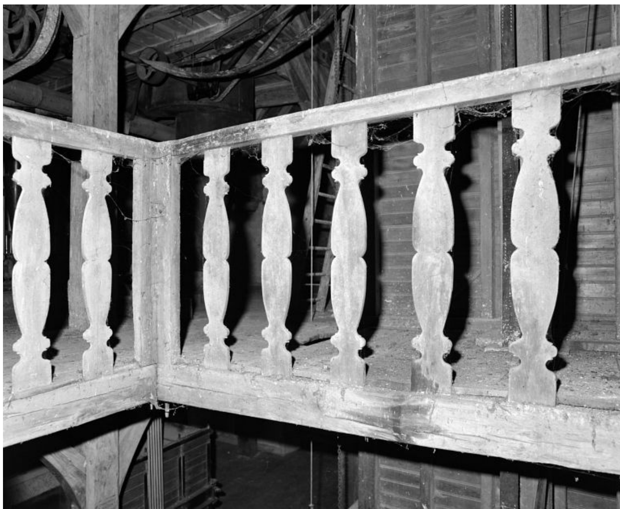
2e étage. Escalier, détail de la balustrade du palier.
