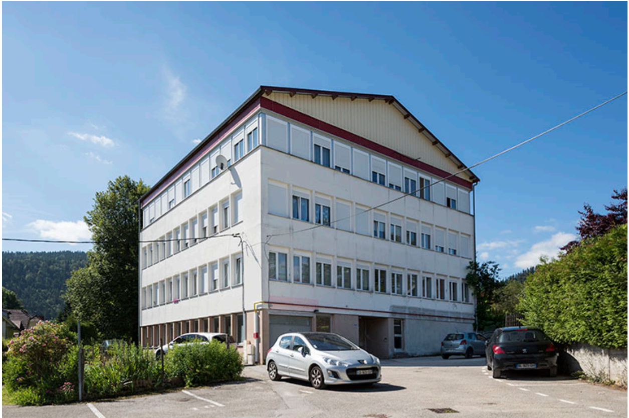
Maison et usine de montres des Ets Camille Bouhelier puis Claude Hélier (1931, 1965-1969), aux 1 et 9 rue Newton.
