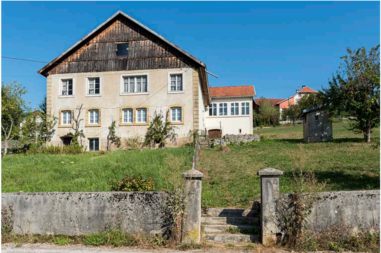
Ferme à Chaillexon (fin 18e-début 19e siècle), au 4 rue des Murgers. Atelier Zimermann bâti vers 1908 (fabrique de balanciers de montre).
