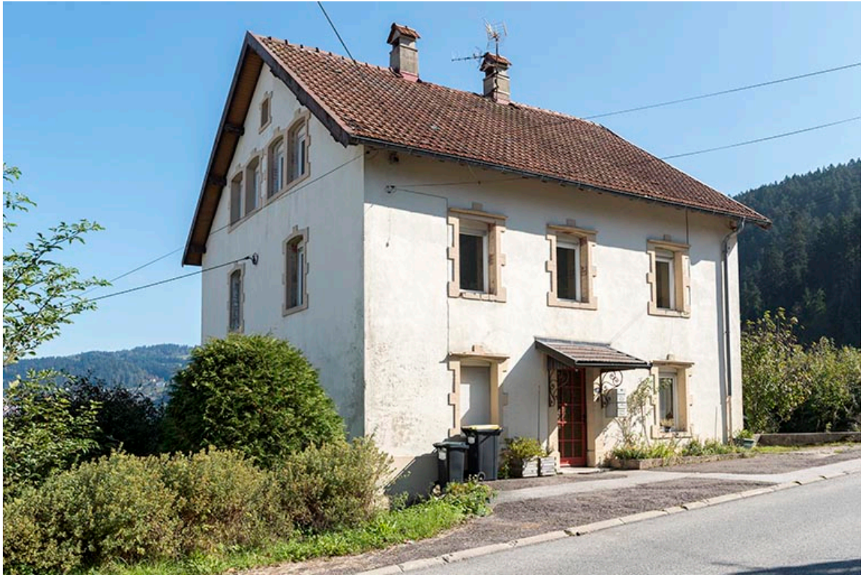
Restaurant des Chasseurs (1891-1892) et atelier d'horlogerie d'Ernest Paumier, au 19 rue du Col. Atelier de planteur d'échappements à l'étage en surcroît.
