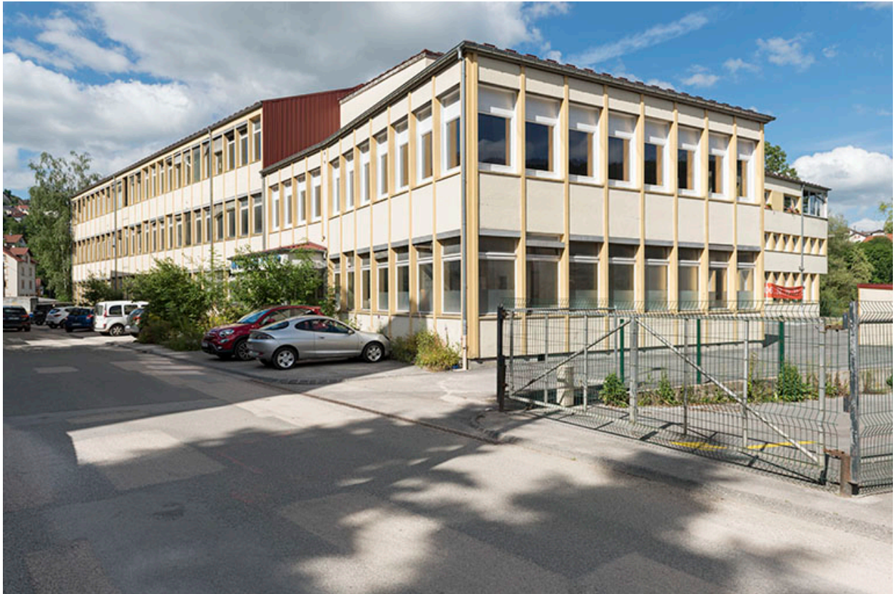
Usine de décolletage et de matériel d'équipement industriel Camille Joriot puis Magister (vers 1898, 1964-1974...), aux 3 et 4 rue du Lac.
