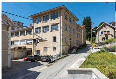
Maison et usine de montres dite fabrique de La Perrière ou Manufacture Marius Anguenot (vers 1907, 1924-1925, 1938-1951), aux 1 et 3 rue de la Perrière : l'usine.
