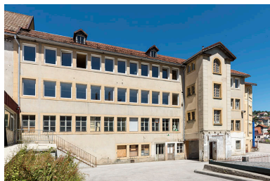
Usine d'ébauches de montre des Etablissements Parrenin (1876-1877...), aux 5-9 rue Hippolyte Parrenin : façade postérieure.
