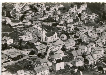
Villers-le-Lac (Doubs) - Vue aérienne. 22173 - Le Centre du Pays, 1952. IVR43_20162500119NUC4A
