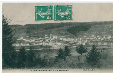
6 - Villers-le-Lac - Vue générale [depuis l'est], 1er quart 20e siècle [avant 1908]. IVR43_20162500516NUC2A
