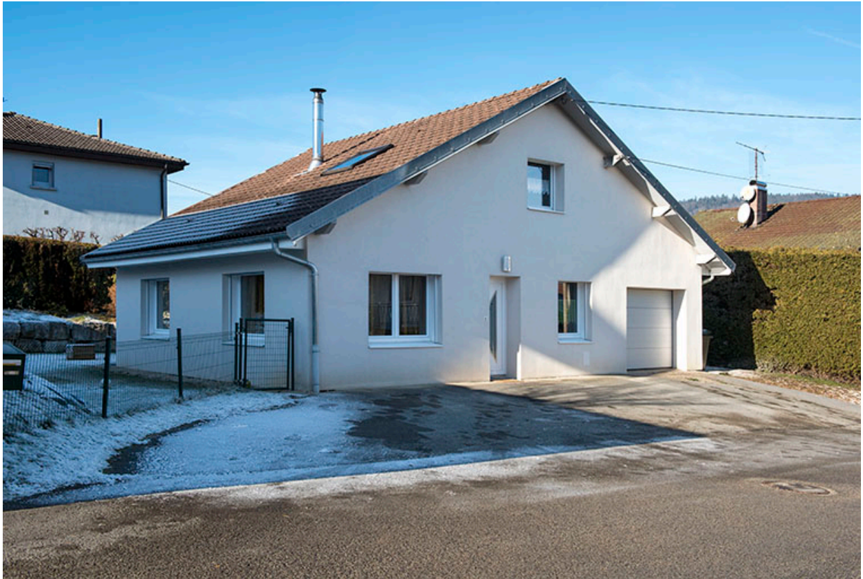
Maison (1981) et atelier d'horlogerie de Jacques Renaud-Bezot, au 8 rue de Bellerive. Fabrique de montres.
