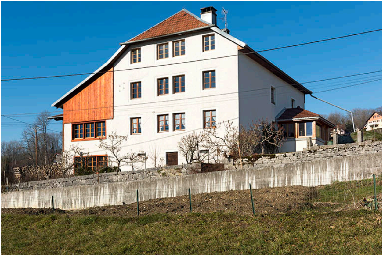
Ferme à Chaillexon (1860), au 7 rue des Murgers. Fabrique de balanciers de montre Amiot et Vuillemin, sur deux niveaux.
