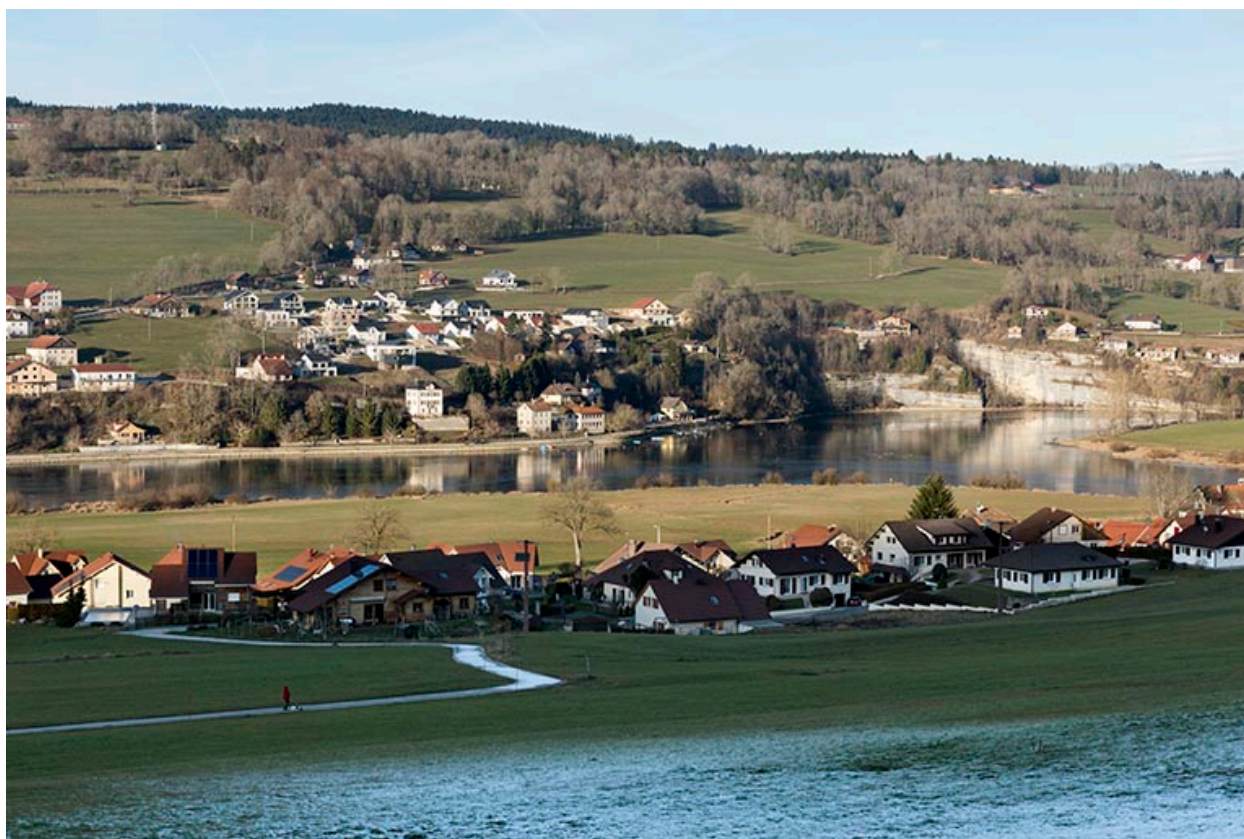
Vue d'ensemble de Chaillexon, depuis le sud.
