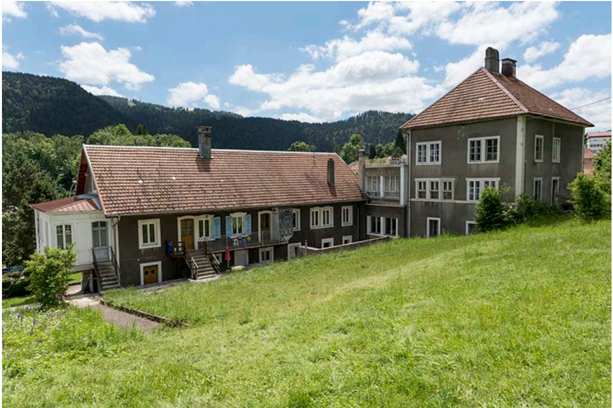
Maison (1871, vers 1923, vers 1947) et usine de montres Dupommier et Marguet Frères puis Louis Marguet et Cie, aux 4-8 rue Pasteur.
