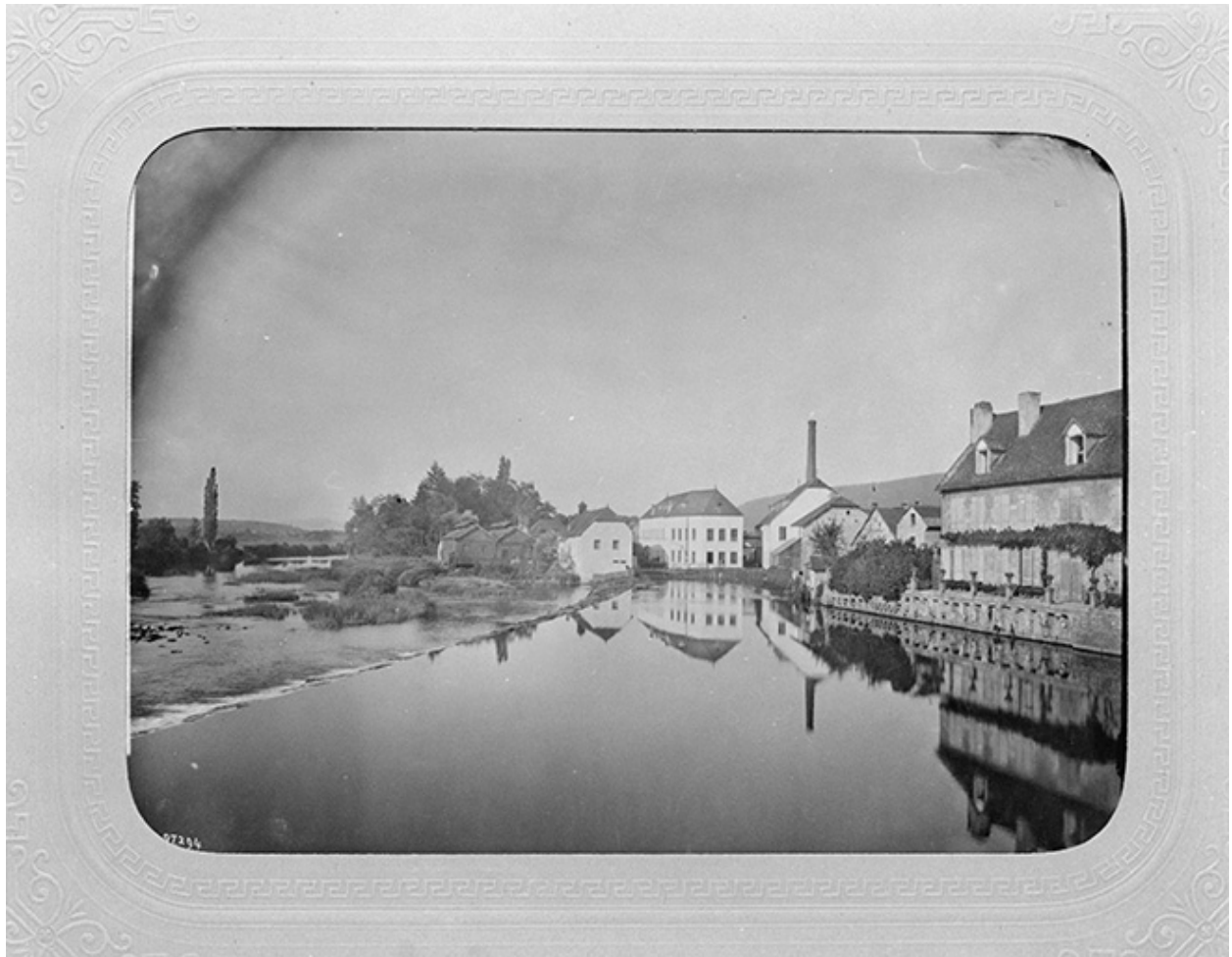
Vue d'ensemble depuis le pont, 1899-1900.
