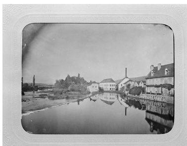
Vue d'ensemble depuis le pont, 1899-1900.
