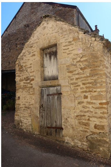
Détail de l'élévation ouest de la construction. Phot. Morgane Guillemain IVR26_20222101157NUC2A
