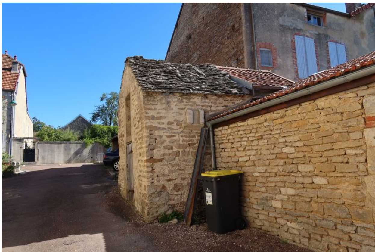
Détail de l'élévation sud de la construction
