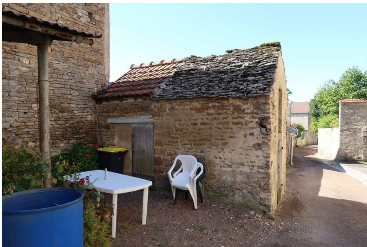
Détail de l'élévation nord de la construction.
