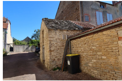
Détail de l'élévation sud de la construction Phot. Morgane Guillemain IVR26_20222101156NUC2A
