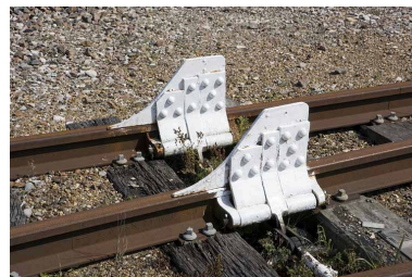
Les deux taquets, en position haute. Phot. Yves Sancey IVR43_20083900905NUC2A
