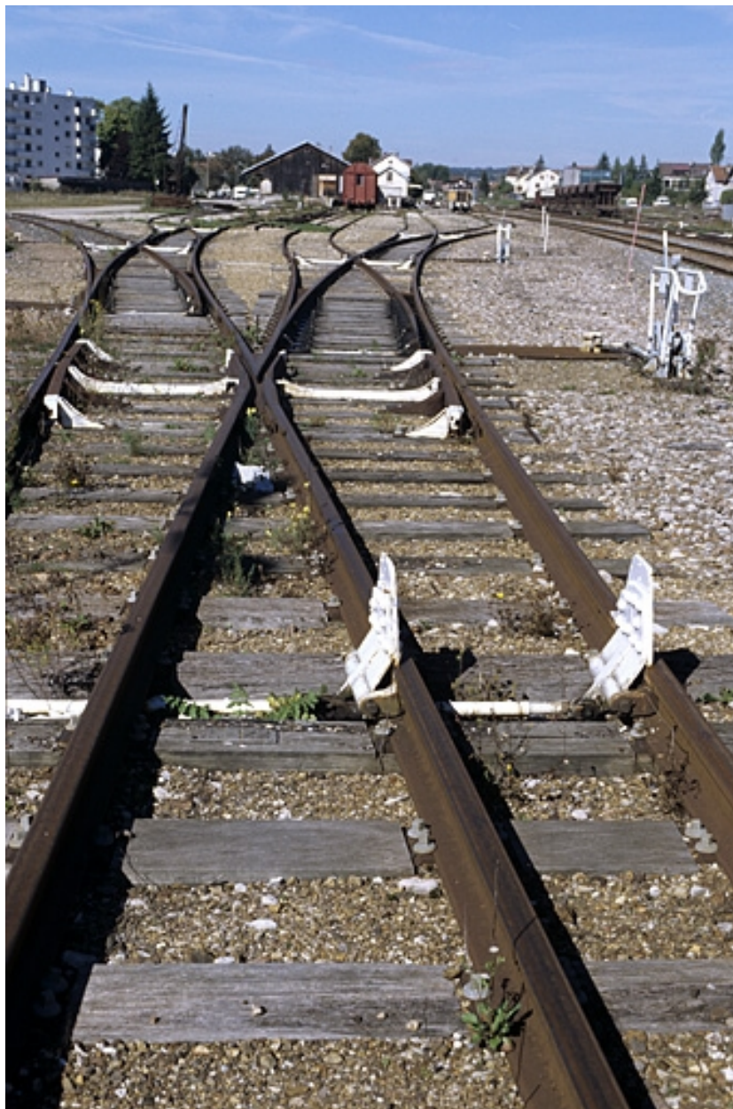
Vue d'ensemble des voies de service ouest, avec les taquets d'arrêt au premier plan.
