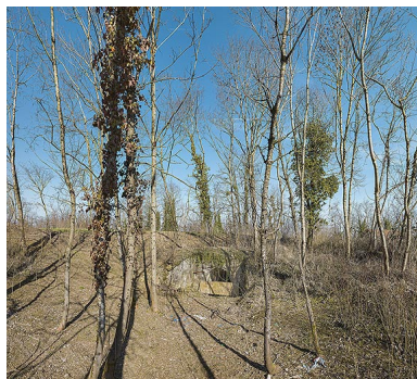
Traverse-abri envahie par la végétation. Phot. Thierry Kuntz IVR26_20252100067NUC4A
