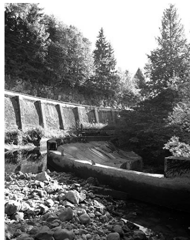
Bassin de retenue (à sec) et barrage. Phot. Yves Sancey IVR43_19973901159X
