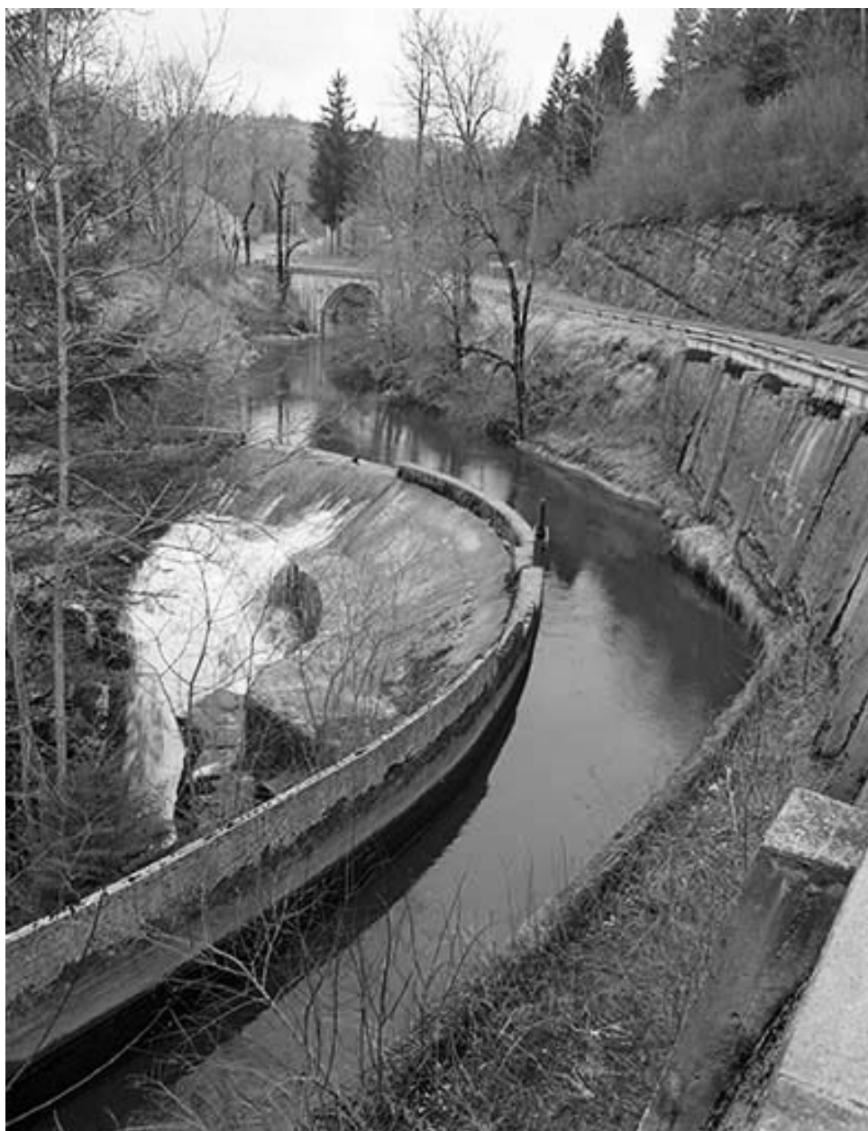
Canal d'amenée de la centrale.
