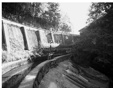
Canal d'amenée et déversoir du barrage. Phot. Yves Sancey IVR43_19973901157X
