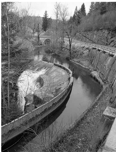
Canal d'amenée de la centrale. Phot. Yves Sancey IVR43_19983900041X
