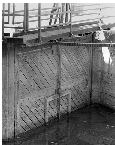
Porte amont droite : tige de manoeuvre et guide de la vantelle. Phot. Jérôme Mongreville IVR43_20032500208X
