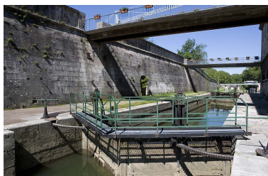
Vue d'ensemble rapprochée depuis l'amont, côté droit. Phot. Yves Sancey IVR43_20062500176NUCA
