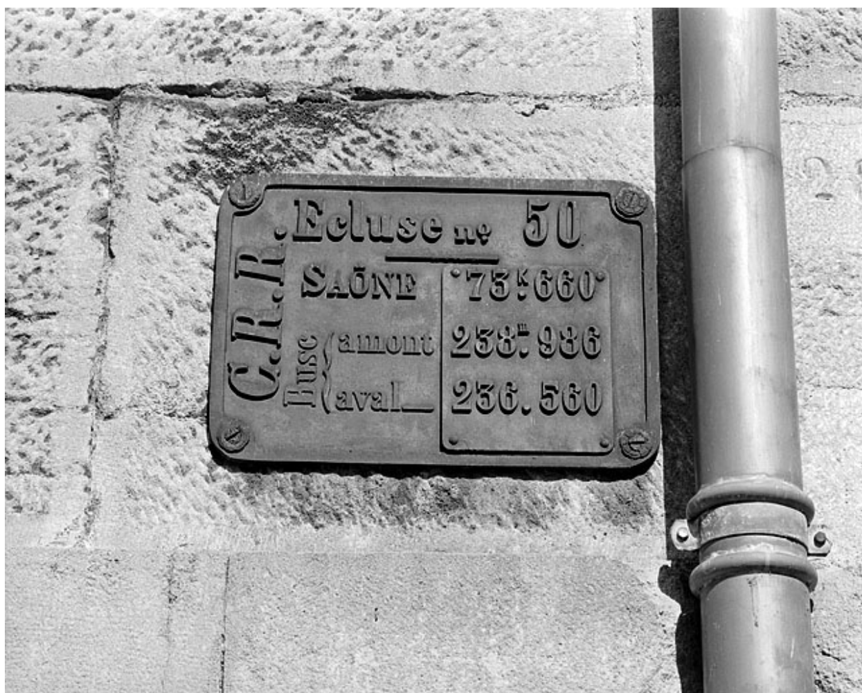
Plaque d'identification de l'écluse.
