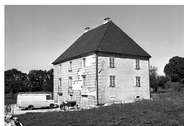
Maison située 7 Grande Rue. Phot. Yves Sancey IVR43_19802500949X
