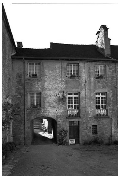
Bâtiment à l'est de la cour des chanoines, partie gauche de la façade sur la cour. Phot. Jérôme Mongreville
