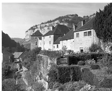
Vue générale des faces sud des bâtiments de l'abbaye. Phot. Jérôme Mongreville IVR43_19903900958X
