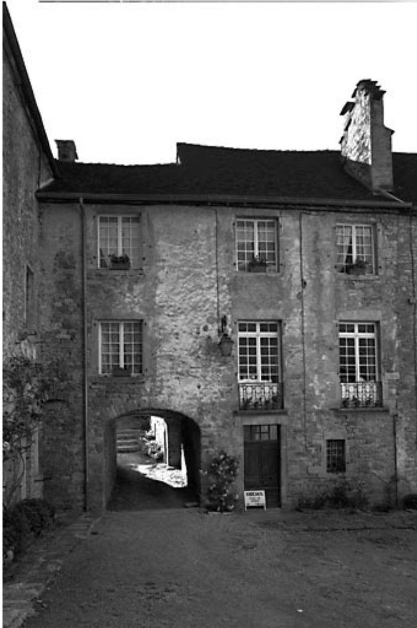
Bâtiment à l'est de la cour des chanoines, partie gauche de la façade sur la cour.
