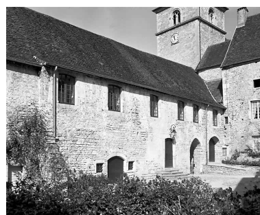
La cour des chanoines, face ouest. Phot. Jérôme Mongreville IVR43_19903900981X
