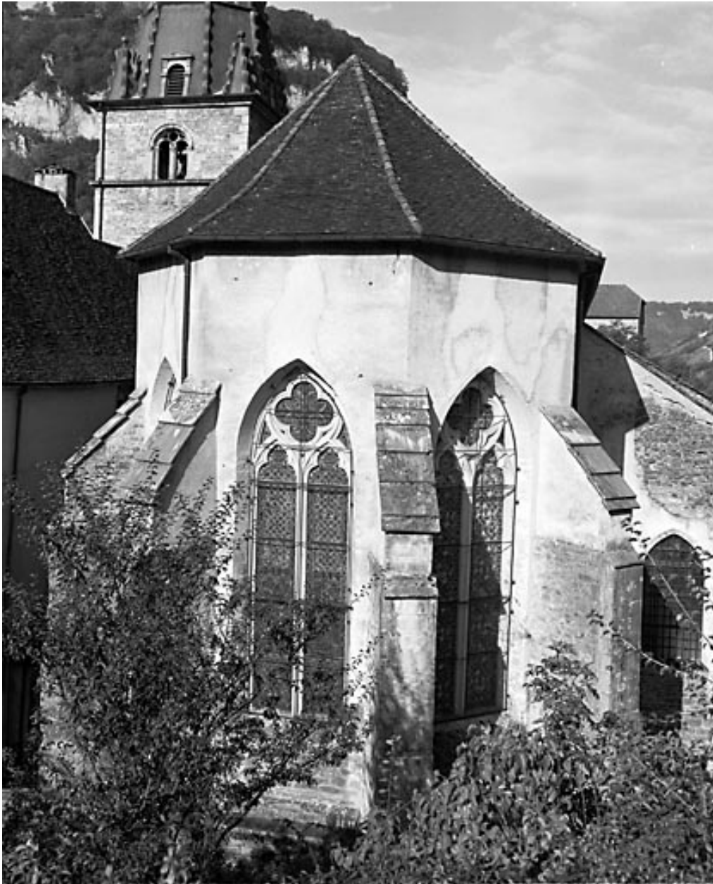
Eglise abbatiale, vue extérieure de l'abside.
