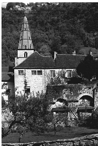
Face sud des bâtiments à l'est du cloître. Phot. Jérôme Mongreville IVR43_19903900970V
