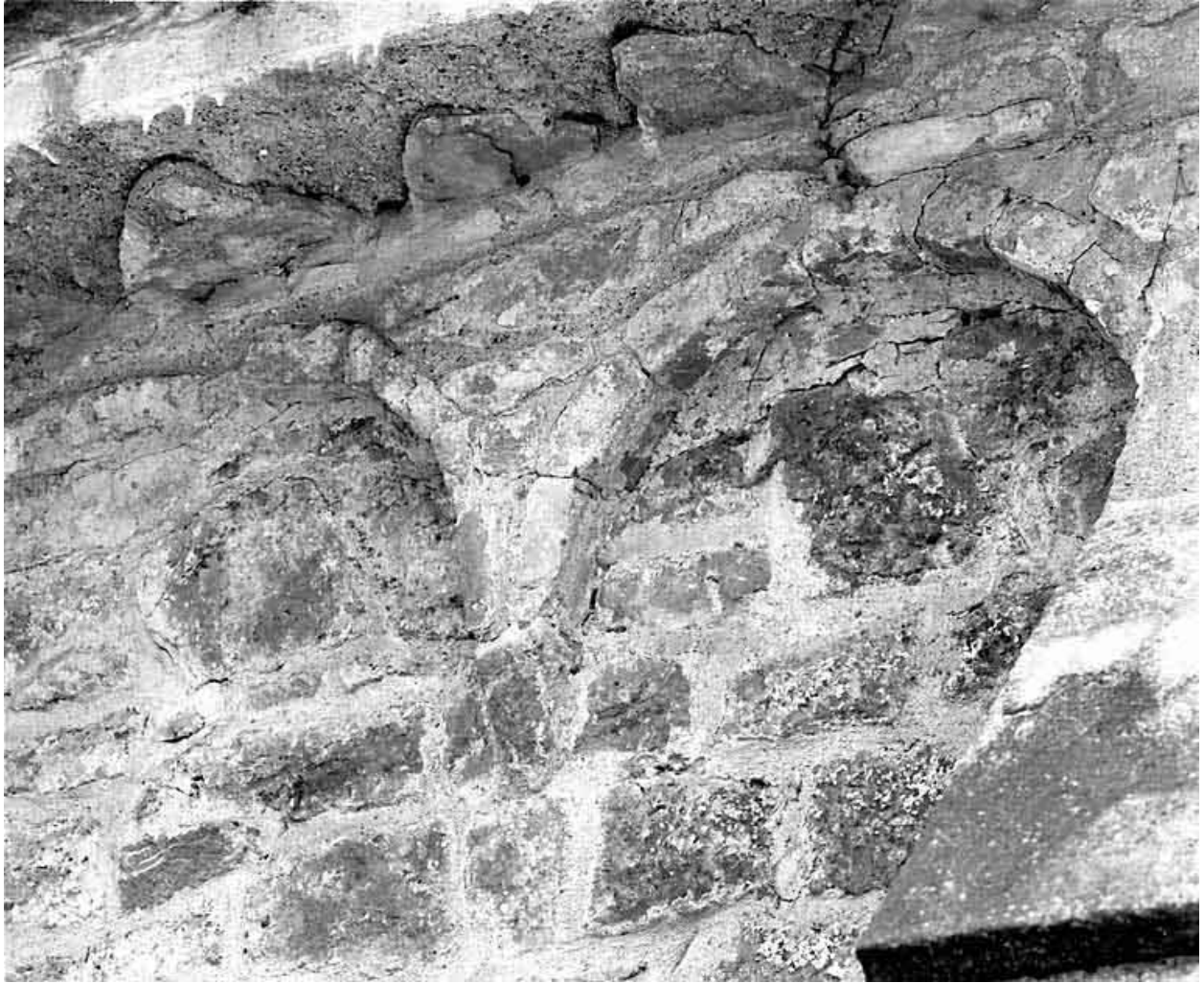
Eglise abbatiale : arceaux sur la 9eme travée du bas-côté nord.
