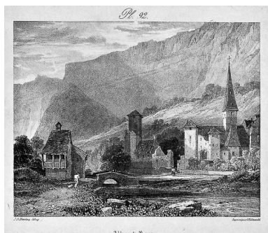
Vue d'ensemble Phot. IVR43_19763900395V
