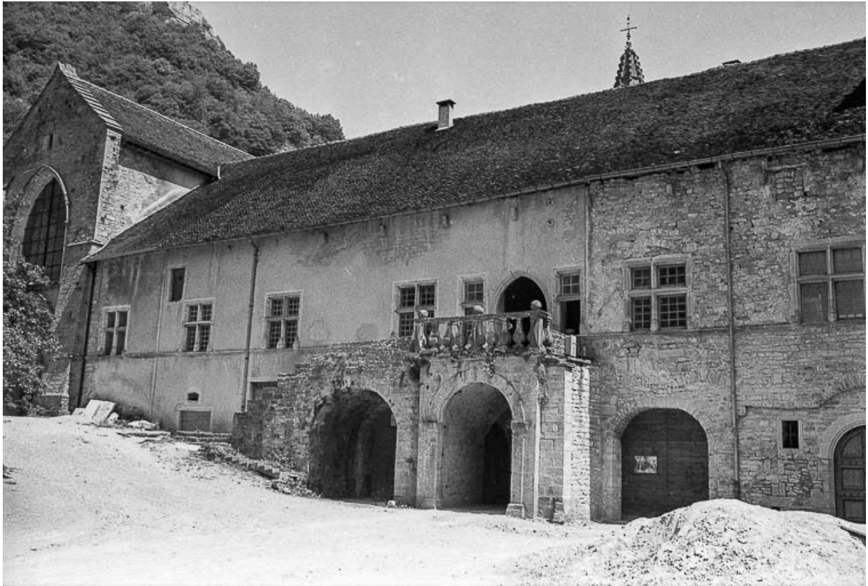
Logis abbatial : façade sur la grande cour, détail de la partie centrale
