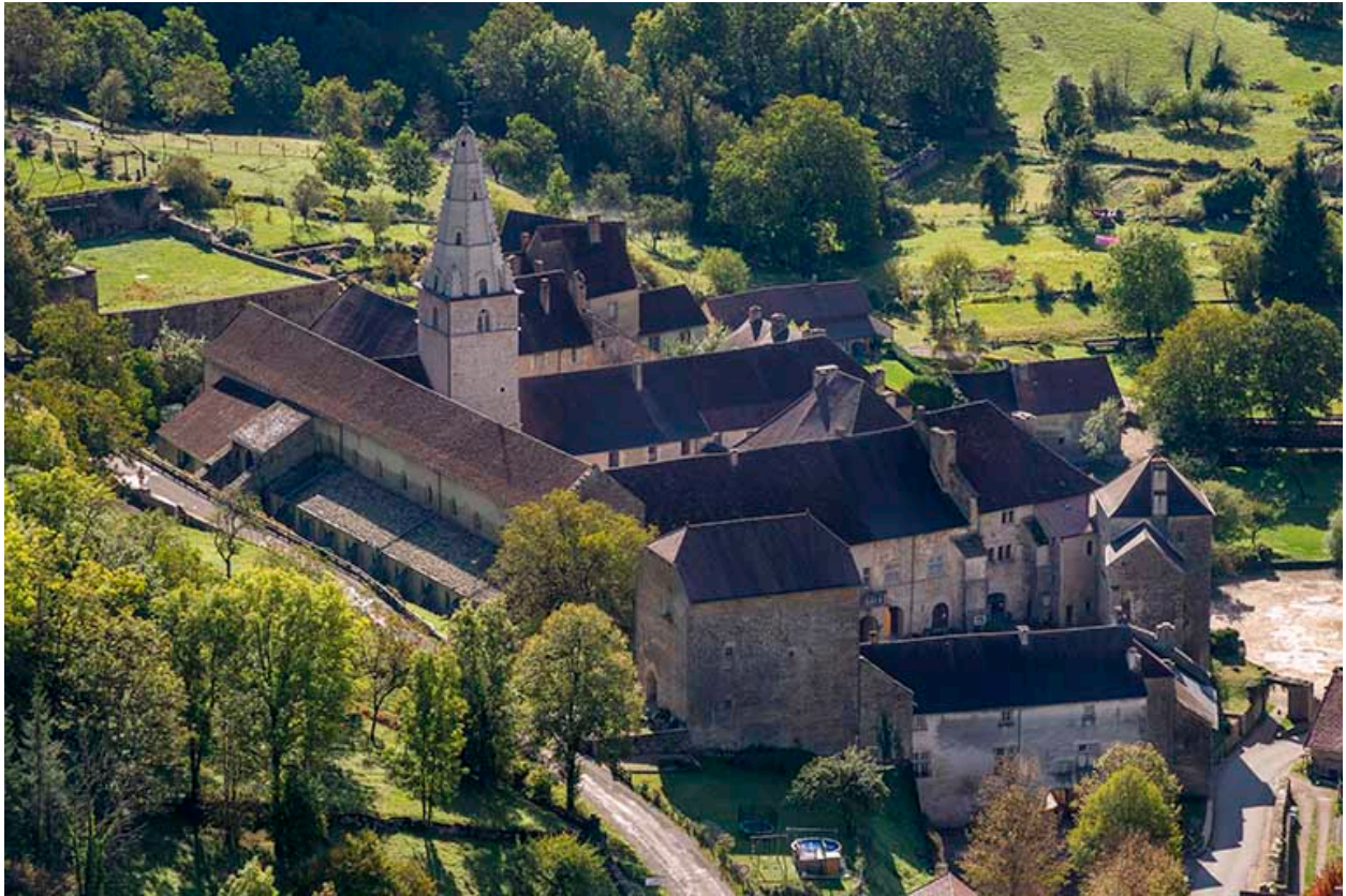
Vue de l'abbaye depuis Granges-sur-Baume en 2019.
