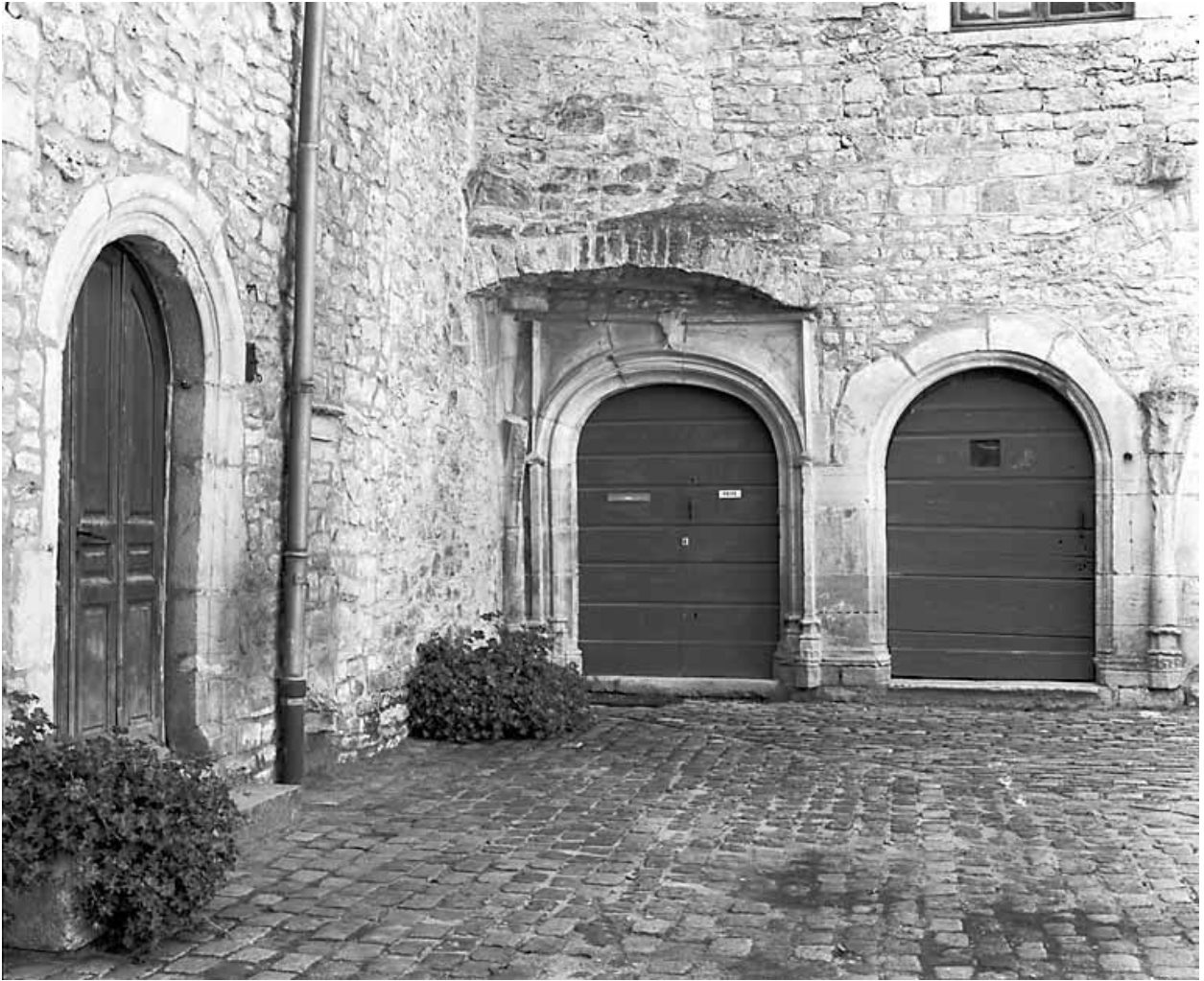
Le cloître : angle sud ouest.
