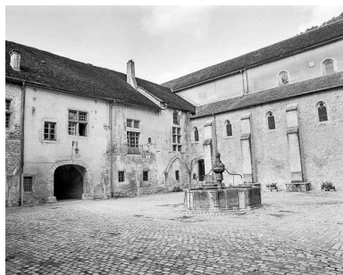
Cour du cloître : angle nord-est. Phot. Dominique Dominguez IVR43_19813900315X
