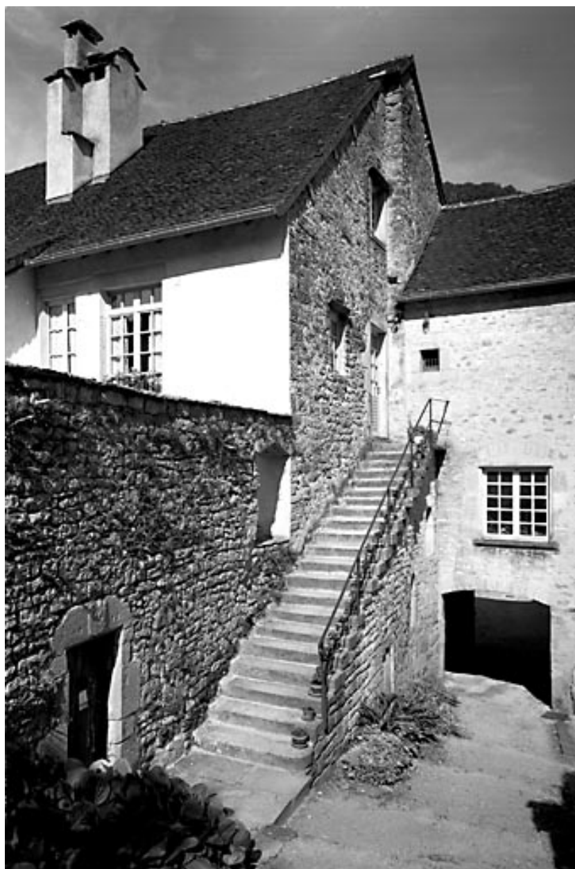
Détail : l'escalier d'une maison de chanoine.
