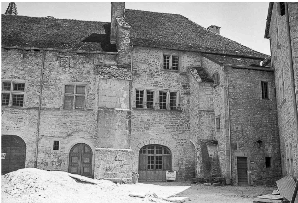
Logis abbatial : façade sur la grande cour, partie droite
