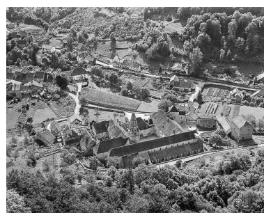
Vue générale depuis le relais de T.V. de Granges-sur-Baume. Phot. Dominique Dominguez IVR43_19813900310X
