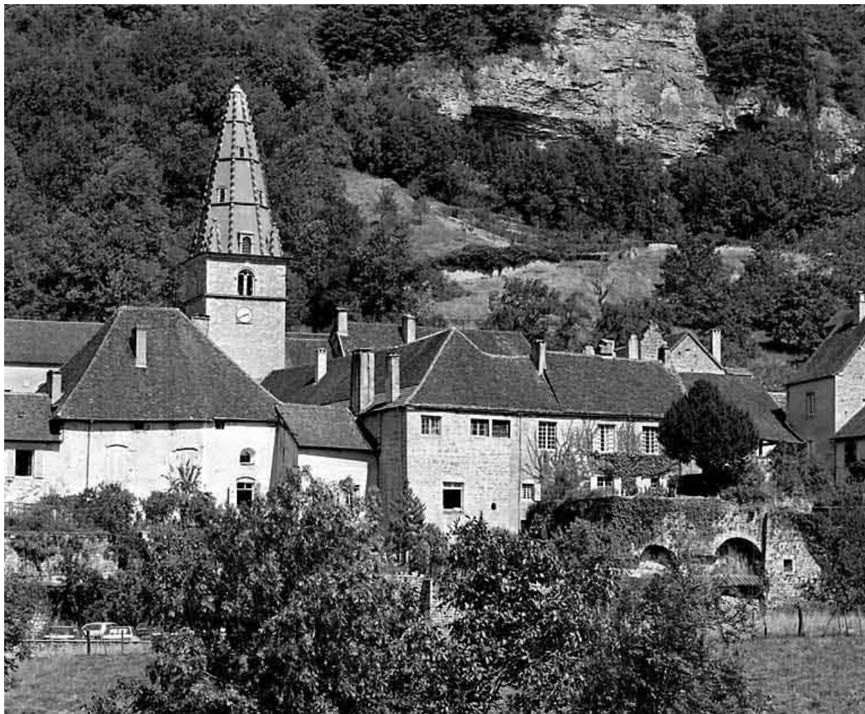
Face sud des bâtiments de l'aile sud du cloître et des maisons des chanoines.
