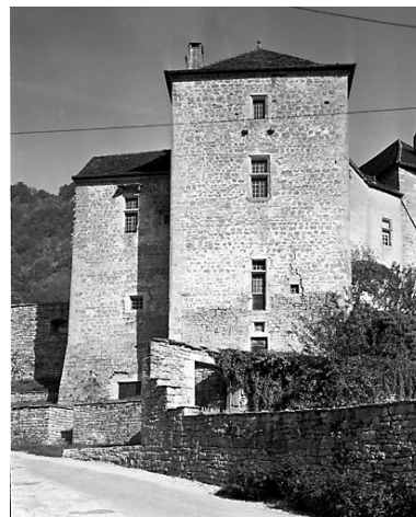
Face sud ouest de la tour de justice. Phot. Jérôme Mongreville IVR43_19903900960X
