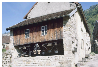
Extrémité sud est des maisons des chanoines. Phot. Jérôme Mongreville IVR43_19903900961XA
