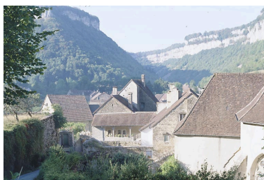
Face est des maisons des chanoines, vue générale. Phot. Jérôme Mongreville IVR43_19903900953XA
