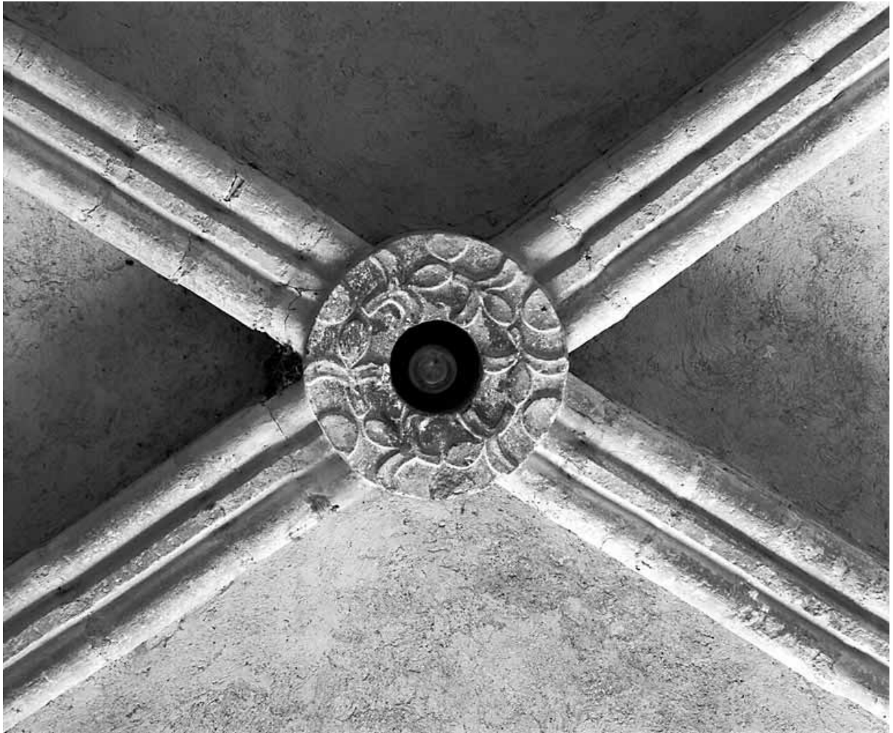
Eglise abbatiale : clef de voûte de la 2eme travée du vaisseau central.
