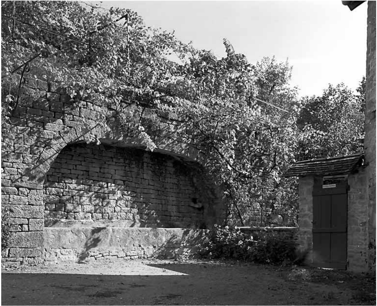
Fontaine à l'est des maisons des chanoines.
