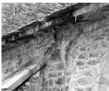
Eglise abbatiale : arceaux sur la 8eme travée du bas-côté nord.
