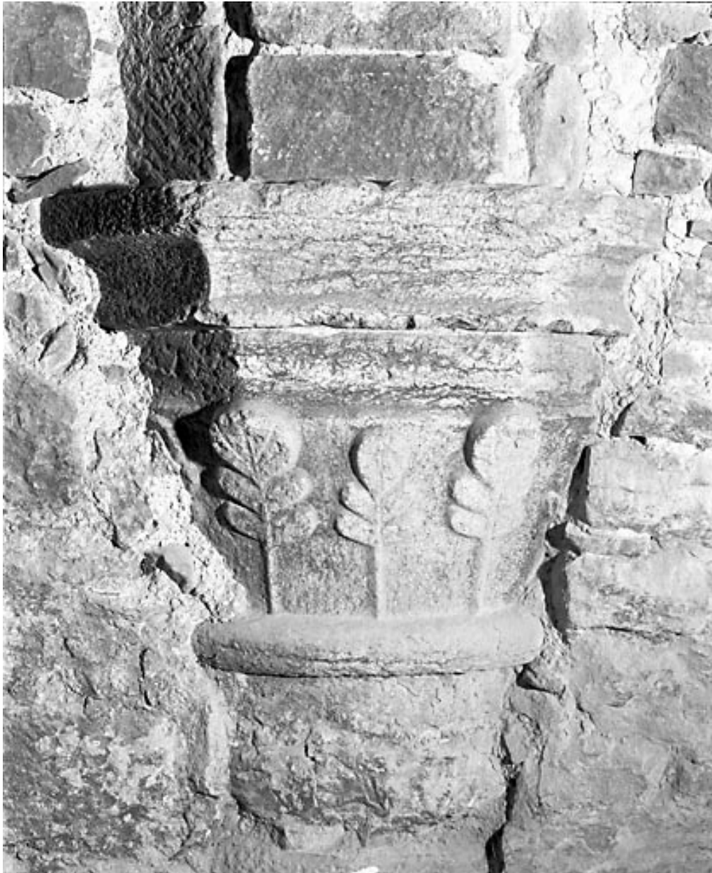
Chapiteau nord, entre la 3eme et la 4eme travée du passage sous le logis abbatial, vu de face.
