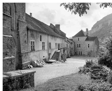
Quartier abbatial : élévation sur la grande cour, partie droite. Phot. Dominique Dominguez IVR43_19813900313X
