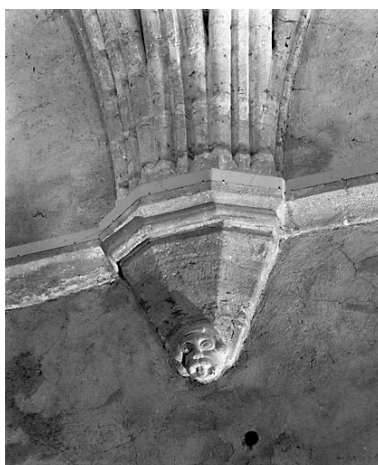
Eglise abbatiale : 6eme culot sud du vaisseau central. Phot. Jérôme Mongreville IVR43_19913900086X
