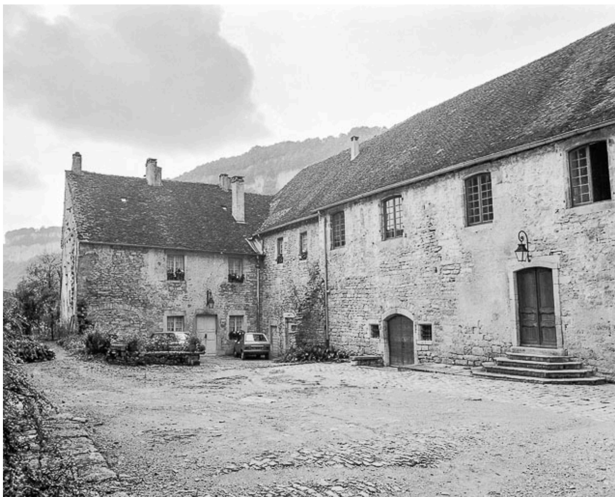
Angle sud-ouest de la cour des chamoines.
