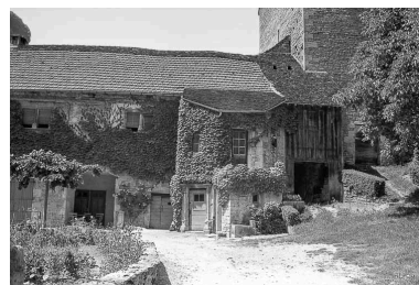
Hôtellerie vue depuis la cour intérieure. Phot. Guy Forestier IVR43_19743901043Z
