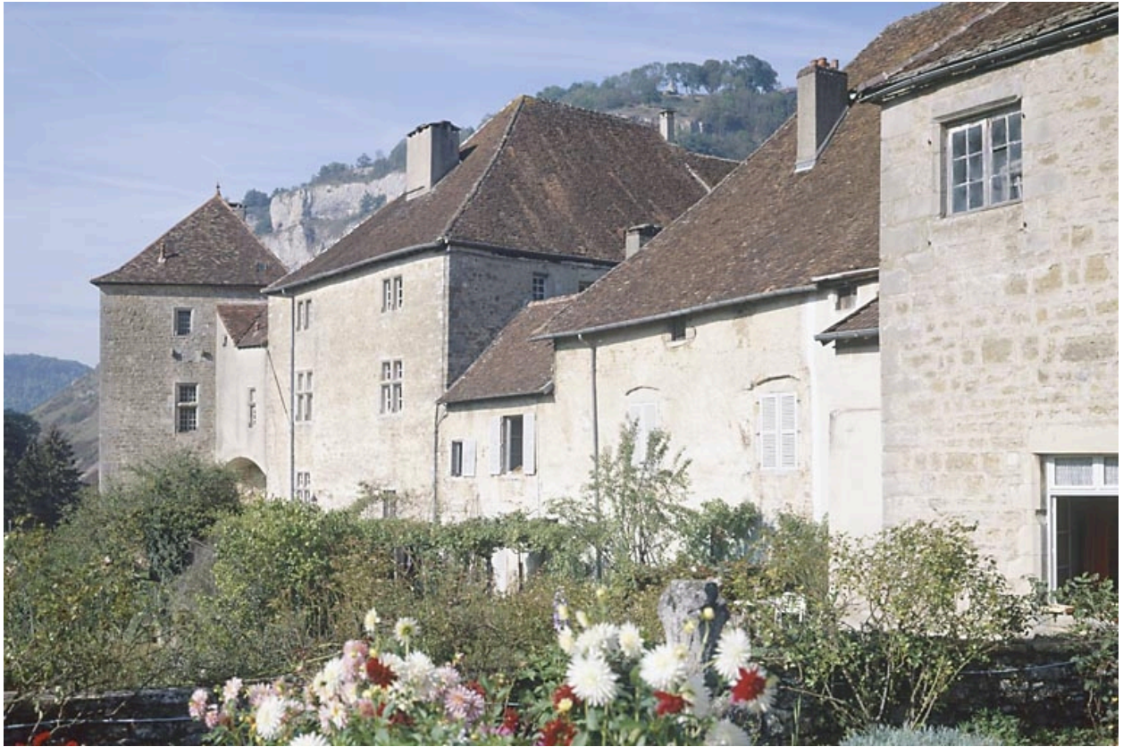
Face sud du quartier abbatial et des bâtiments au sud du cloître.
