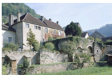
Face sud des maisons des chanoines. Phot. Jérôme Mongreville IVR43_19903900956XA
