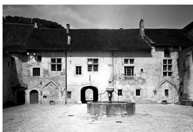
Côté ouest de la cour du cloître. Phot. Jérôme Mongreville IVR43_19913900110V
