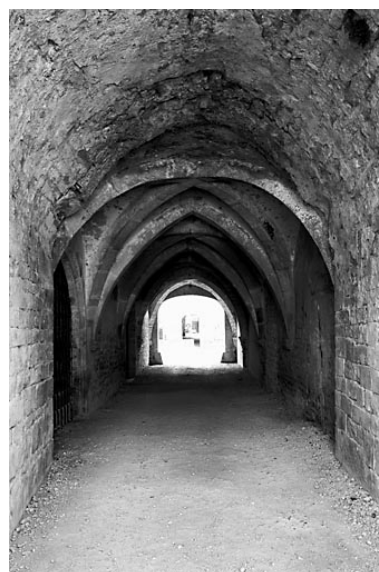
Passage sous le logis abbatial, vu de face. Phot. Jérôme Mongreville IVR43_19913900095V
