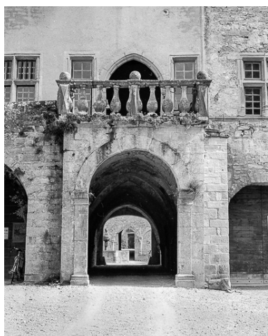
Quartier abbatial : détail du perron. Phot. Dominique Dominguez IVR43_19813900314X
