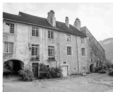
Côté est de la cour des chanoines. Phot. Dominique Dominguez IVR43_19813900322X
