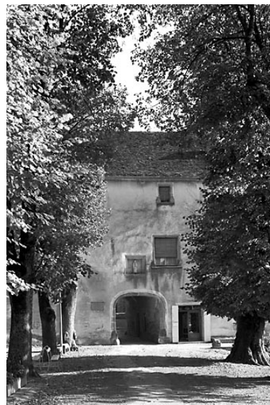
Porche d'entrée de l'abbaye. Phot. Jérôme Mongreville IVR43_19903900972V
