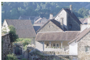
Face est des maisons des chanoines, détail. Phot. Jérôme Mongreville IVR43_19903900954XA
