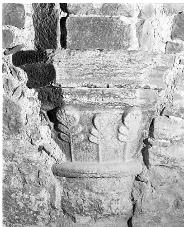
Chapiteau nord, entre la 3eme et la 4eme travée du passage sous le logis abbatial, vu de face. Phot. Jérôme Mongreville IVR43_19903900986X
