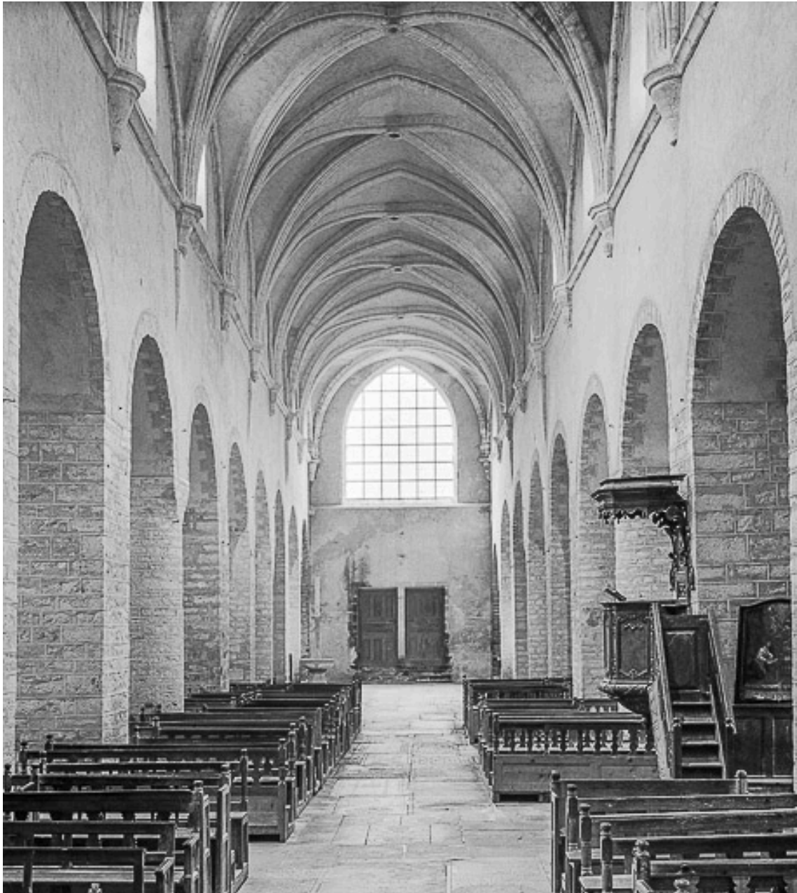
Abbatiale : vue de la nef depuis l'est.
