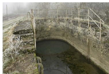
Entrée en siphon dans l'aqueduc parallèle au bief n ° 3 et n° 2, versant Saône. Phot. Alain Morelière IVR26_20082105439NUC2A
