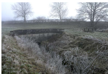
Sortie de l'aqueduc. Phot. Alain Morelière IVR26_20082105440NUC2A
