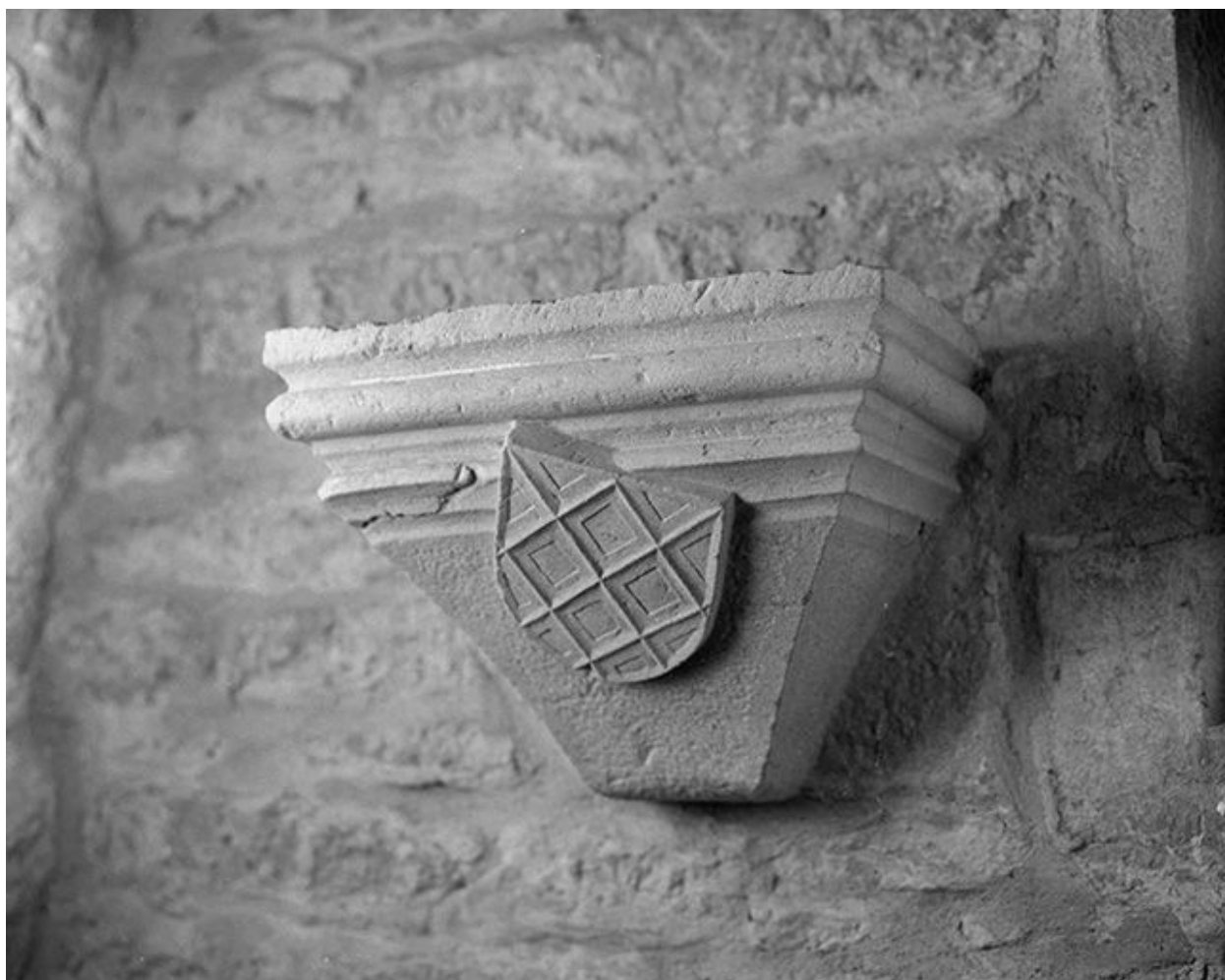
Intérieur : chapelle, mur est, console gauche.
