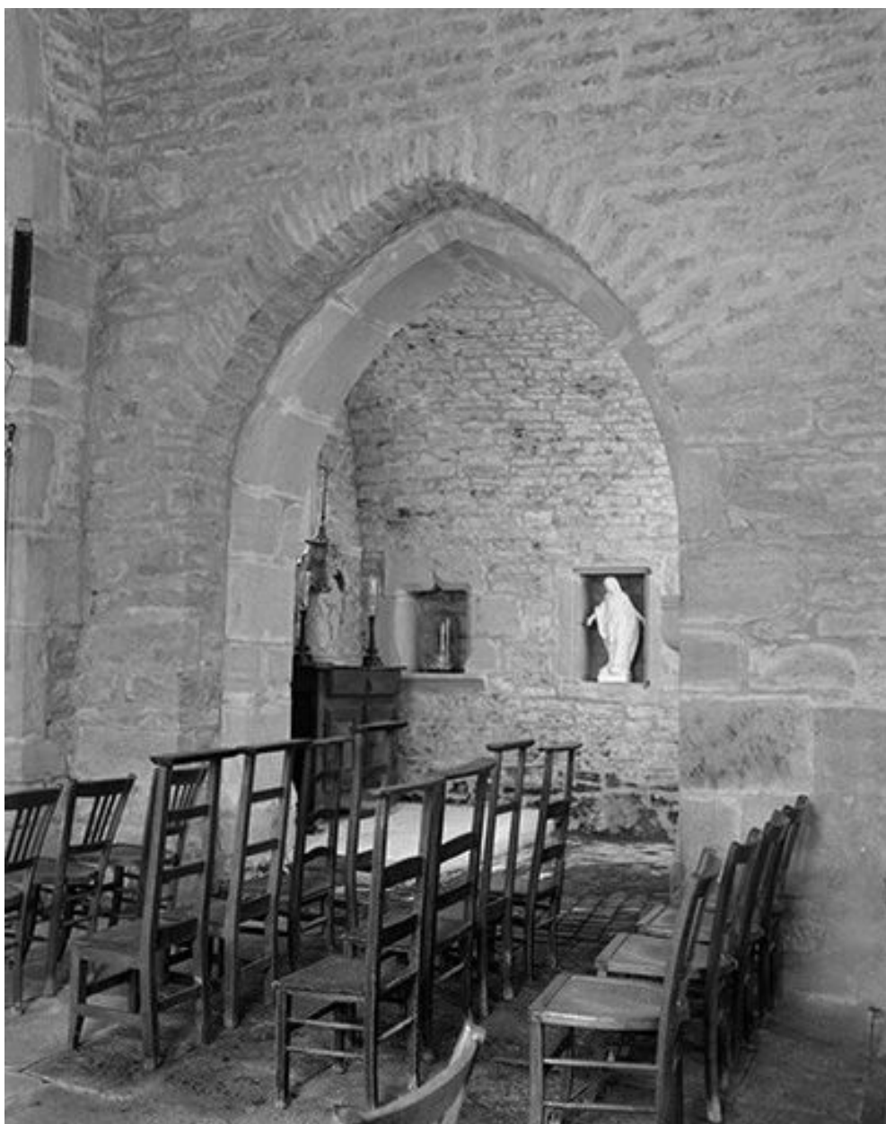
Arc d'entrée de la chapelle latérale.
