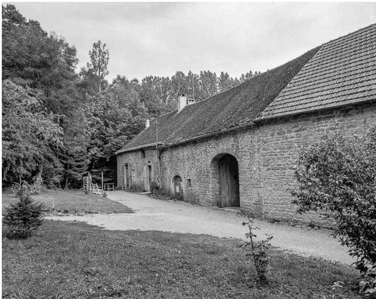
Façade sur cour.
