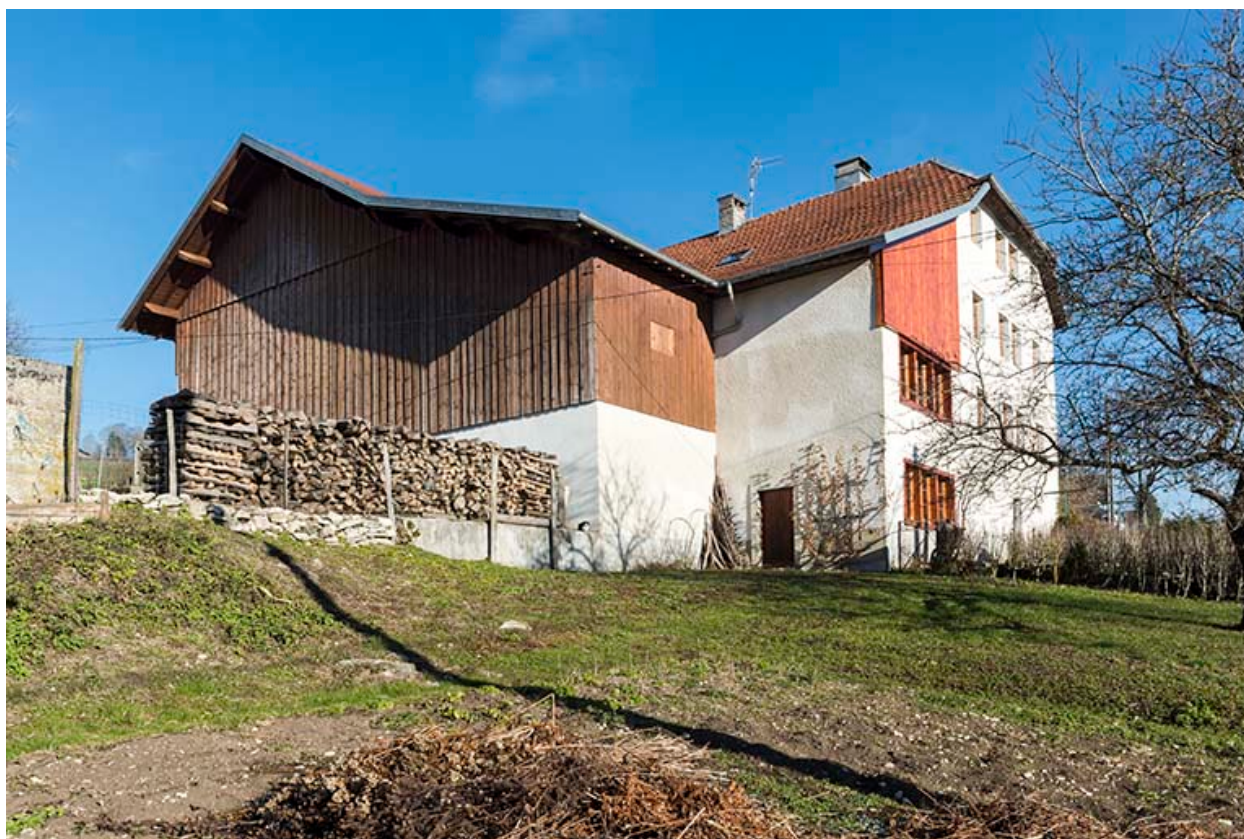
Façades postérieure et latérale gauche.
