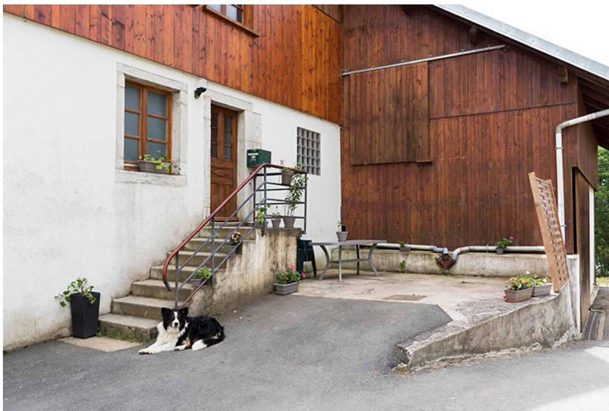
Façade latérale droite : escalier extérieur et étable.
