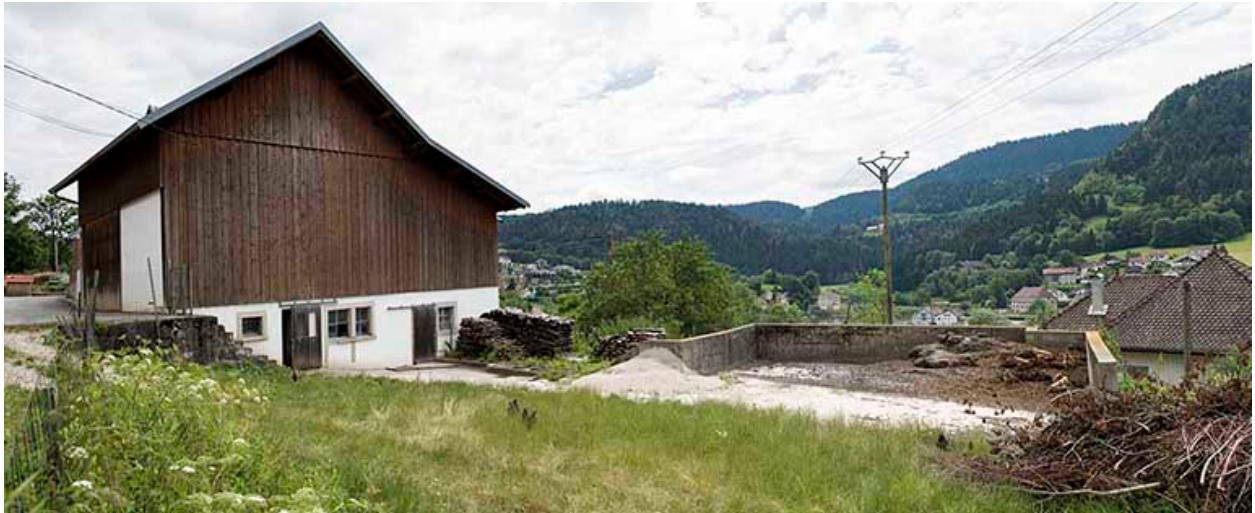
Façade postérieure de l'étable.
