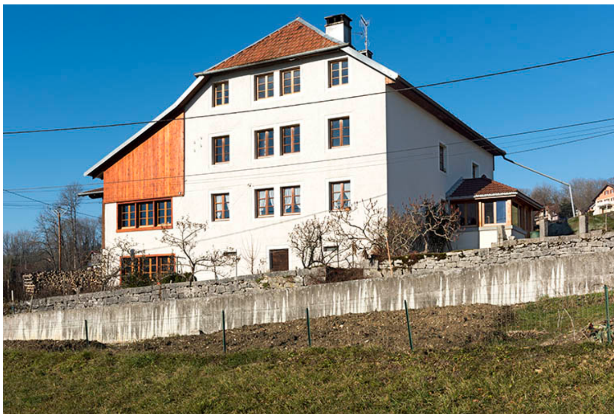
Façades antérieure et latérale gauche.
