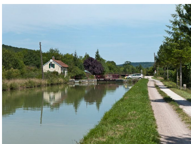
Vue du site d'écluse depuis l'amont Phot. Pierre-Marie Barbe-Richaud IVR26_20112103785NUC4AQ
