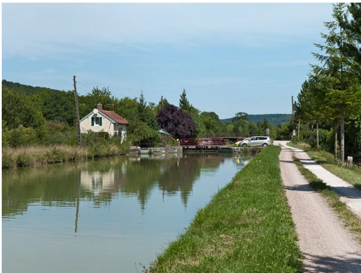
Vue du site d'écluse depuis l'amont
