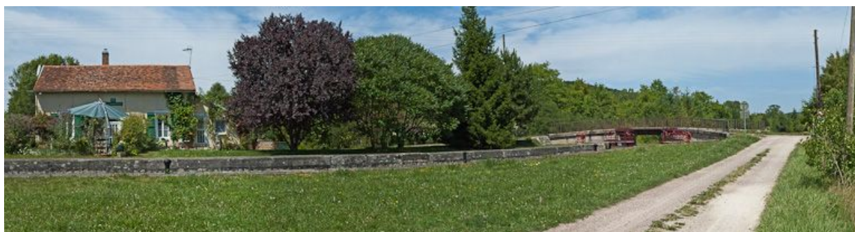
Vue d'ensemble du site d'écluse.
