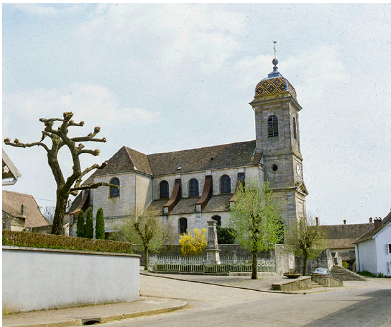
Façade laérale gauche.
