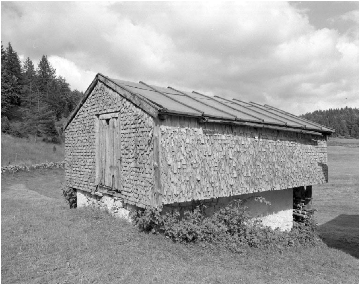
L'accès à l'étage de la resserie.
