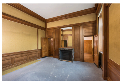
Bureau du directeur, vue actuelle. Phot. Pierre-Marie Barbe-Richaud IVR26_20235800060NUC4A
