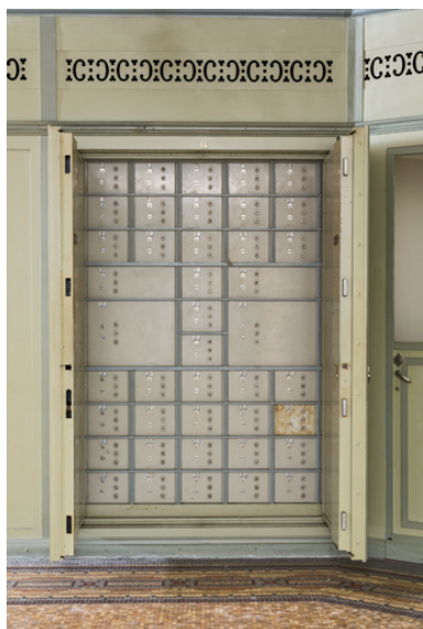
Salle des coffres, armoire coffre-fort. Phot. Pierre-Marie Barbe-Richaud IVR26_20235800081NUC4A
