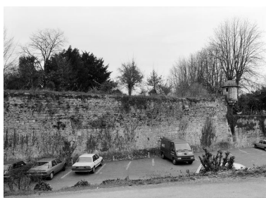
Bastion Sainte-Agathe (ou Sainte-Anne) : parapet sud et échauguette (1988). Phot. Jean-Luc Duthu IVR26_19882101009V
