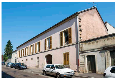
Angle sud-est de la cantine, 4 rue Rossen. Phot. Mary Ruffinoni IVR43_20137000889NUC4A
