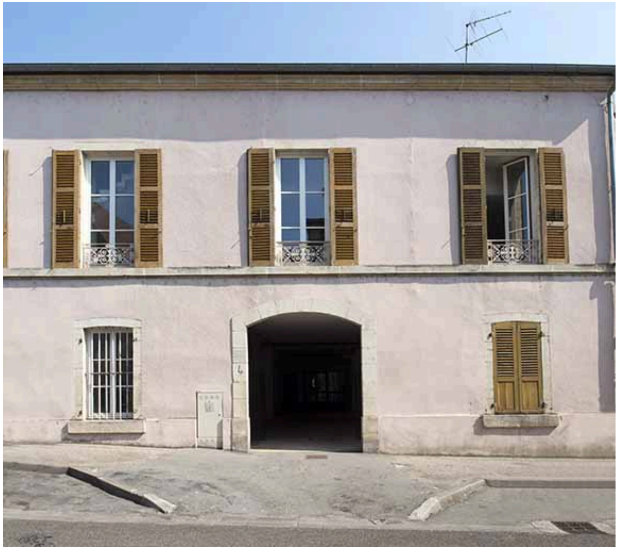
Entrée de la cantine 4 rue Rossen.
