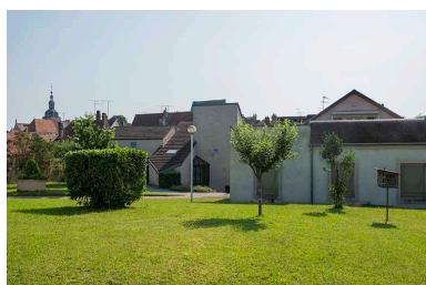
Vue d'ensemble des façades postérieures nord-ouest de la cantine. Phot. Mary Ruffinoni IVR43_20137000885NUC4A
