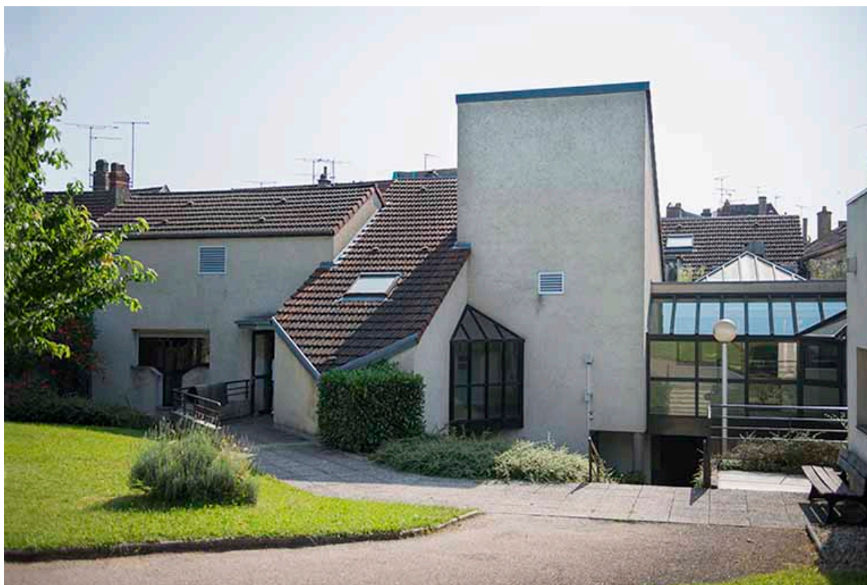
Façade ouest des cuisines.
