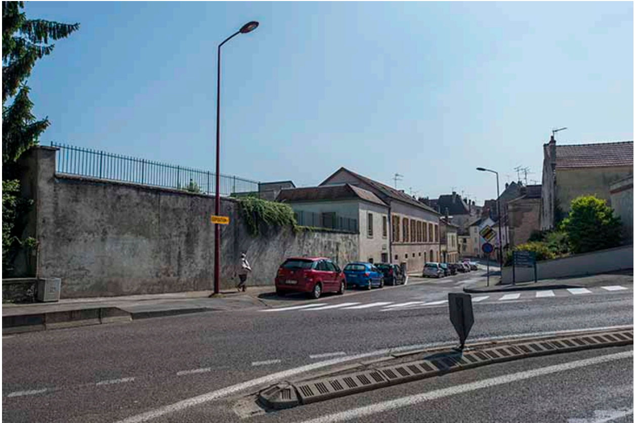
Vue d'ensemble depuis l'ouest sur la façade antérieure de la cantine, rue Rossen.
