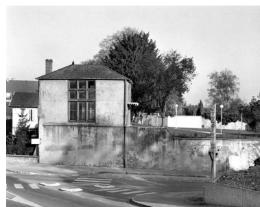
Fabrique de jardin : façade latérale gauche en 1989. Phot. Yves Sancey IVR43_19897000266X
