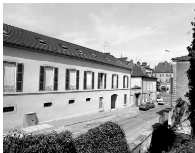
Façade antérieure de trois quarts gauche en 1989. Phot. Yves Sancey IVR43_19897000262X
