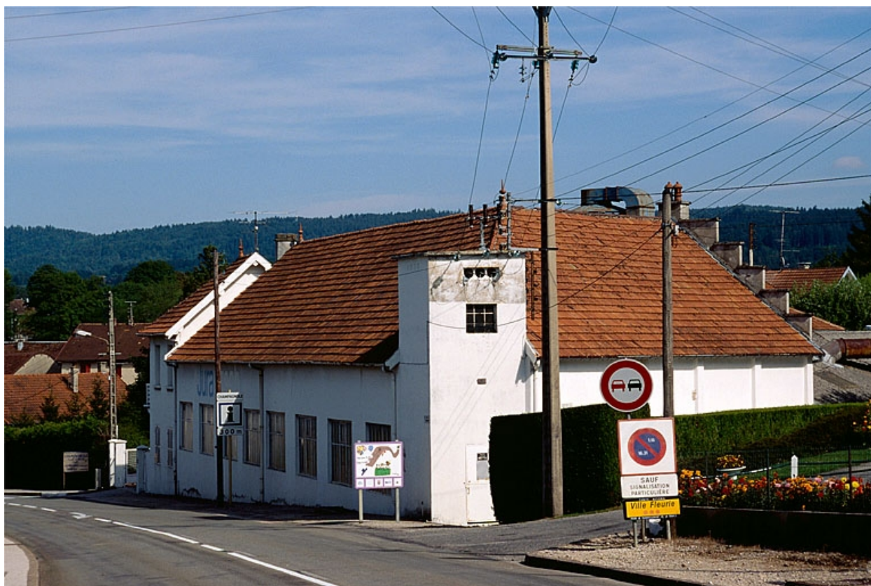
Atelier de fabrication rue Progin.
