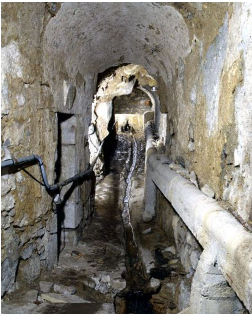
Conduit hydraulique des infirmeries vu depuis l'entrée.
