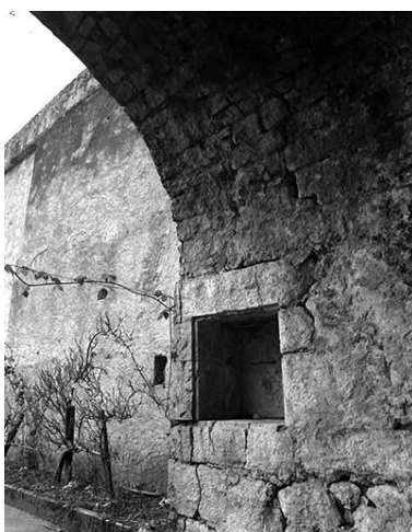
Arc de l'abside et armoire liturgique de la chapelle Saint-Sébastien. Phot. Yves Sancey IVR43_20013900229X
