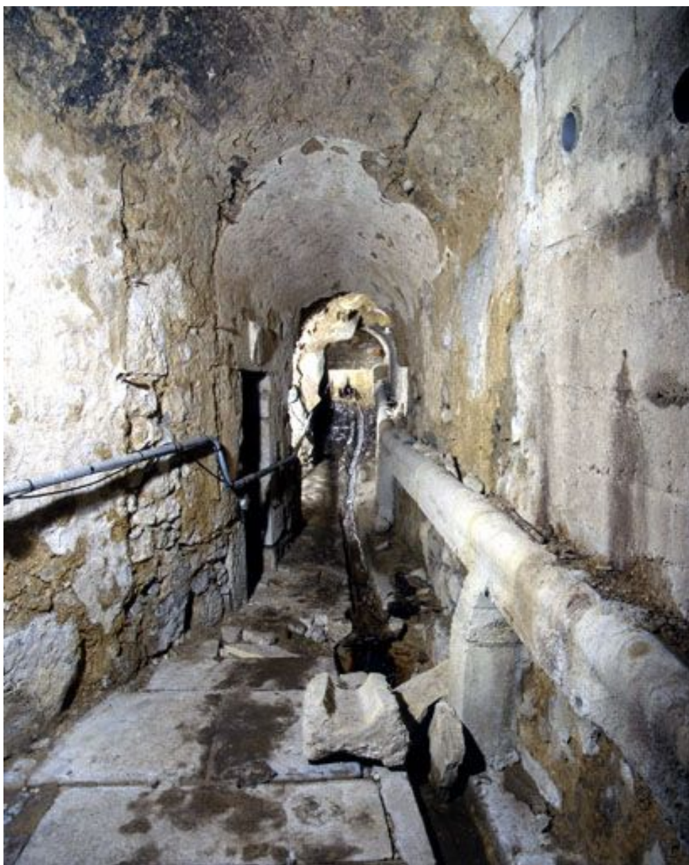
Conduit hydraulique des infirmeries vu depuis l'entrée.
