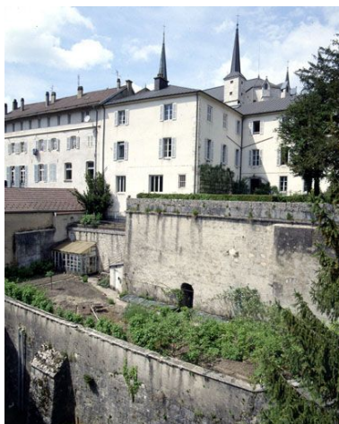
Vue générale des façades postérieures. Phot. Yves Sancey IVR43_20013900376XA
