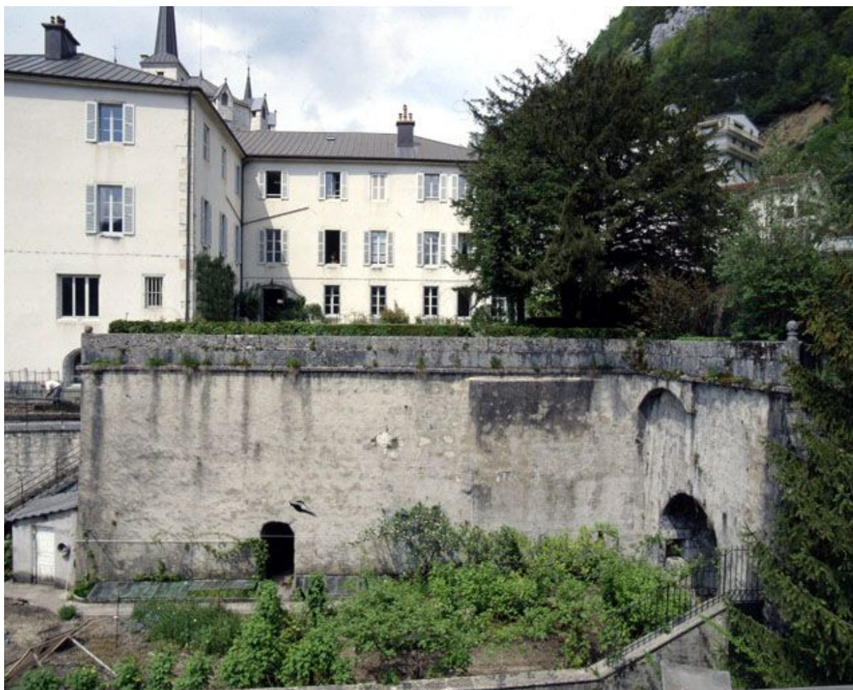
Vue générale du soubassement du jardin.
