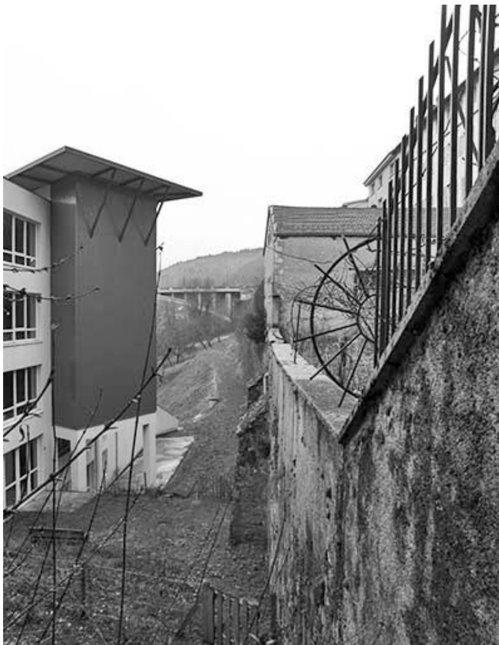
Mur sud de la clôture.
