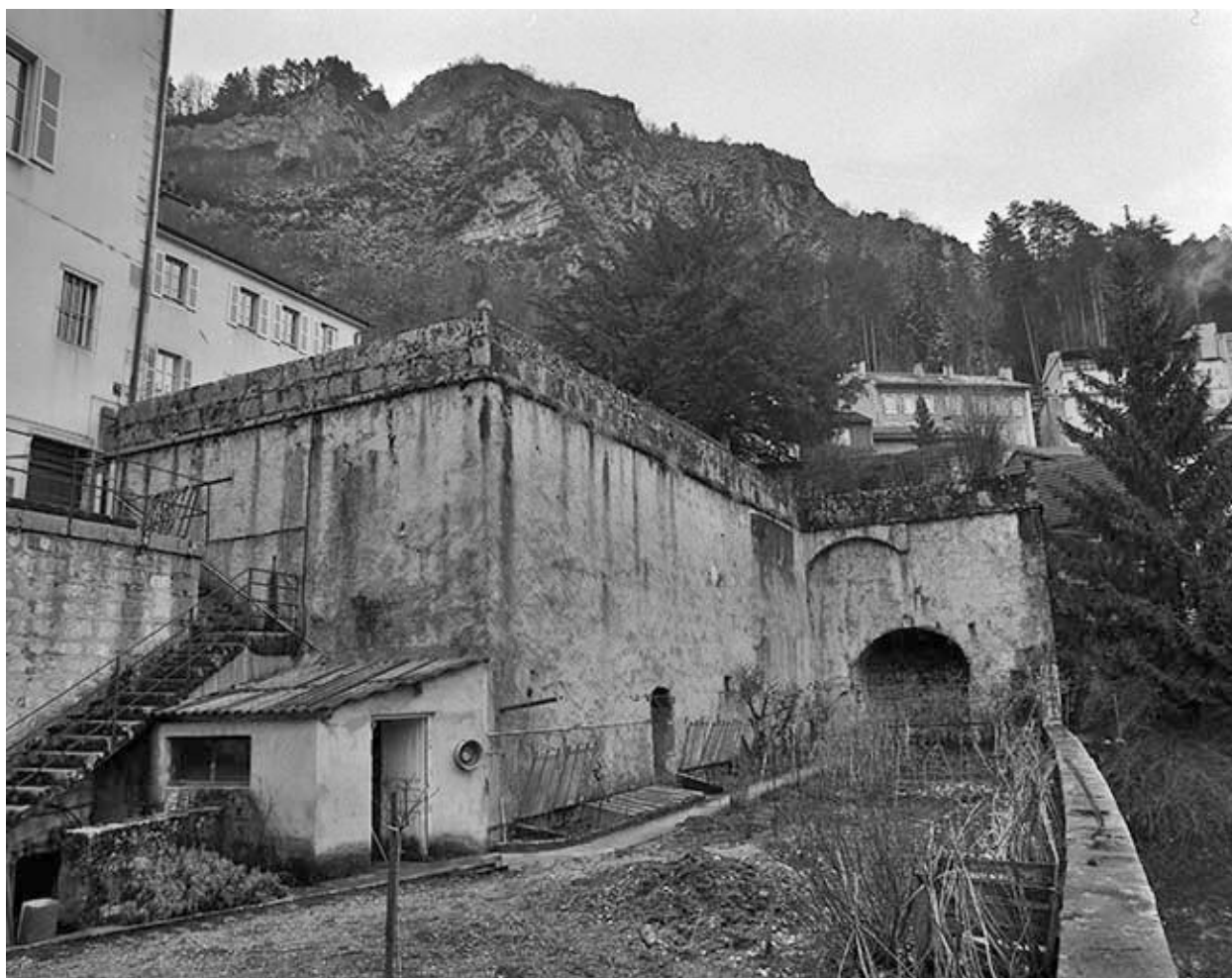
Mur de soubassement du jardin.
