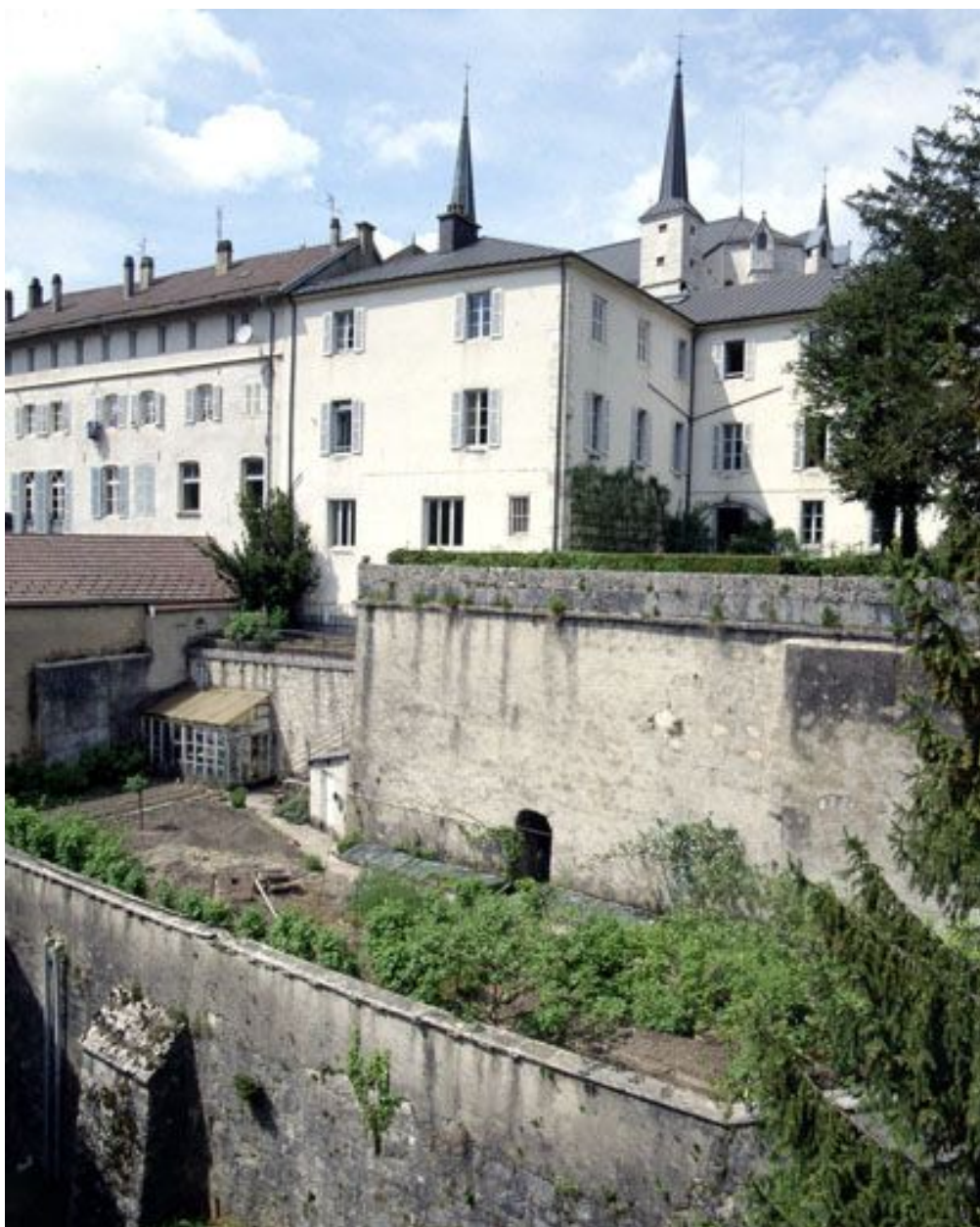
Vue générale des façades postérieures.
