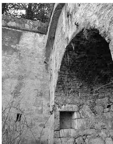
Arc de l'abside et armoire liturgique de la chapelle Saint-Sébastien. Phot. Yves Sancey IVR43_20013900228X
