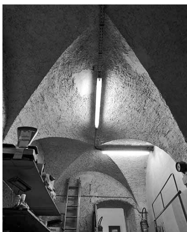
Voûtes de la pièce à gauche du hall. Phot. Yves Sancey IVR43_20013900067X
