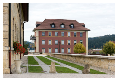
Façade latérale gauche.
