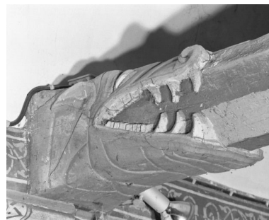
Charpente de la nef, engoulant gauche du 3ème entrait Phot. Jean-Luc Duthu IVR26_19852101002X
