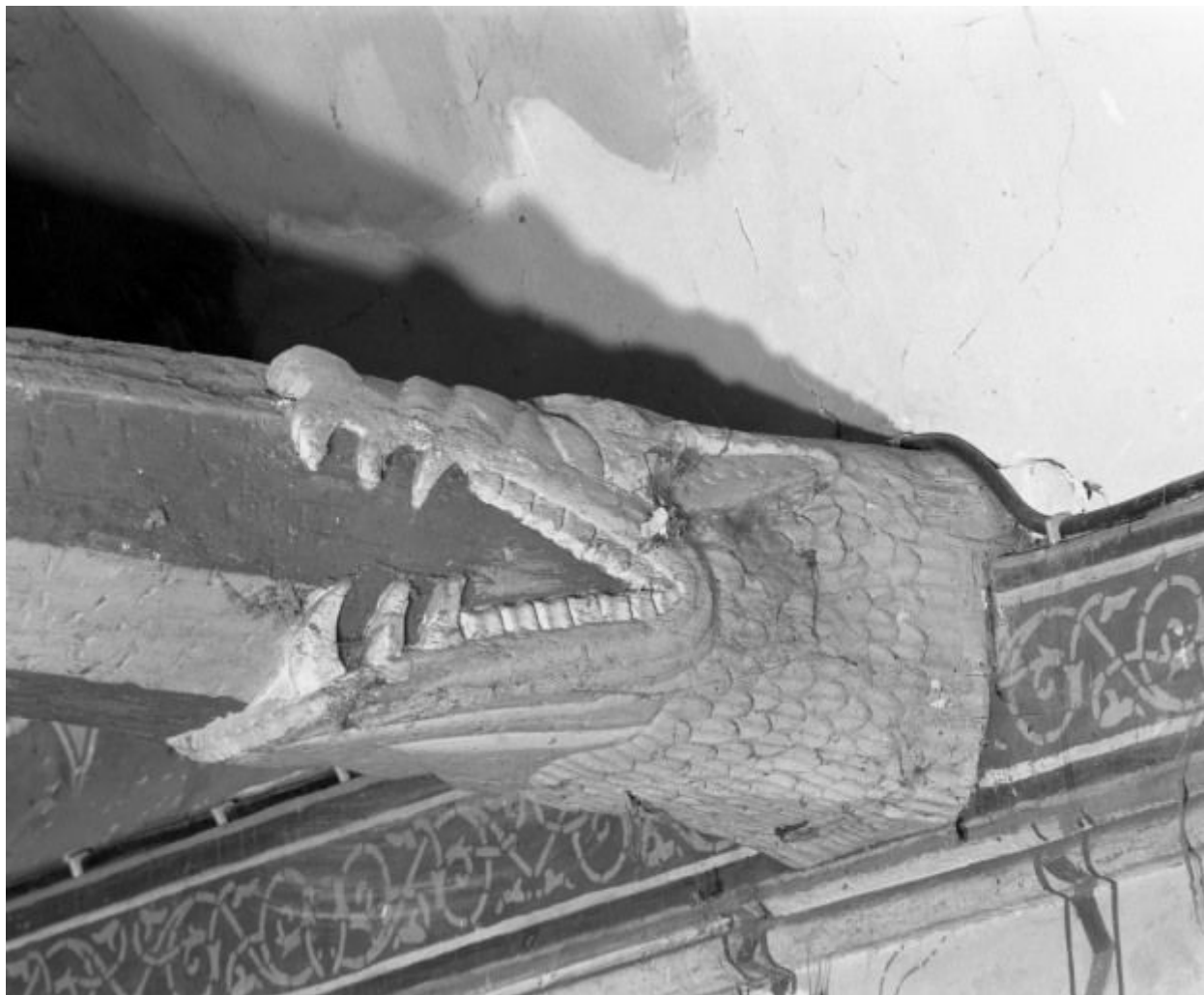
Charpente de la nef, engoulant gauche du 2ème entrain
