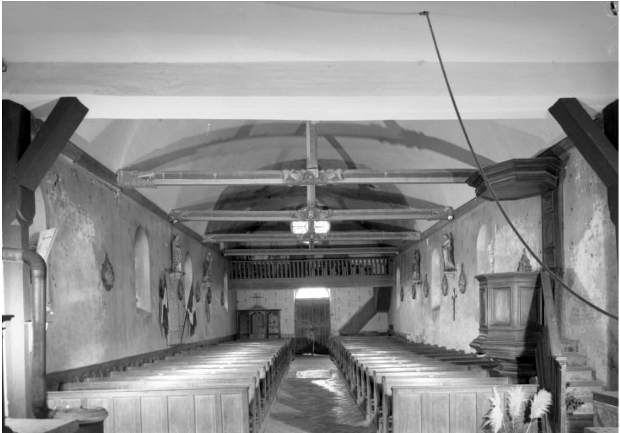
Vue intérieure prise du chœur
