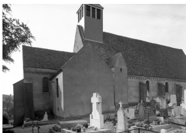
Elévation gauche, chœur et sacristie Phot. Michel Thierry IVR26_19852100989V
