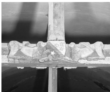
Charpente de la nef, décor du 4ème entrait Phot. Jean-Luc Duthu IVR26_19852101004X
