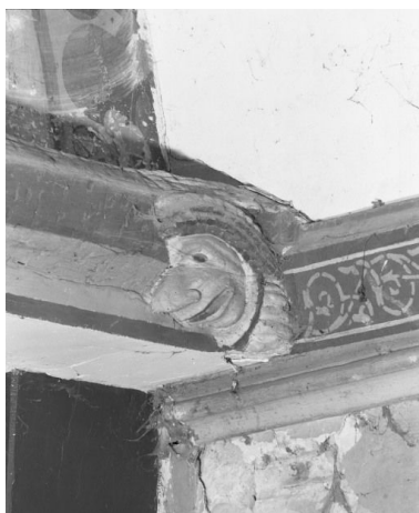
Charpente de la nef, extrémité droite du 5ème entrait Phot. Jean-Luc Duthu IVR26_19852101008X
