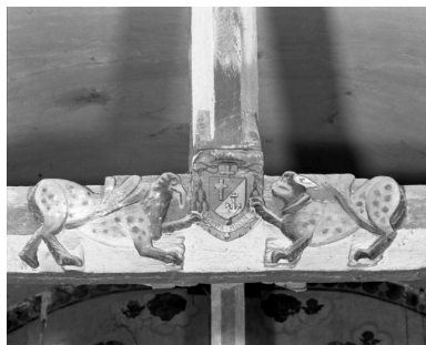
Charpente de la nef, décor du 3ème entrait Phot. Jean-Luc Duthu IVR26_19852101000X
