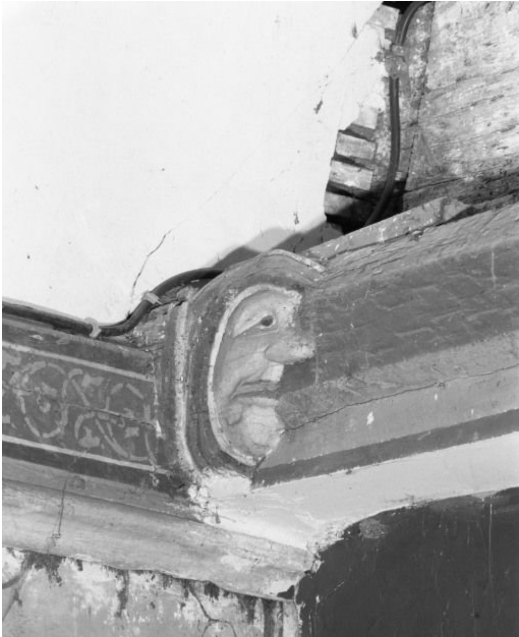
Charpente de la nef, extrémité du 5ème entrain
