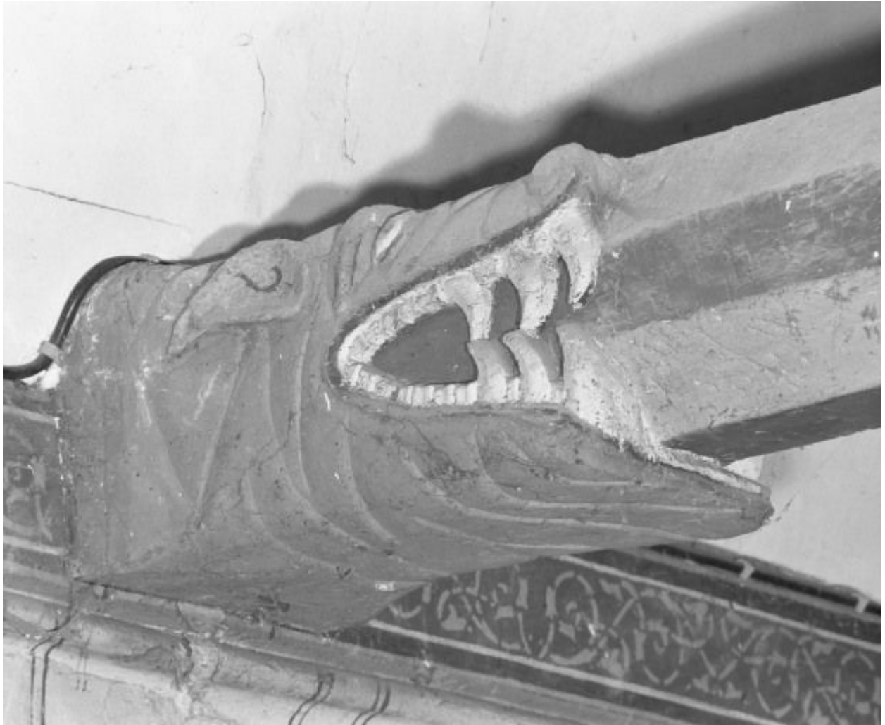
Charpente de la nef, engoulant gauche du 4ème entrain
