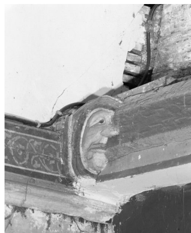
Charpente de la nef, extrémité du 5ème entrait Phot. Jean-Luc Duthu IVR26_19852101007X
