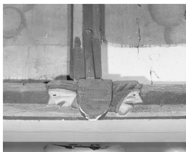
Charpente de la nef, décor central du 5ème entrait Phot. Jean-Luc Duthu IVR26_19852101006X
