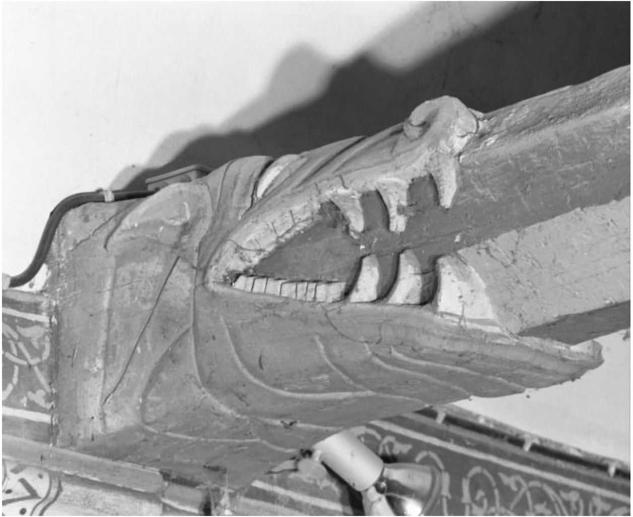
Charpente de la nef, engoulant gauche du 3ème entrait
