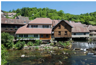
Façades sud. Phot. Jérôme Mongreville IVR43_20152501498NUC4A
