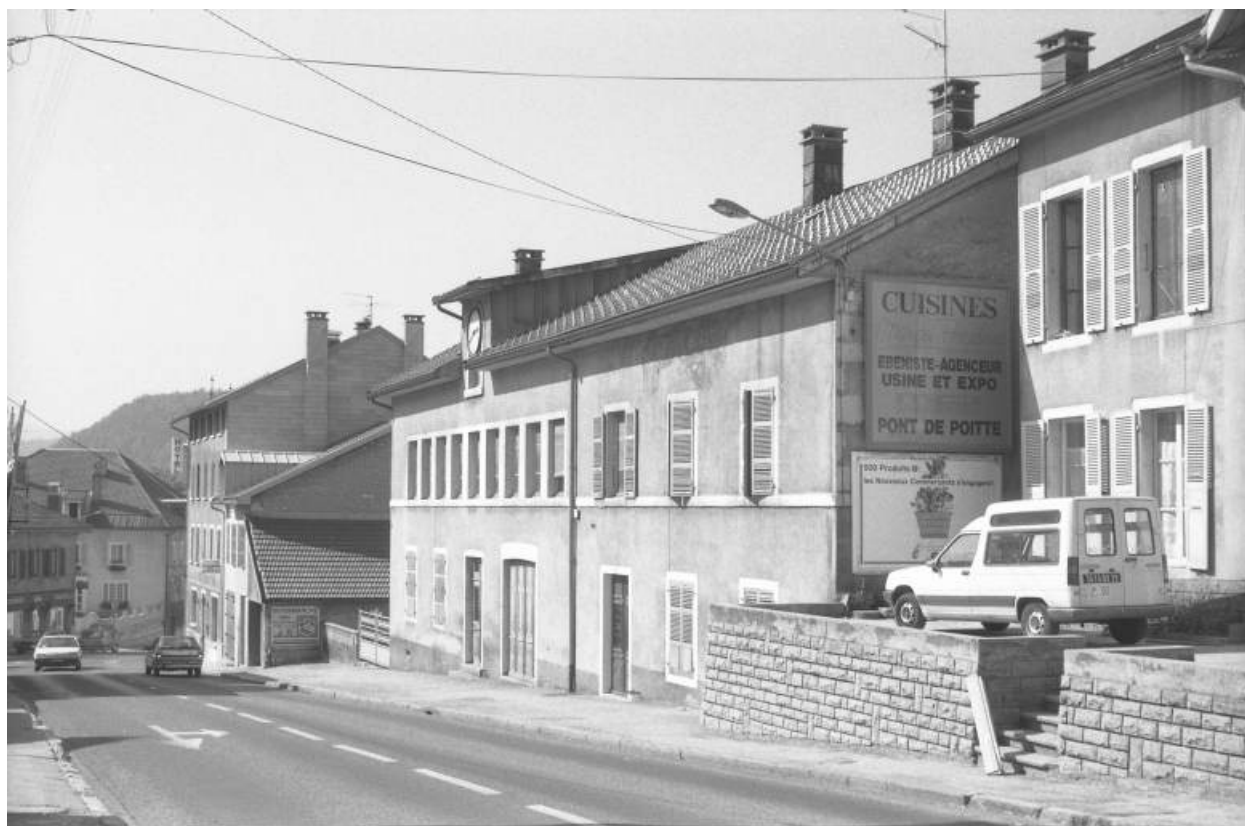
Vue d'ensemble de la façade antérieure.
