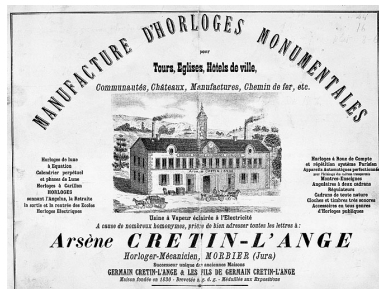
Façade antérieure de l'usine Cretin-l'Ange. Phot. Jérôme Mongreville IVR43_19913900251X
