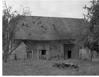
Façade antérieure : partie gauche. Phot. Dominique Dominguez IVR43_19803900259X
