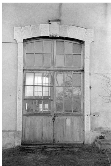
Porte d'entrée de la centrale hydroélectrique. Phot. Laurent Poupard IVR43_19883900266Z
