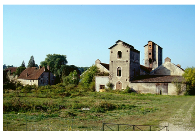
Vue d'ensemble depuis le nord : logement patronal (I) et atelier de fabrication. Phot. Yves Sancey
