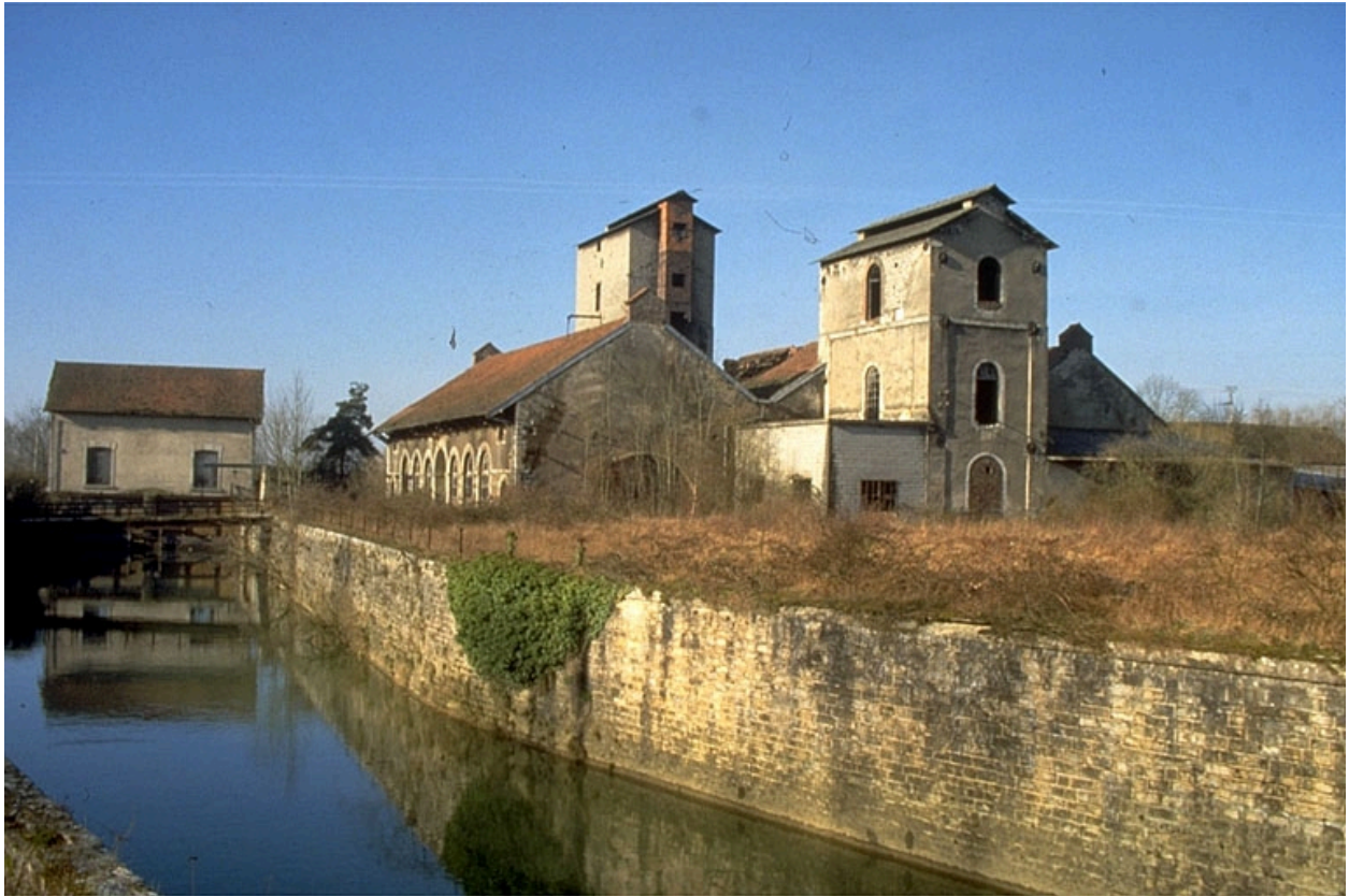
Vue d'ensemble depuis l'est : centrale hydroélectrique (G) et atelier de fabrication (E).
