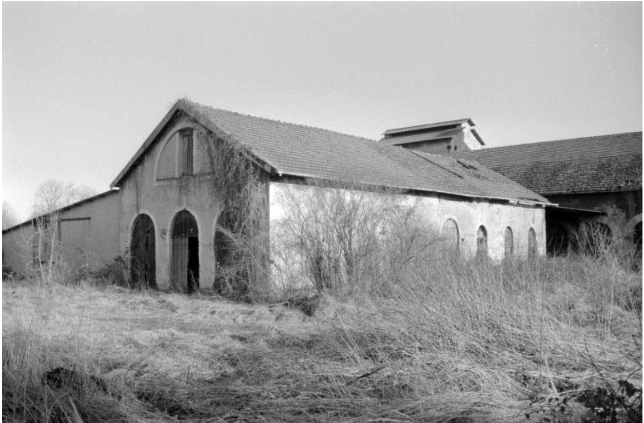
Façades postérieure et latérale gauche de la salle des machines.
