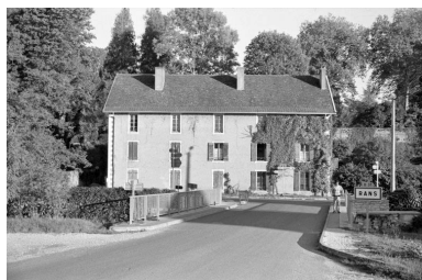
Façade antérieure du logement d'ouvriers (J). Phot. Laurent Poupard IVR43_19883900269Z
