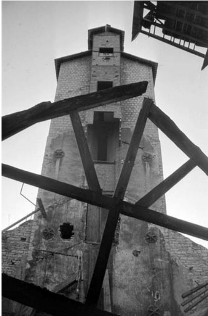
Monte-charge du haut-fourneau au coke (F), vu depuis la halle centrale.
