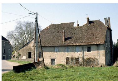
Façade antérieure du logement patronal (I). Phot. Laurent Poupard IVR43_19883900267ZA
