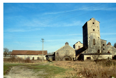
Vue d'ensemble depuis l'ouest : salle des machines (A) et atelier de fabrication. Phot. Laurent Poupard
