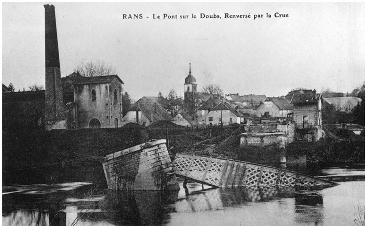
Rans - Le Pont sur le Doubs, Renversé par la Crue.
