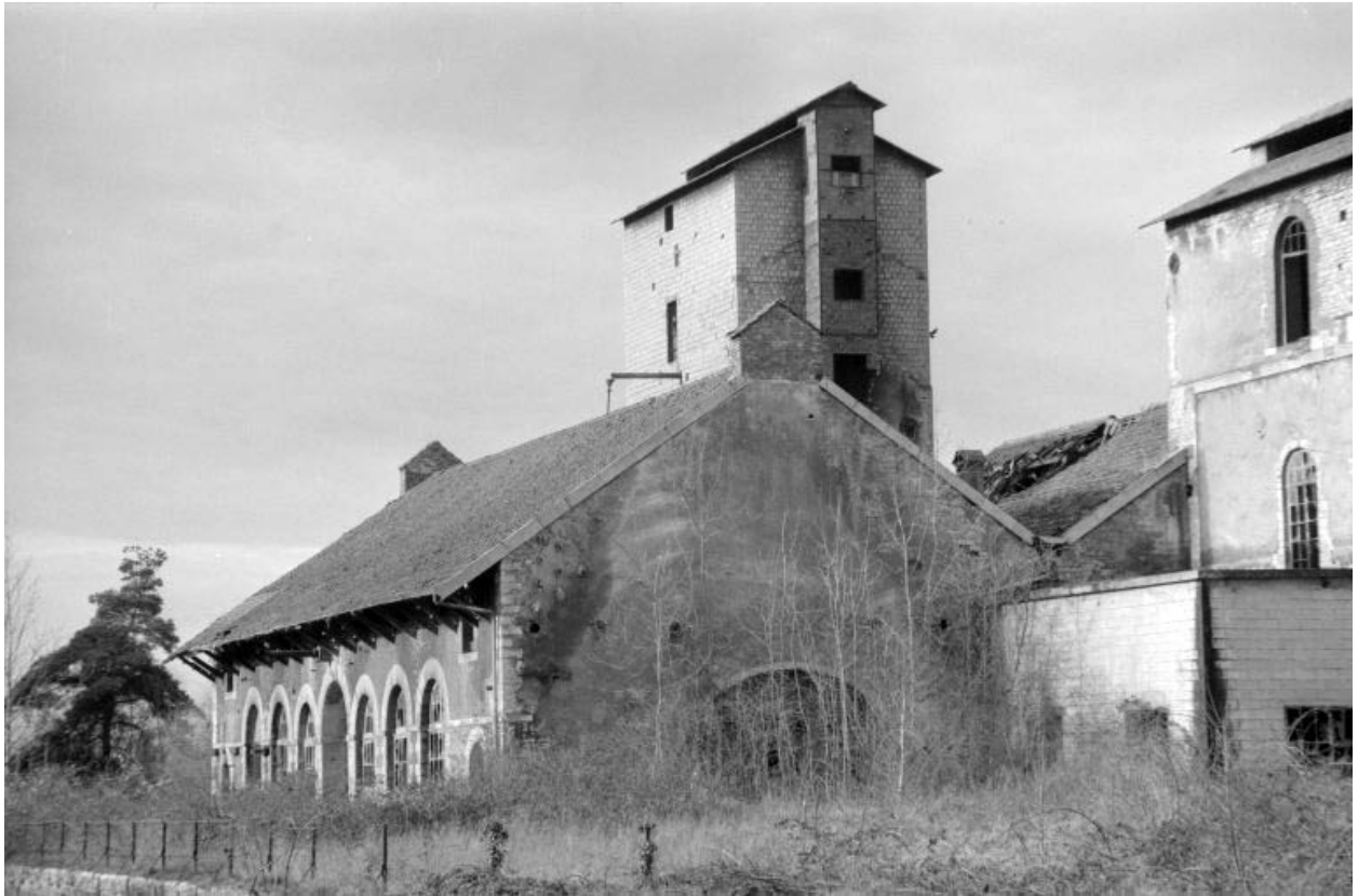
Atelier de fabrication : halle de coulée (e3) vue de l'est.
