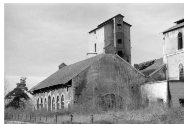
Atelier de fabrication : halle de coulée (e3) vue de l'est. Phot. Laurent Poupard IVR43_19883900258Z
