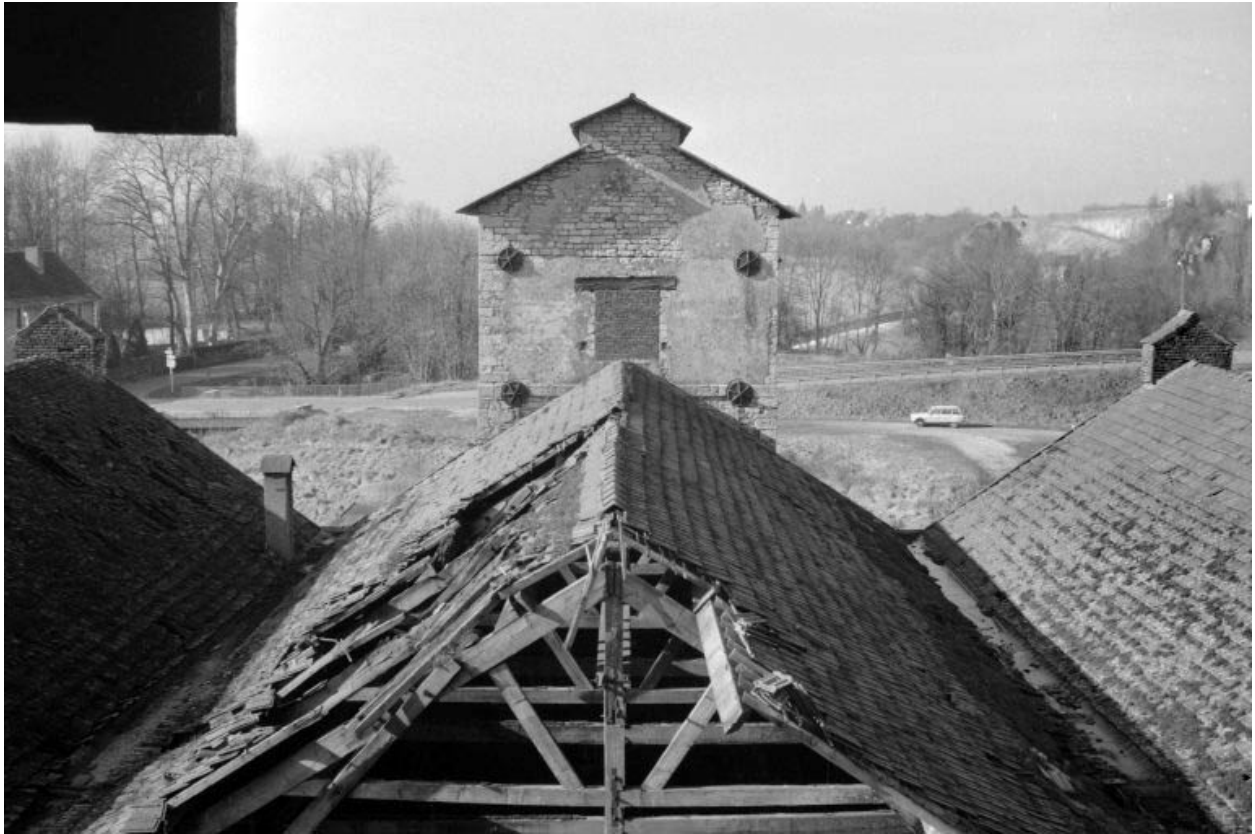
Toiture de la halle centrale de l'atelier de fabrication et monte-charge (D).
