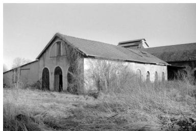
Façades postérieure et latérale gauche de la salle des machines. Phot. Laurent Poupard IVR43_19883900257Z
