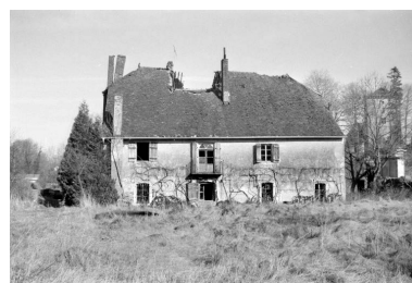
Façade postérieure du logement patronal. Phot. Laurent Poupard IVR43_19883900268Z
