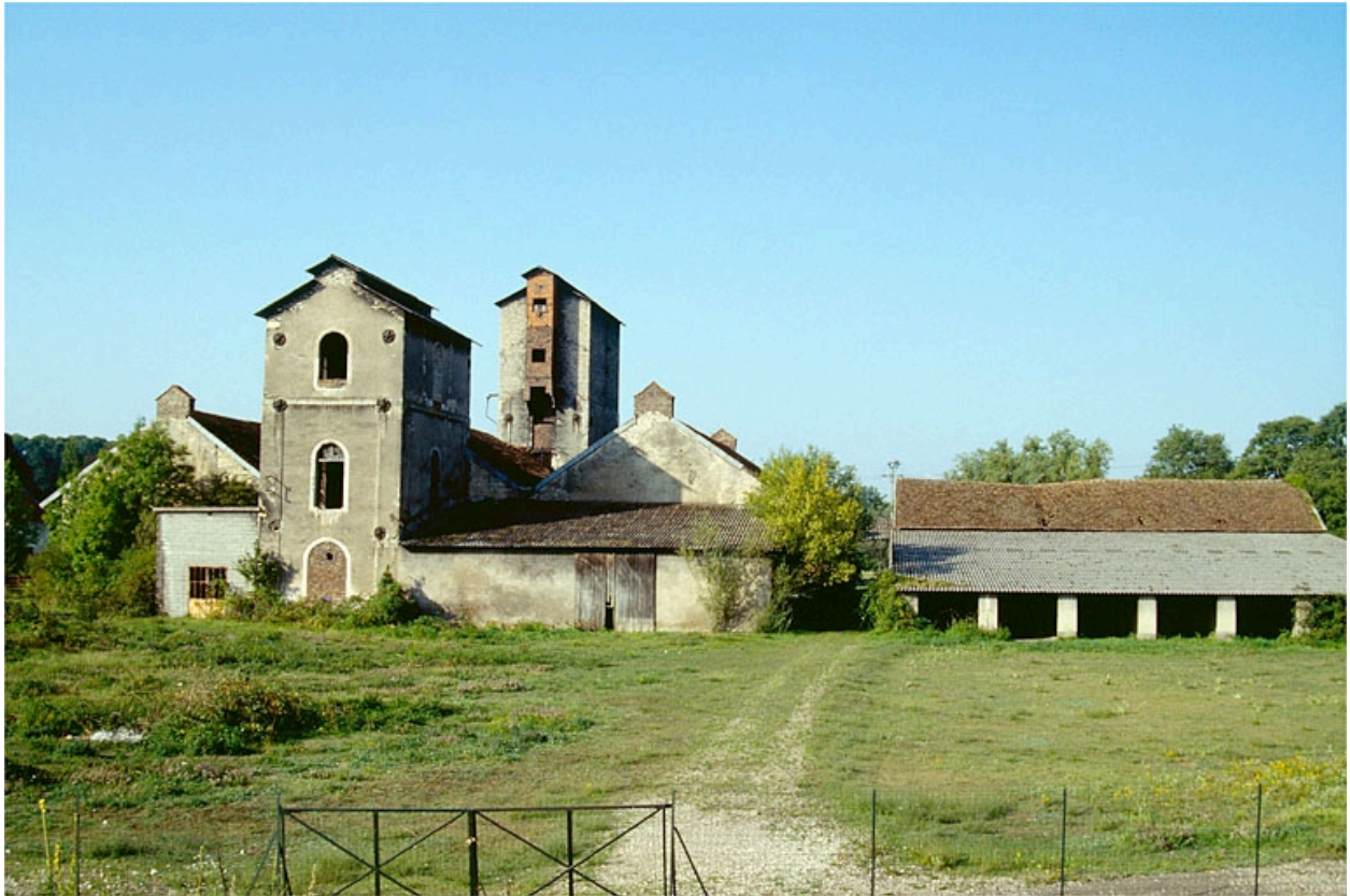
Vue d'ensemble depuis le nord : atelier de fabrication et remise (B).
