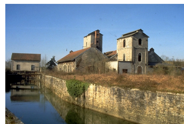
Vue d'ensemble depuis l'est : centrale hydroélectrique (G) et atelier de fabrication (E). Phot. Laurent Poupard IVR43_19893900160ZA
