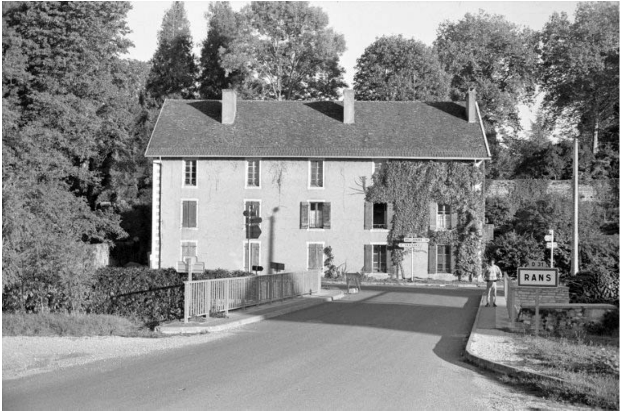
Façade antérieure du logement d'ouvriers (J).
