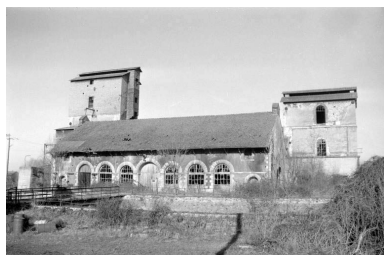
Atelier de fabrication (halle e3) et monte-charge, vus du sud-est. Phot. Laurent Poupard IVR43_19883900260Z
