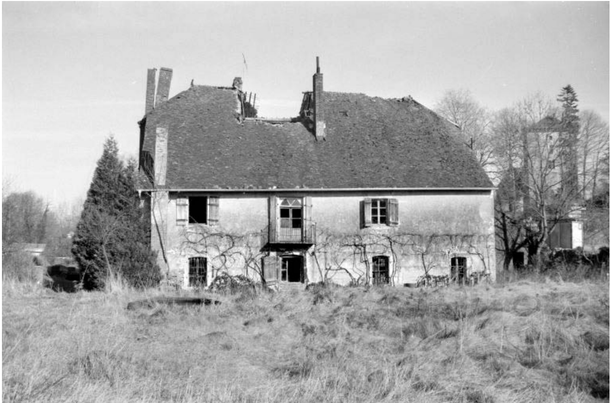
Façade postérieure du logement patronal.
