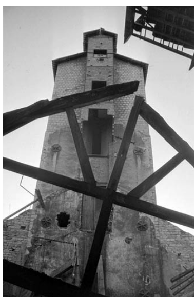
Monte-charge du haut-fourneau au coke (F), vu depuis la halle centrale. Phot. Laurent Poupard IVR43_19883900264Z
