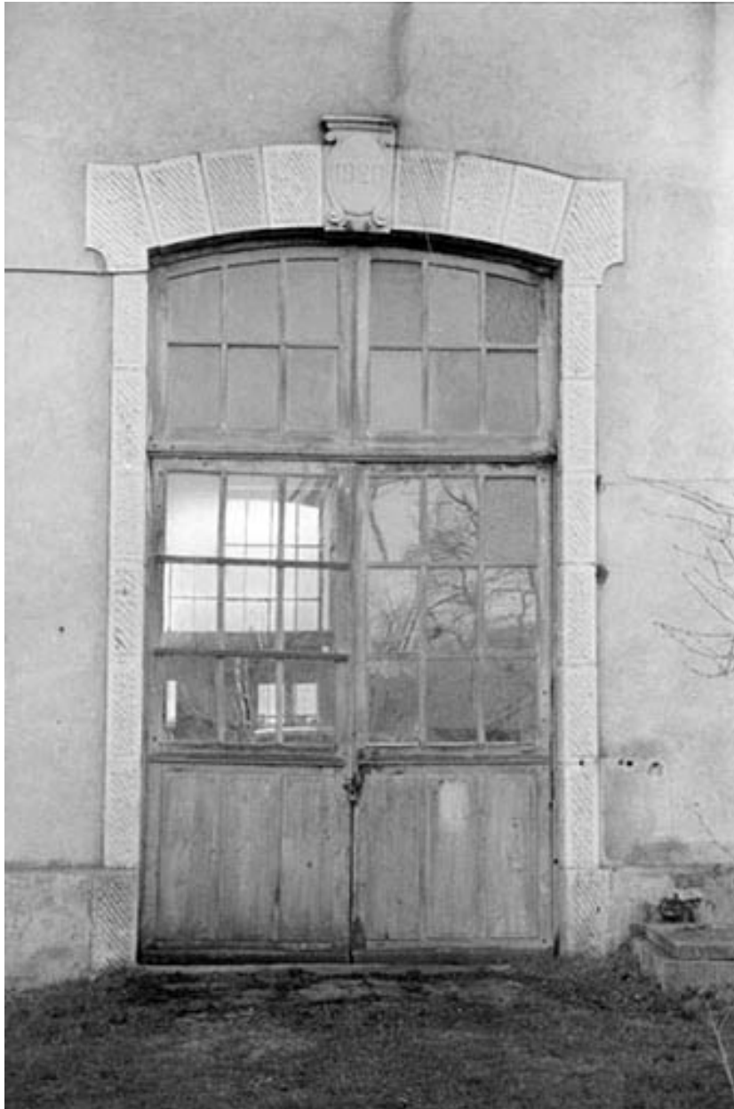
Porte d'entrée de la centrale hydroélectrique.
