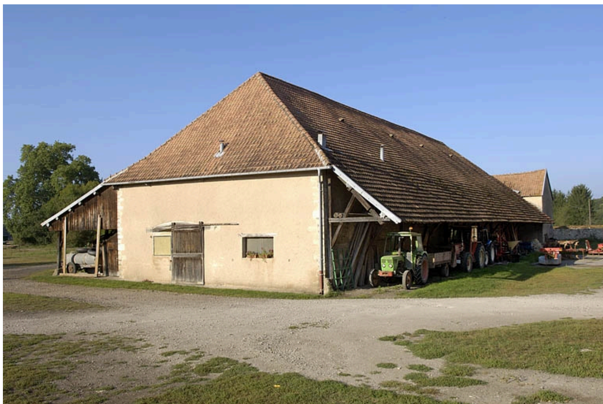
Halle à charbon vue de trois quarts.
