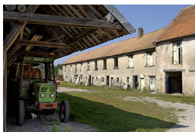
Aile ouest des logements ouvriers. Phot. Jérôme Mongreville IVR43_20057000451NUCA
