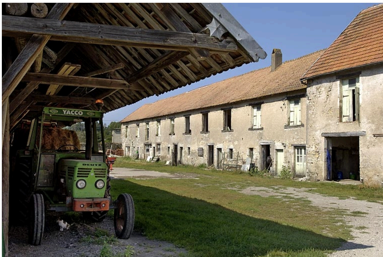
Aile ouest des logements ouvriers.
