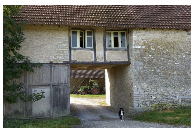
Entrée de l'usine. Phot. Jérôme Mongreville IVR43_20057000464NUCA
