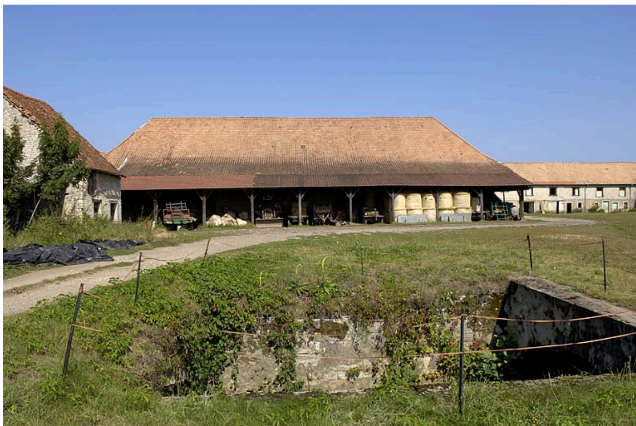
Halle à charbon vue depuis le sud.
