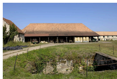
Halle à charbon vue depuis le sud. Phot. Jérôme Mongreville IVR43_20057000450NUCA
