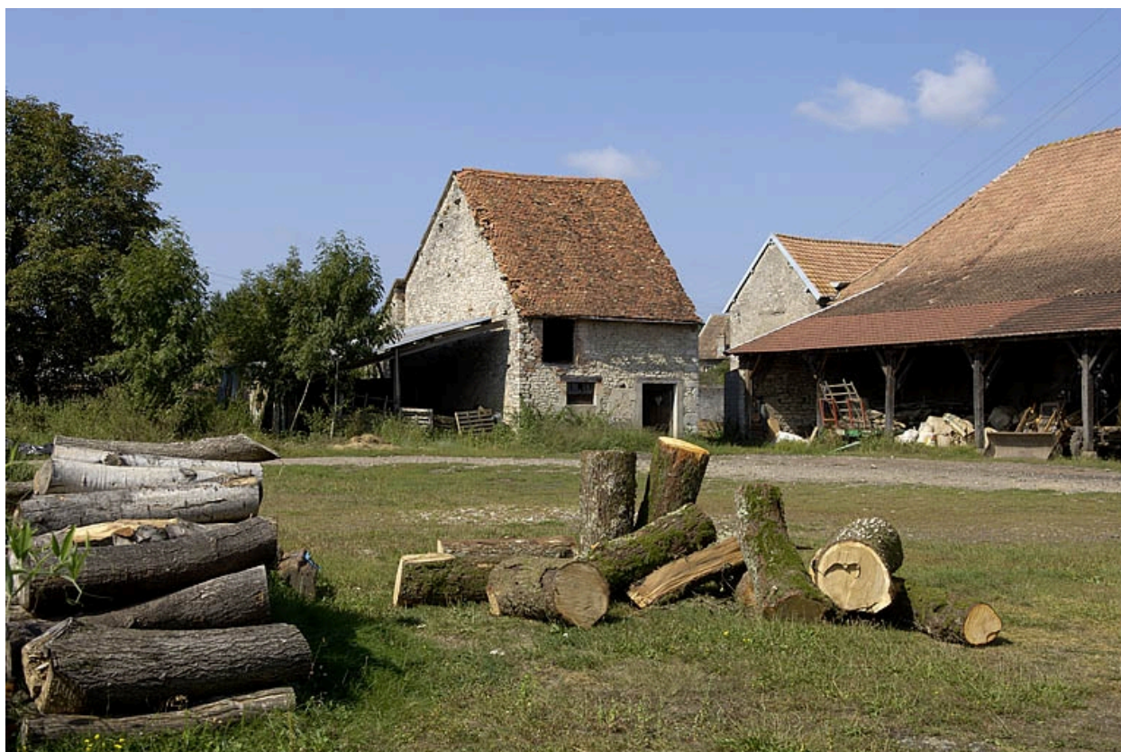
Bâtiments situés à l'ouest de la cour.
