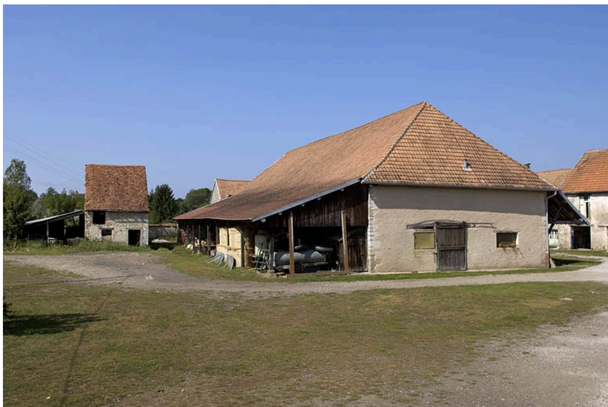
Vue depuis le sud-ouest de la cour.
