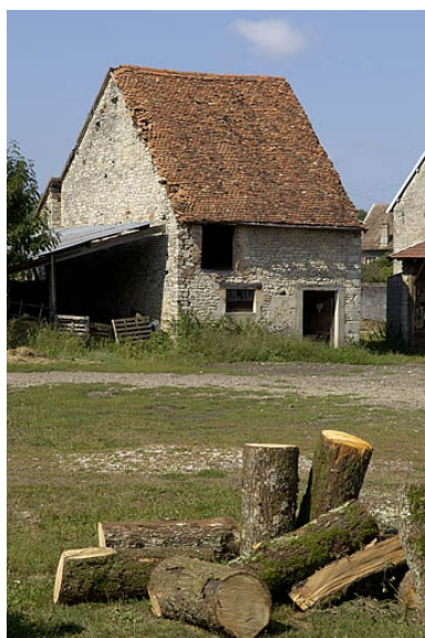
Bâtiment à usage indéterminé. Phot. Jérôme Mongreville IVR43_20057000448NUCA
