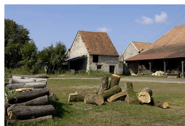
Bâtiments situés à l'ouest de la cour. Phot. Jérôme Mongreville IVR43_20057000449NUCA
