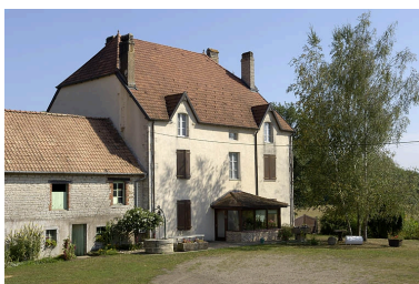
Ancien logement patronal. Phot. Jérôme Mongreville IVR43_20057000460NUCA
