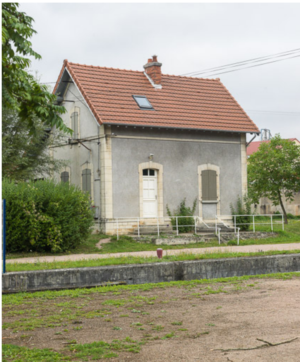
Vue de la maison éclusière.
