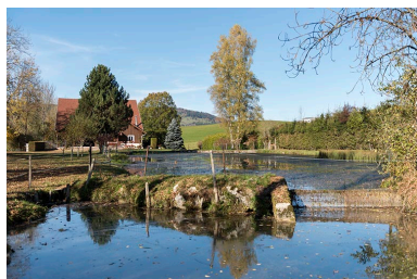
Le bassin de retenue. Phot. Sonia Dourlot IVR43_20172501658NUC4A
