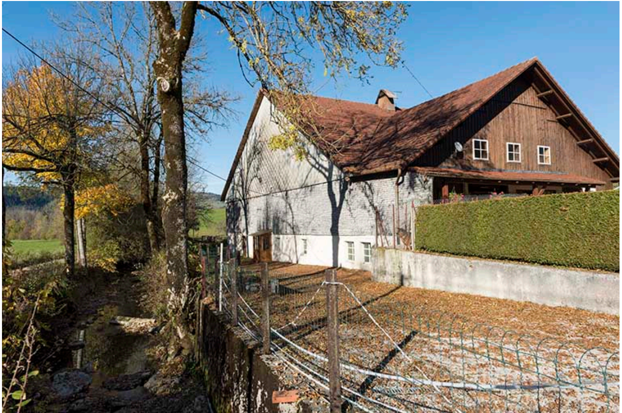
Façades antérieure et latérale gauche (ouest).
