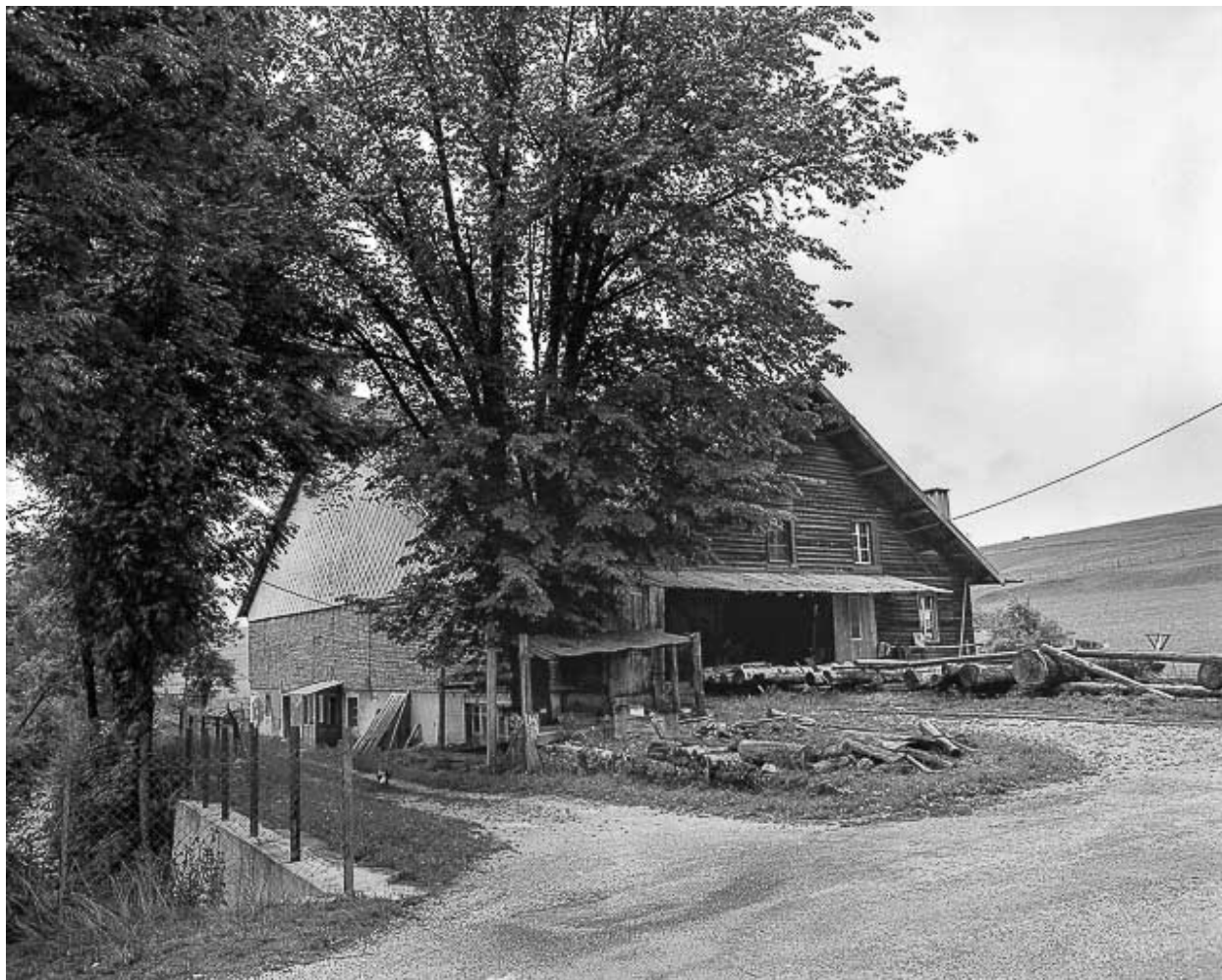
Façades antérieure et latérale gauche, en 1976.
