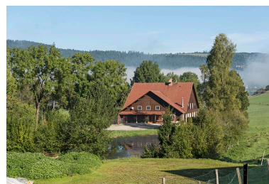
Vue d'ensemble depuis le sud, avec le bassin de retenue. Phot. Sonia Dourlot IVR43_20172501653NUC4A
