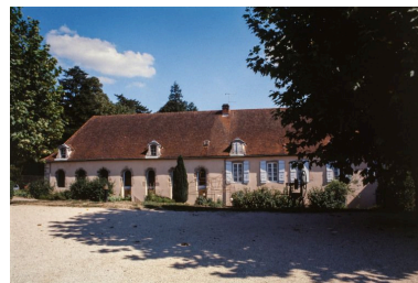
Vue générale de l'ancien hôpital, façade postérieure. Phot. Jean-Luc Duthu IVR26_20012100946ZA
