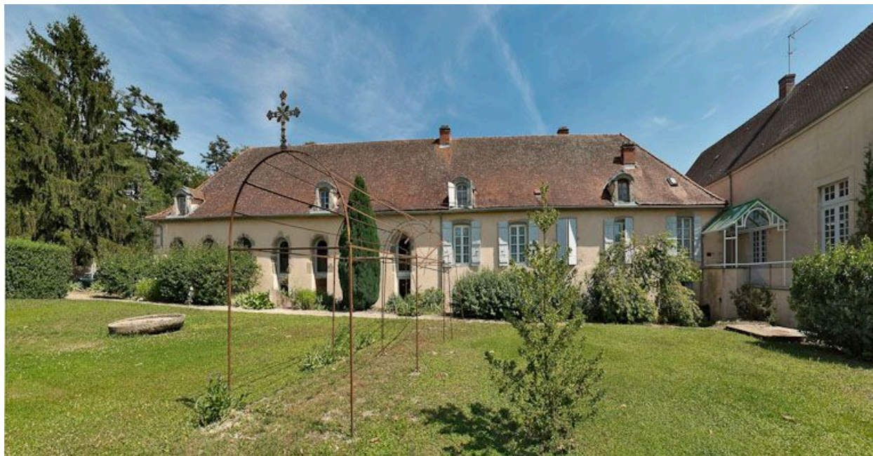
Façade postérieure de l'ancien hôpital.
