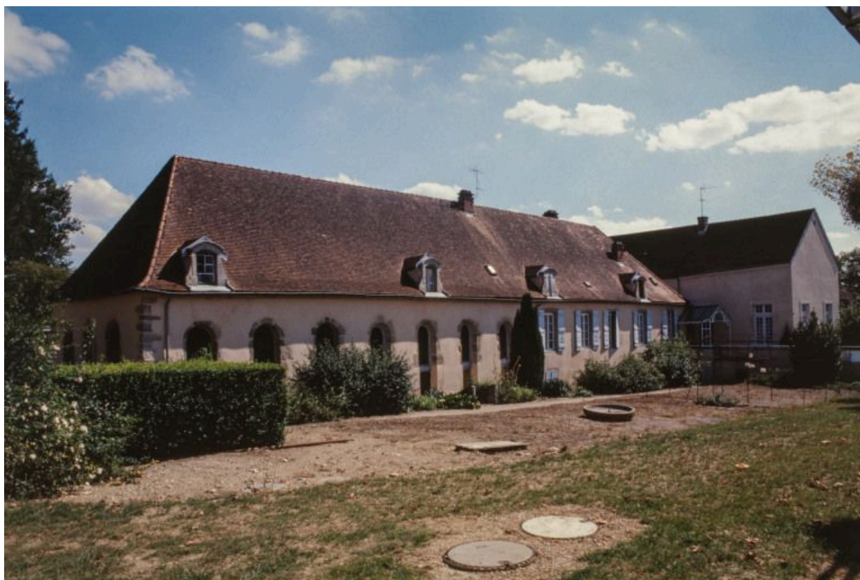
Vue générale de l'ancien hôpital, façade postérieure.
