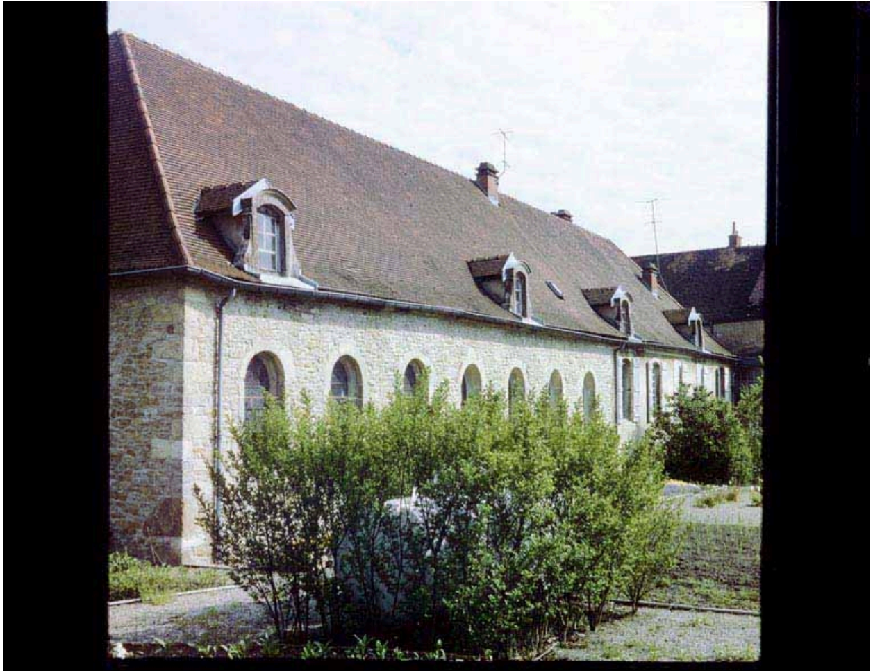
Vue du bâtiment principal.
