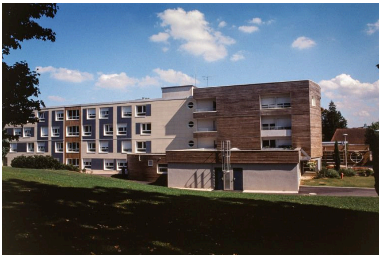
Maison de retraite, élévation latérale.
