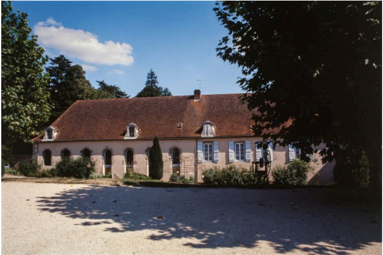
Vue générale de l'ancien hôpital, façade postérieure.
