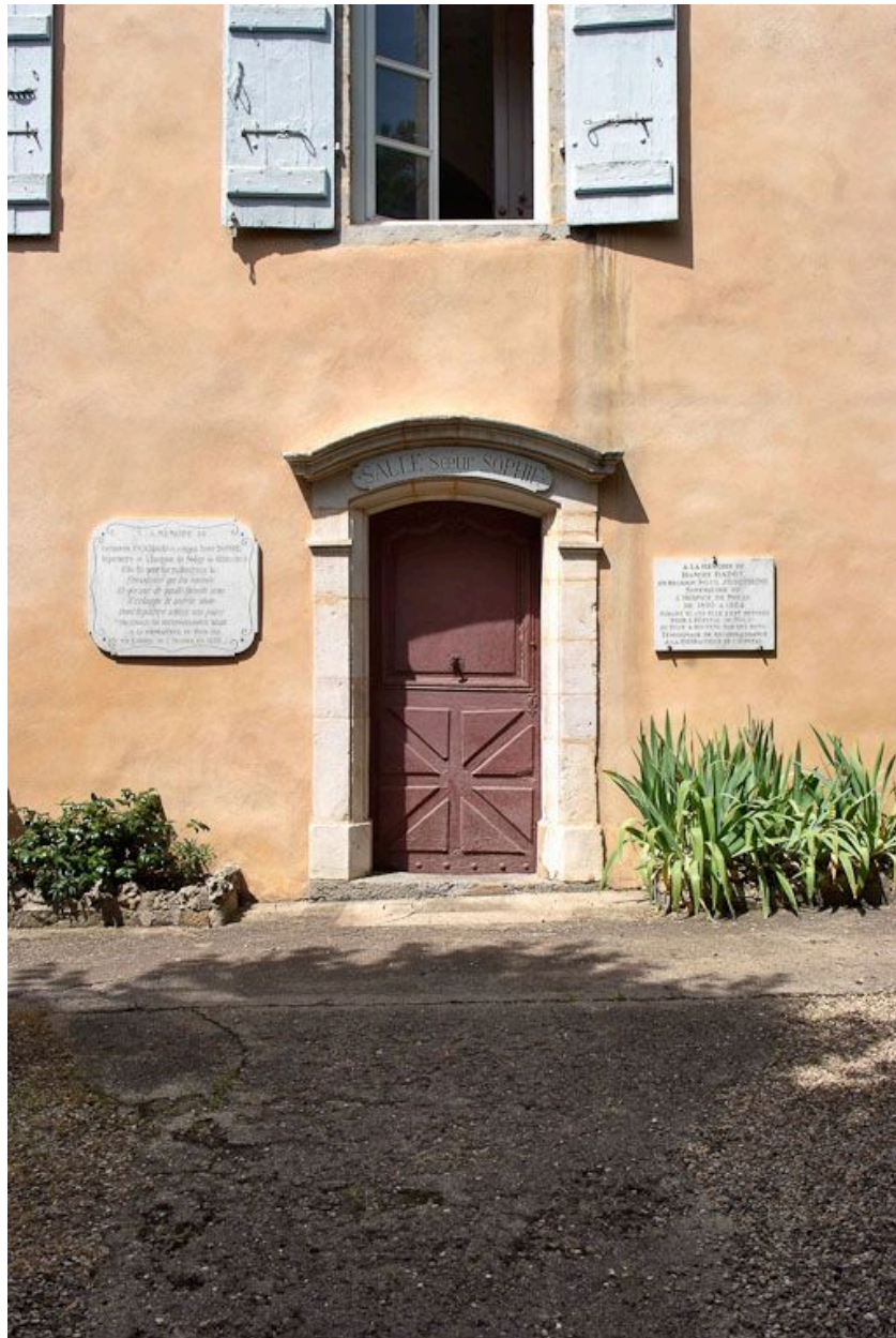
Façade antérieure, détail de la partie centrale.
