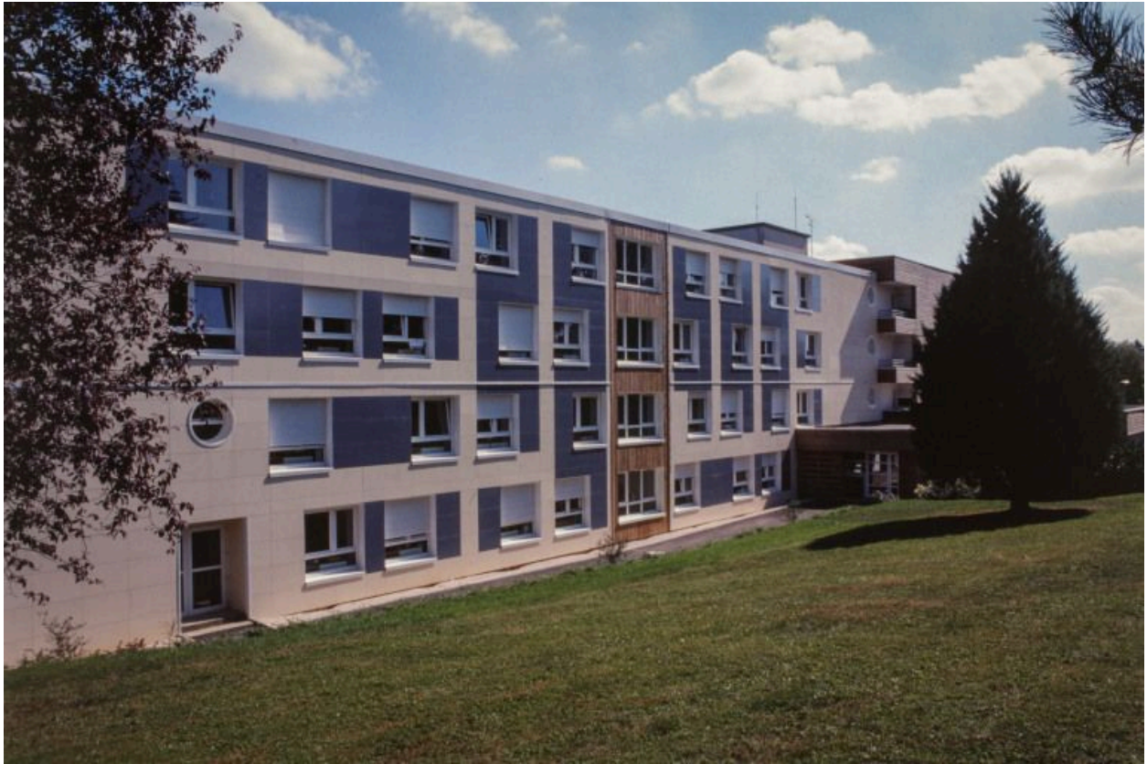
Maison de retraite, élévation latérale.
