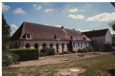
Vue générale de l'ancien hôpital, façade postérieure. Phot. Jean-Luc Duthu IVR26_20012100945ZA
