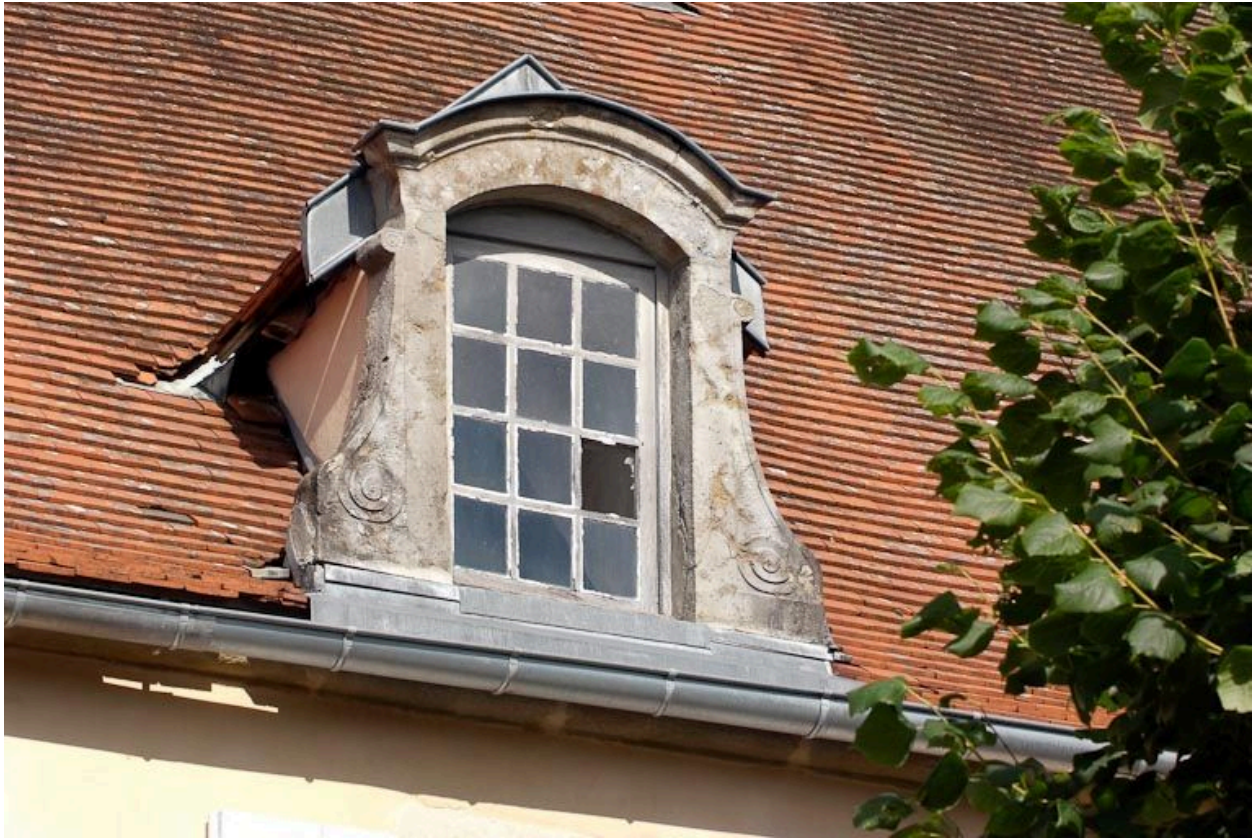
Lucarne de la façade antérieure.
