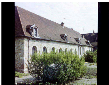
Vue du bâtiment principal. IVR26_19952100035VE
