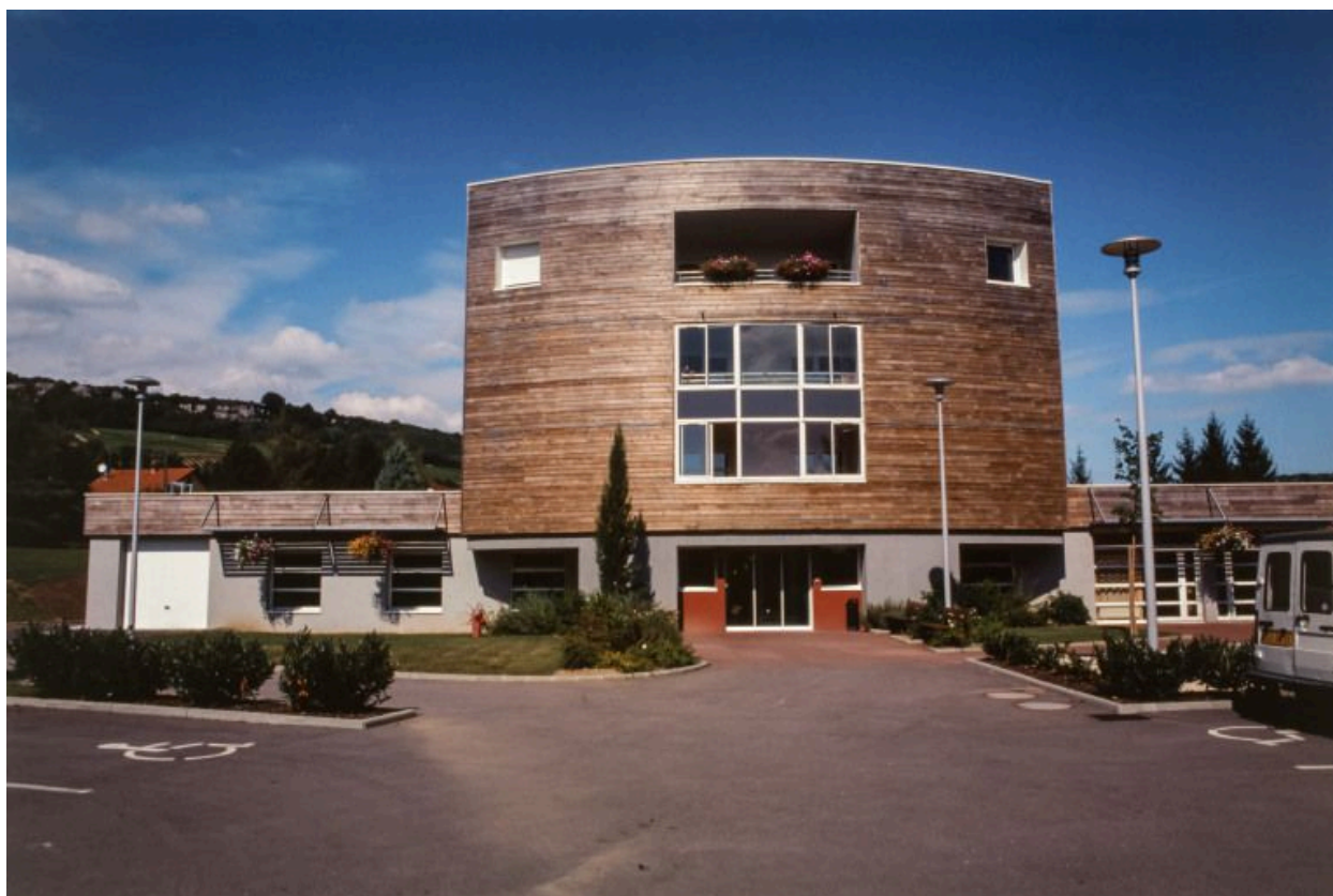
Maison de retraite, élévation antérieure.
