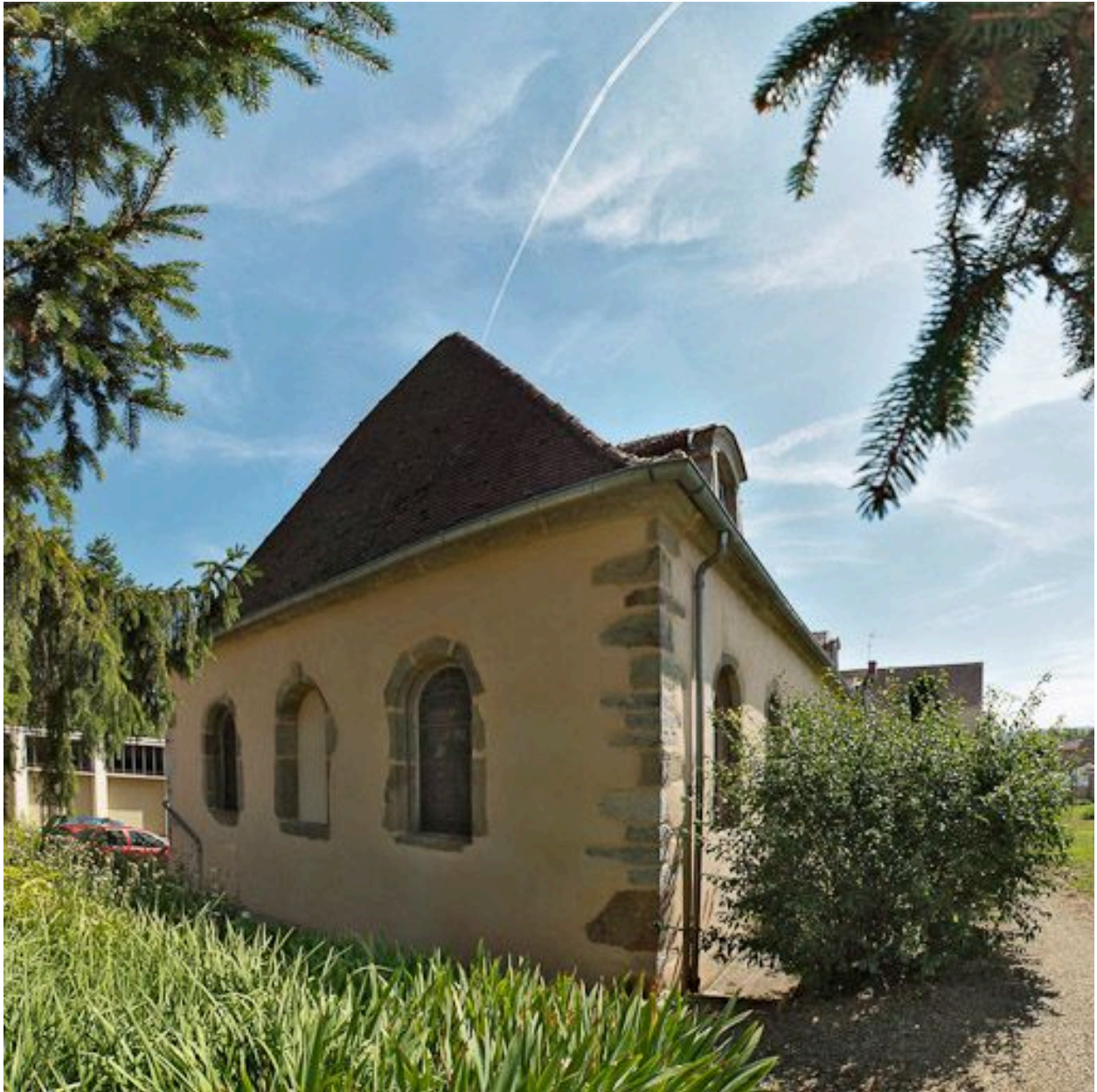
Elévation droite (ancienne chapelle).
