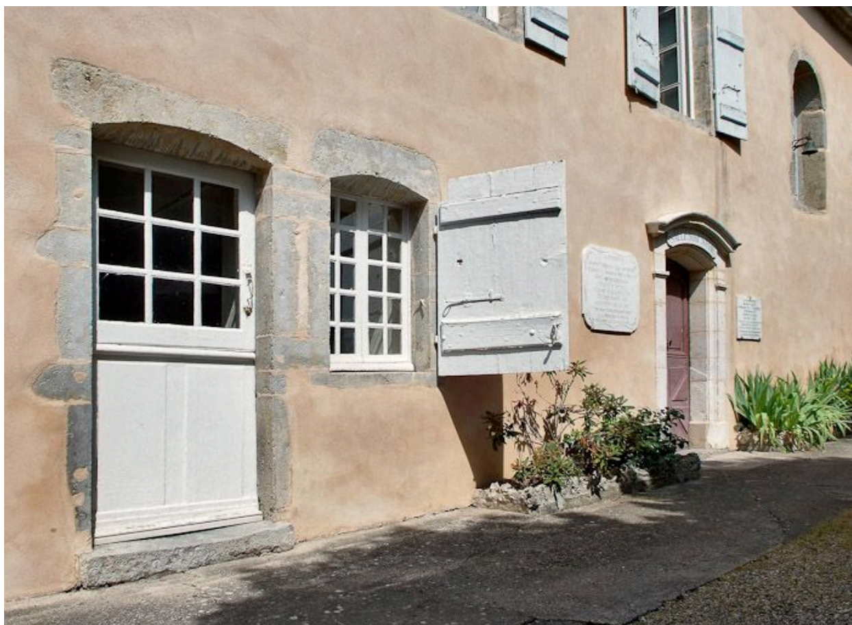
Façade antérieure de l'ancien hôpital, partie centrale.
