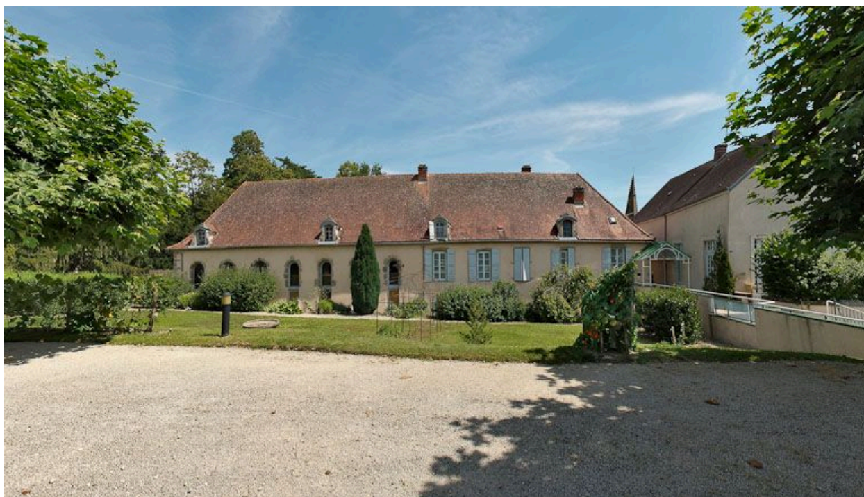
Façade postérieure de l'ancien hôpital.
