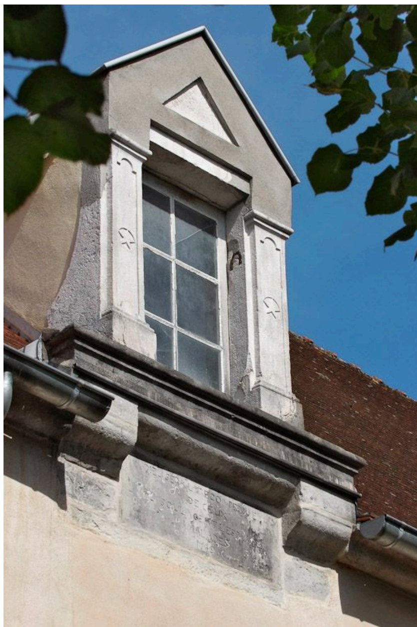
Lucarne située à l'aplomb de la porte de l'ancienne salle des malades.
