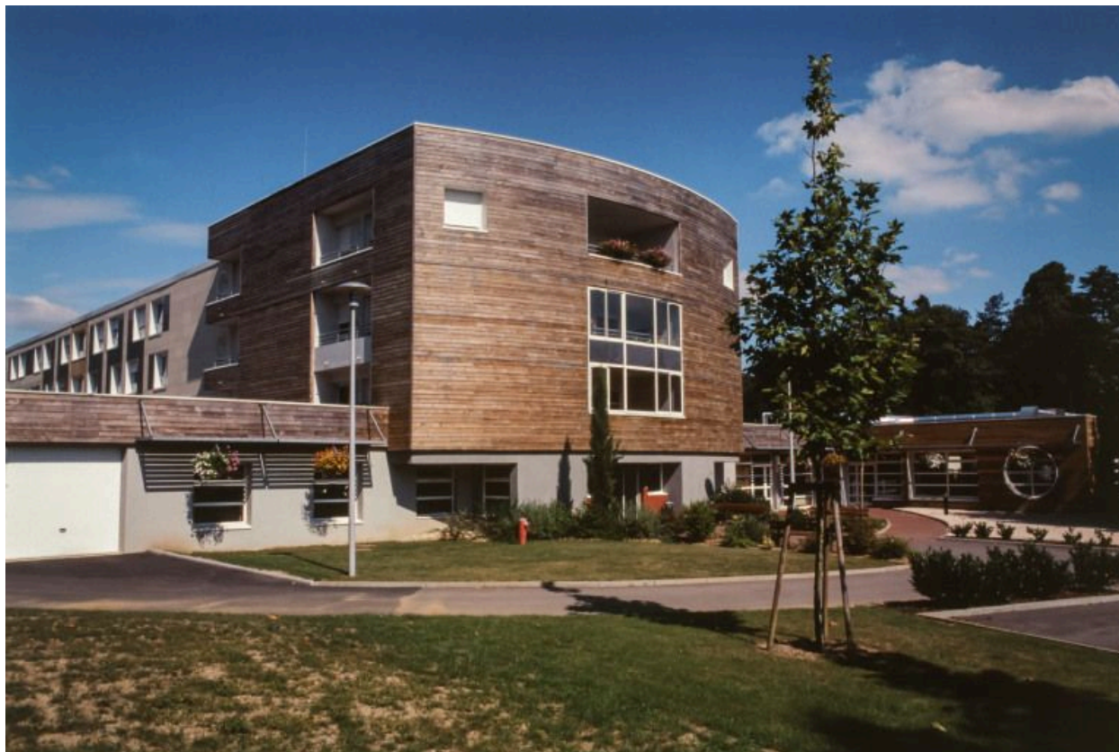
Maison de retraite, élévation antérieure.
