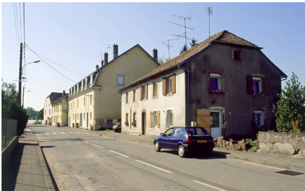
Logements et bureaux depuis la rue d'Andelnans.
