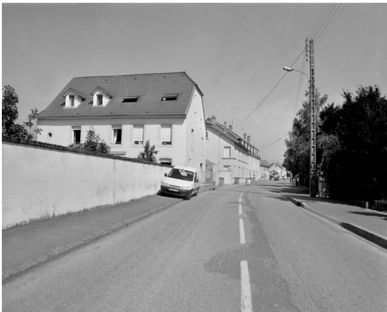
Vue d'ensemble depuis la rue d'Andelnans.
