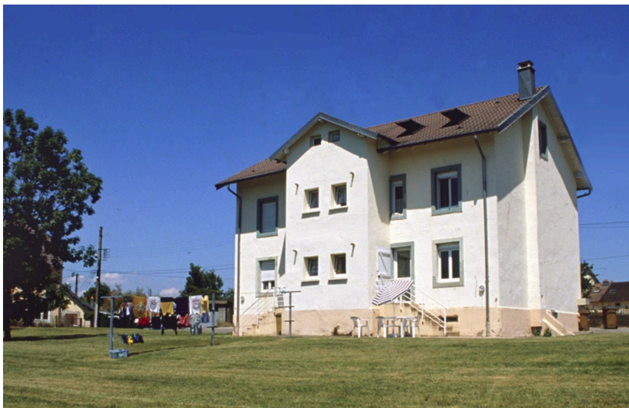
Façade postérieure d'un logement ouvrier.
