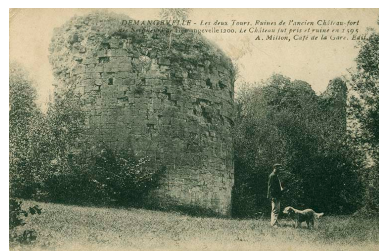
Demangevelle. Les deux tours. Carte postale. Phot. Jérôme Mongreville IVR43_20157000493NUC4A
