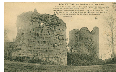
Demangevelle. Les deux tours. Carte postale. Phot. Jérôme Mongreville IVR43_20157000472NUC4A
