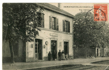
Demangevelle-Vauvillers, la gare. Avant 1909. Carte postale. IVR43_20167000081NUC4A
