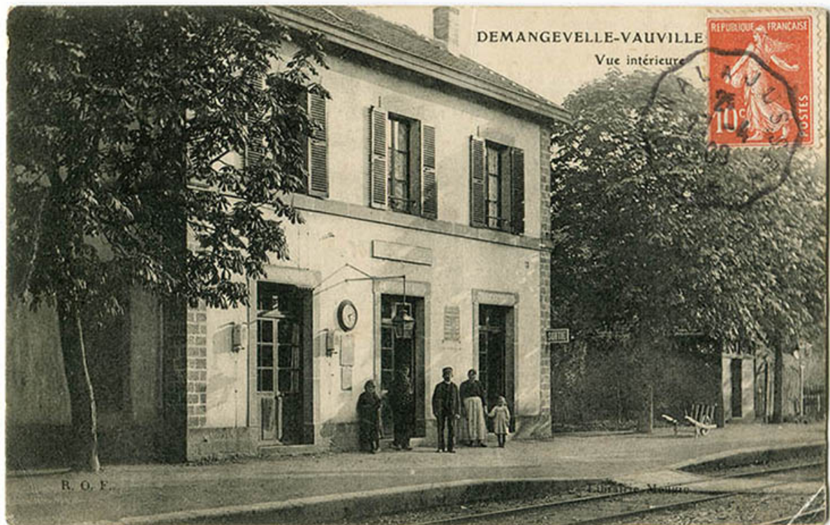
Demangevelle-Vauvillers, la gare. Avant 1909. Carte postale.
