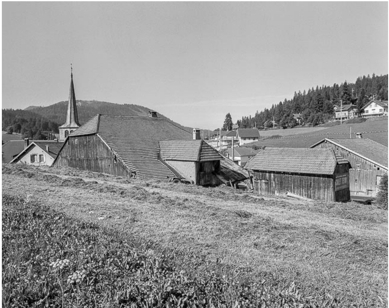
Façades postérieure et latérale gauche.
