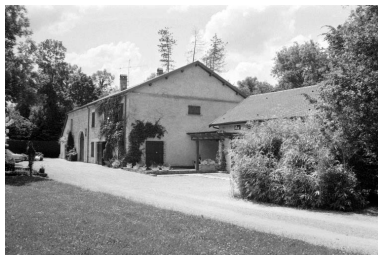
Vue d'ensemble, depuis l'entrée. Phot. Laurent Poupard IVR43_19883900560Z
