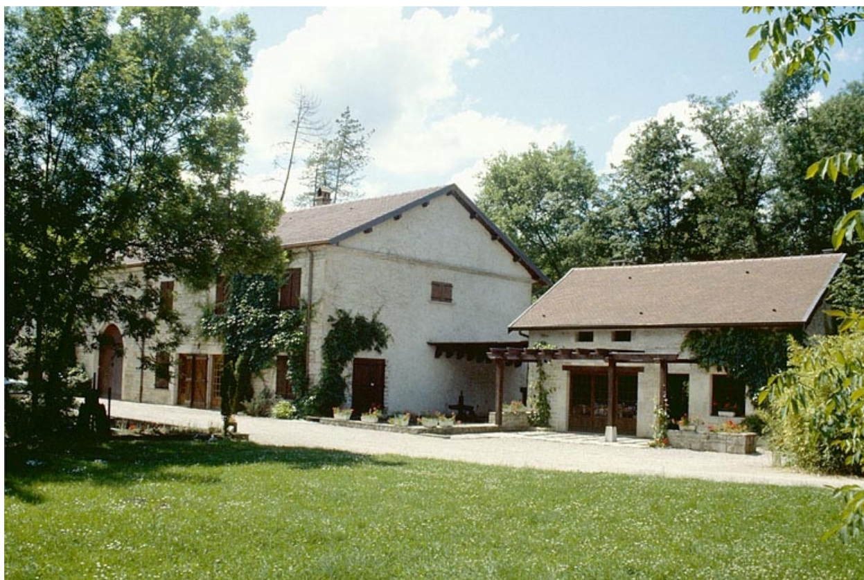
Logement patronal, bâtiment d'eau et ancienne scierie.
